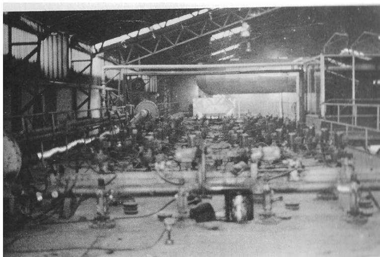
Foto 5.1.-g Vista parcial de los mecheros de fuel-oil de alimentación del horno túnel Fuente: Begoña Cernuda Vergara "Industrialización Rural: Cobeja de la Sagra Toledo" 1985.
