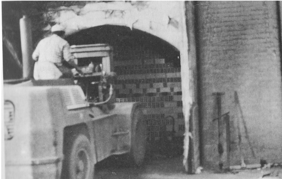
Foto 5.1.-d Carga del horno tipo Hoffman por medios mecánicos.
