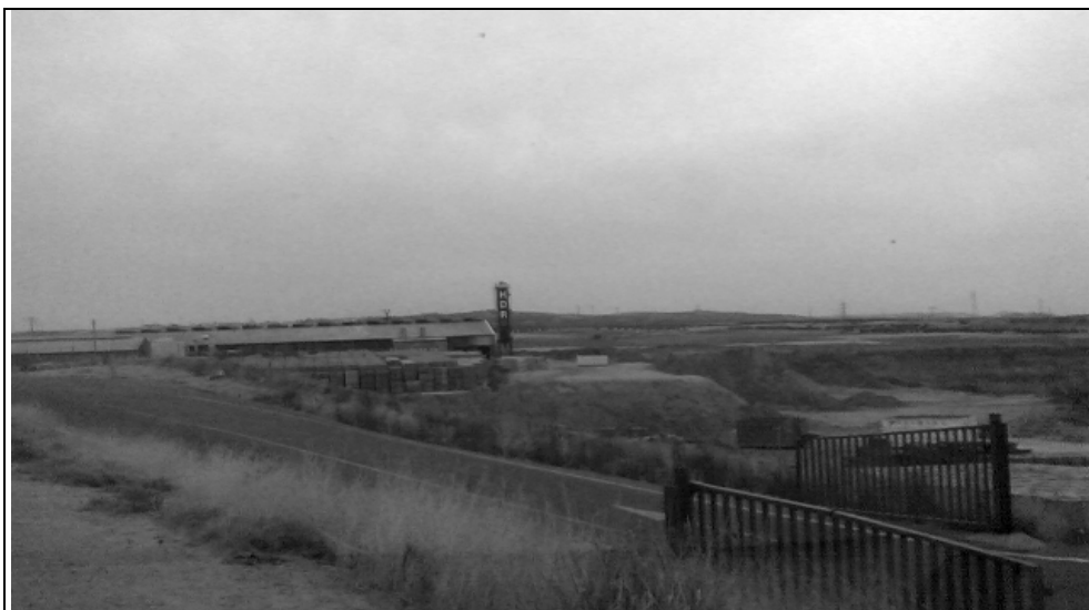
Foto 5.3.1 Vista general de Fábrica desde el inicio de la carretera de Cobeja a Pantoja, en 2009.
