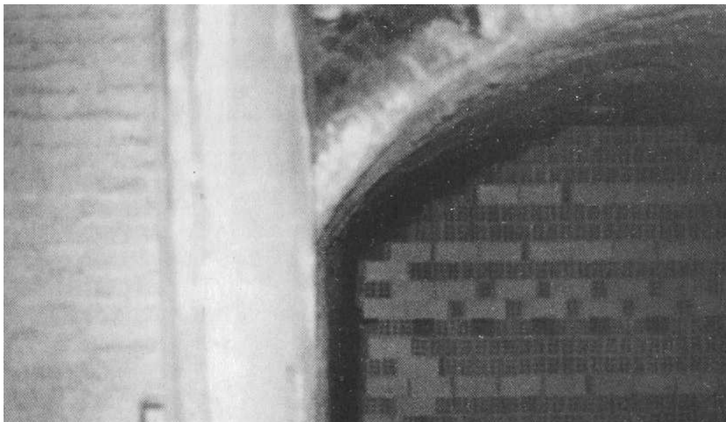
Foto 5.1.-c Vista parcial de boca de horno tipo Hoffman cargado a mano .. Fuente: Begoña Cernuda Vergara “Industrialización Rural: Cobeja de la Sagra Toledo” 1985.
