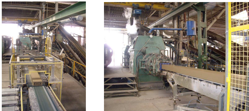
Fotos 5.3.6 y 5.3.7 Zona de extrusión: dos vistas del prisma de arcilla extruido para cortar 2009.
