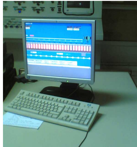
Fotos 5.3.27 y 5.3.28 Dos vista de la sala de control, con el esquema de prehorno y del horno respectivamente, indicando todas las variables del sistema. 2009
