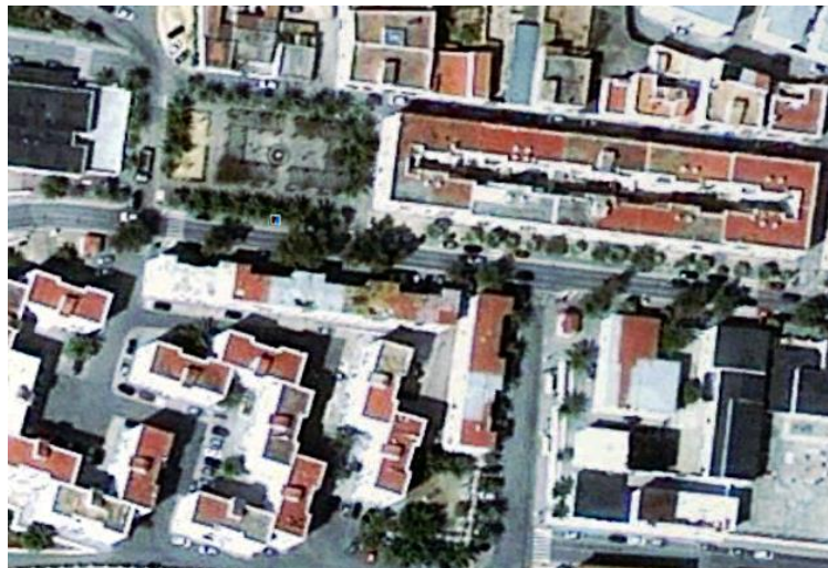
Ilustración 1-12. Vista aérea de los tejados de Vejer de la Frontera (Cádiz).
