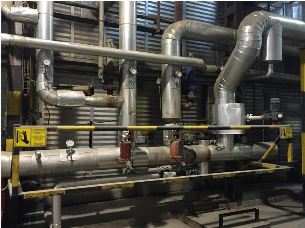
Figura 3.9. Medición de las características del vapor ( $S_f, S_t, S_p$ ) recogidos por el QCS y sistema de distribución y regulación de vapor.
