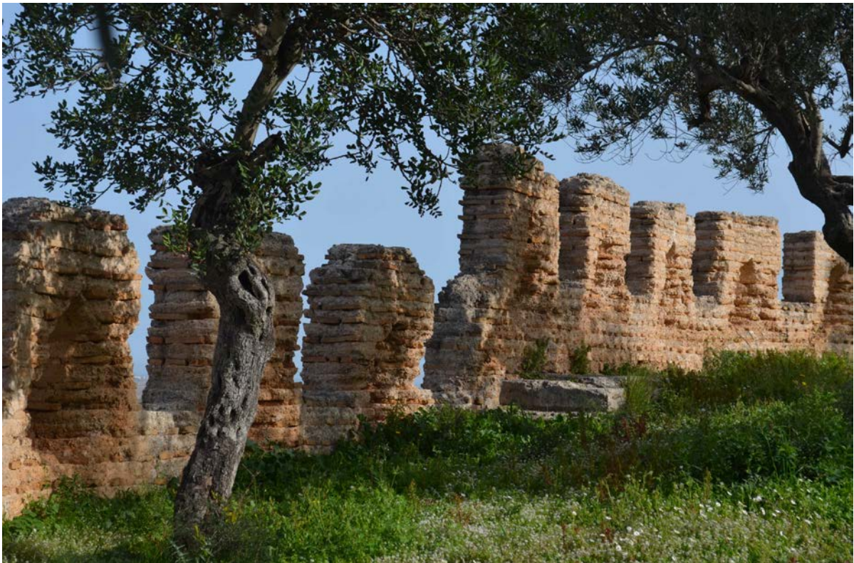
Fig. 186. Murallas realizadas con ladrillos en el castillo de Corbera. Foto del autor.
