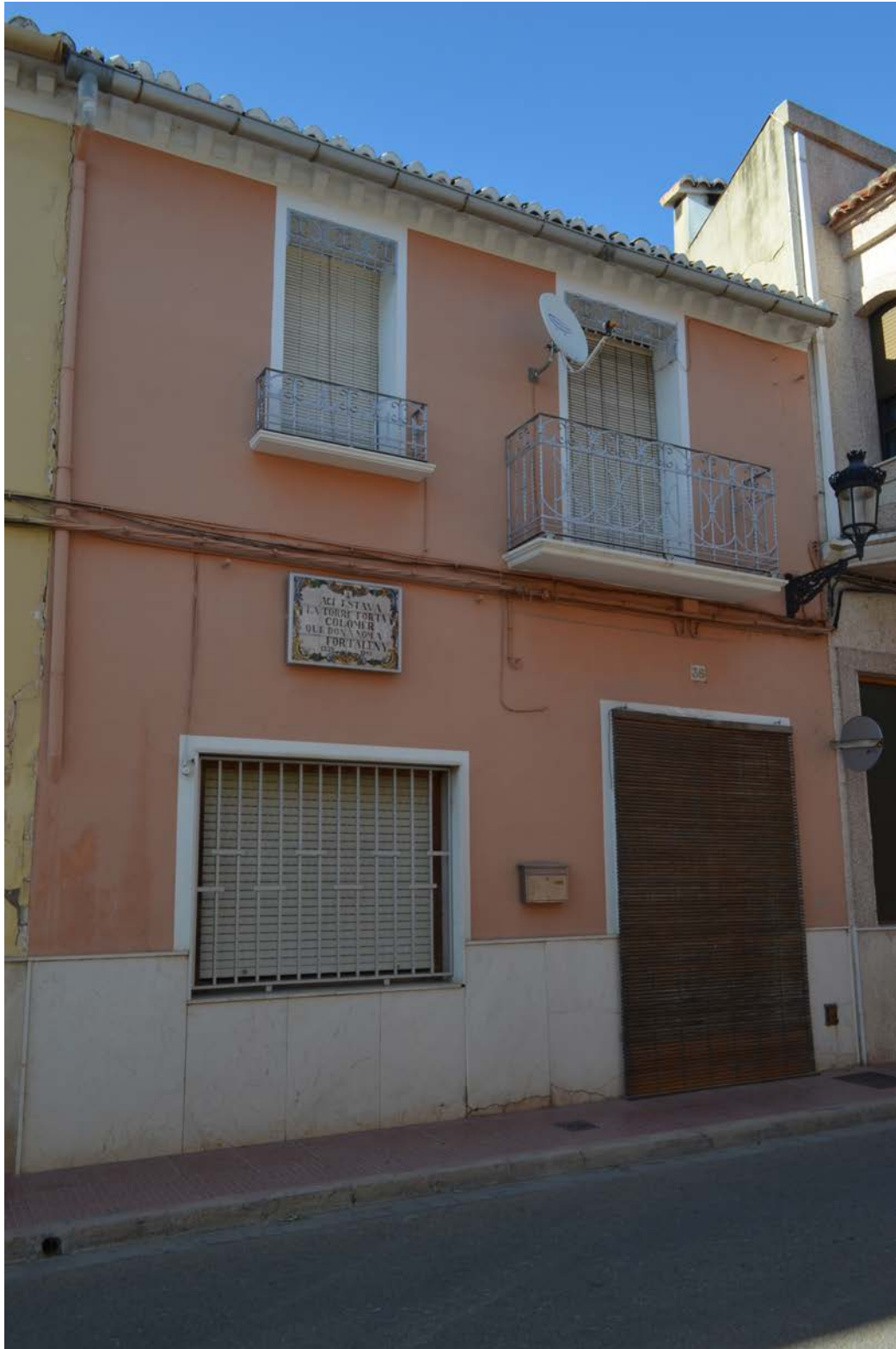
Fig. 162. Casa donde esta la torre de Fortaleny. Foto del autor.
