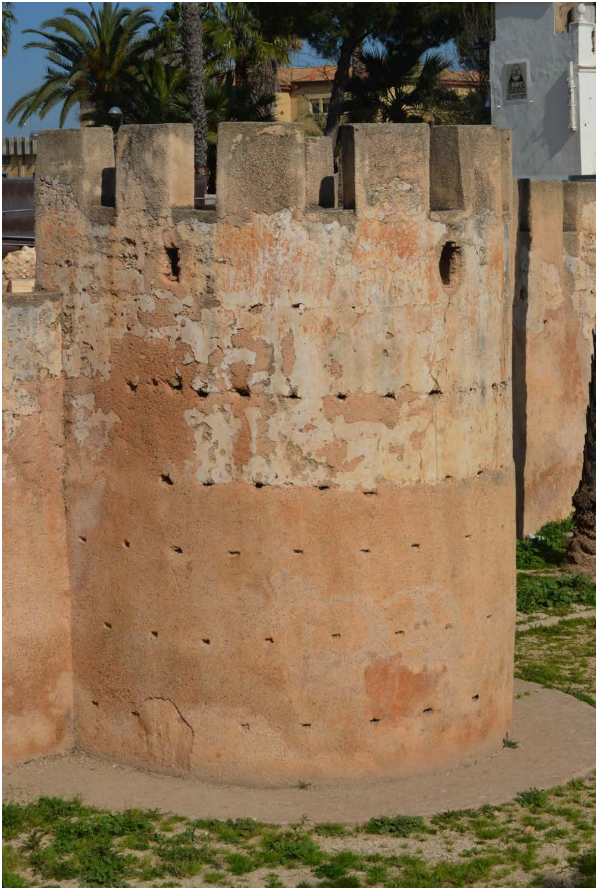
Fig. 33. Torre de las murallas de Alzira. Foto del autor
