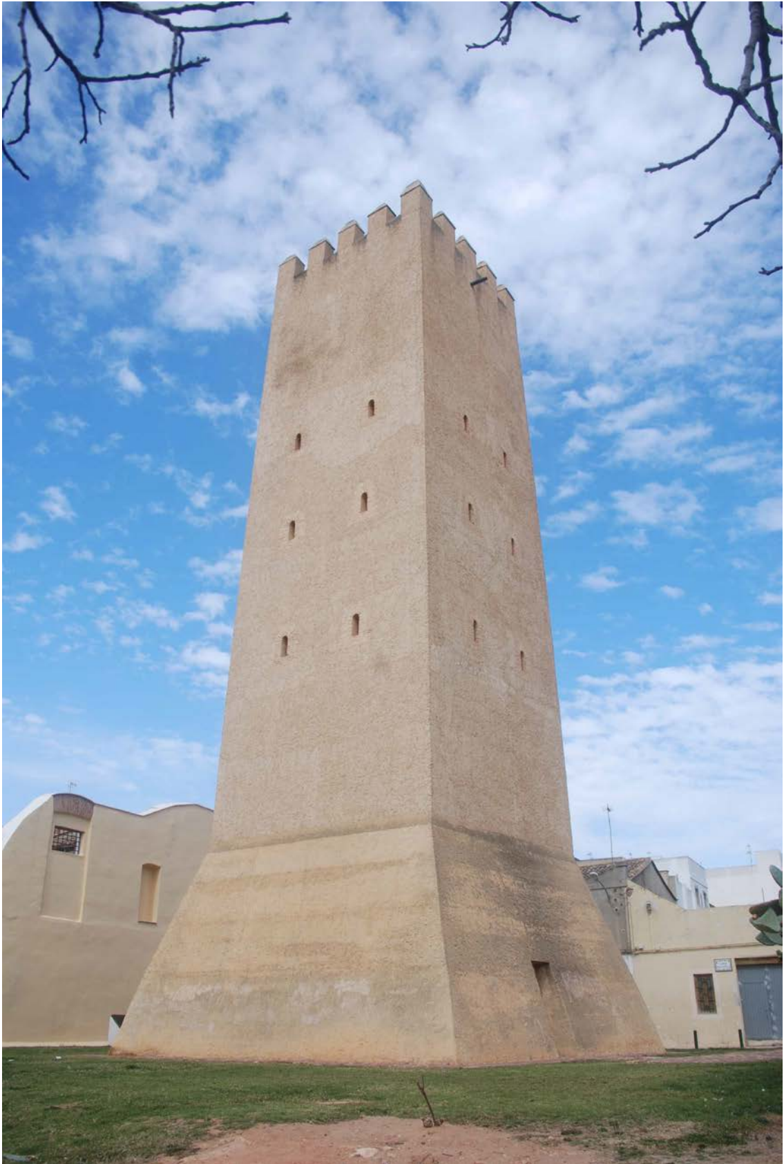
Fig. 128. Torre de Almussafes o Torre Racef.
