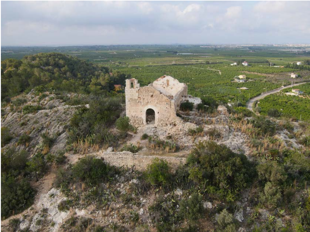
Fig. 139. Torre con muro diafragma central e iglesia. Foto del autor. Dron Francisco Mestre y Salvador Bellver.
