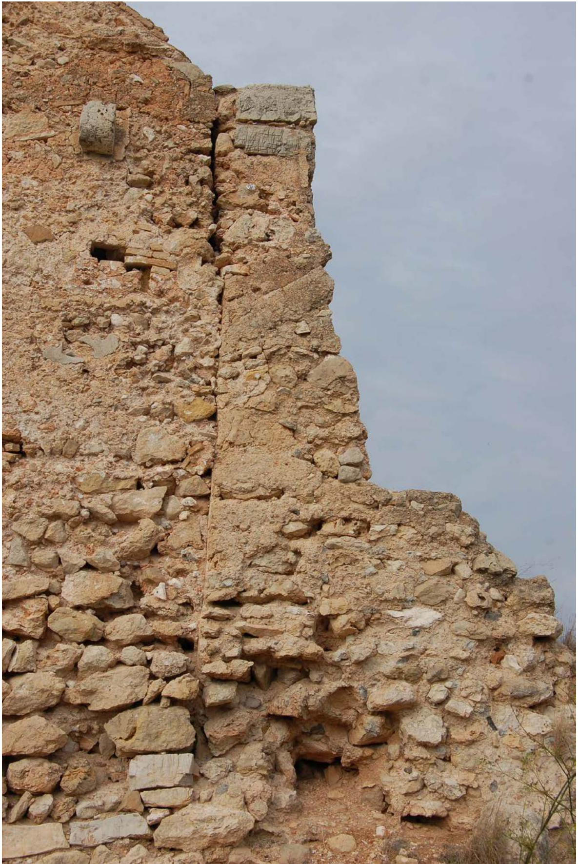
Fig. 138. Fachada de la iglesia adosada al muro de la torre andalusí. Foto del autor.
