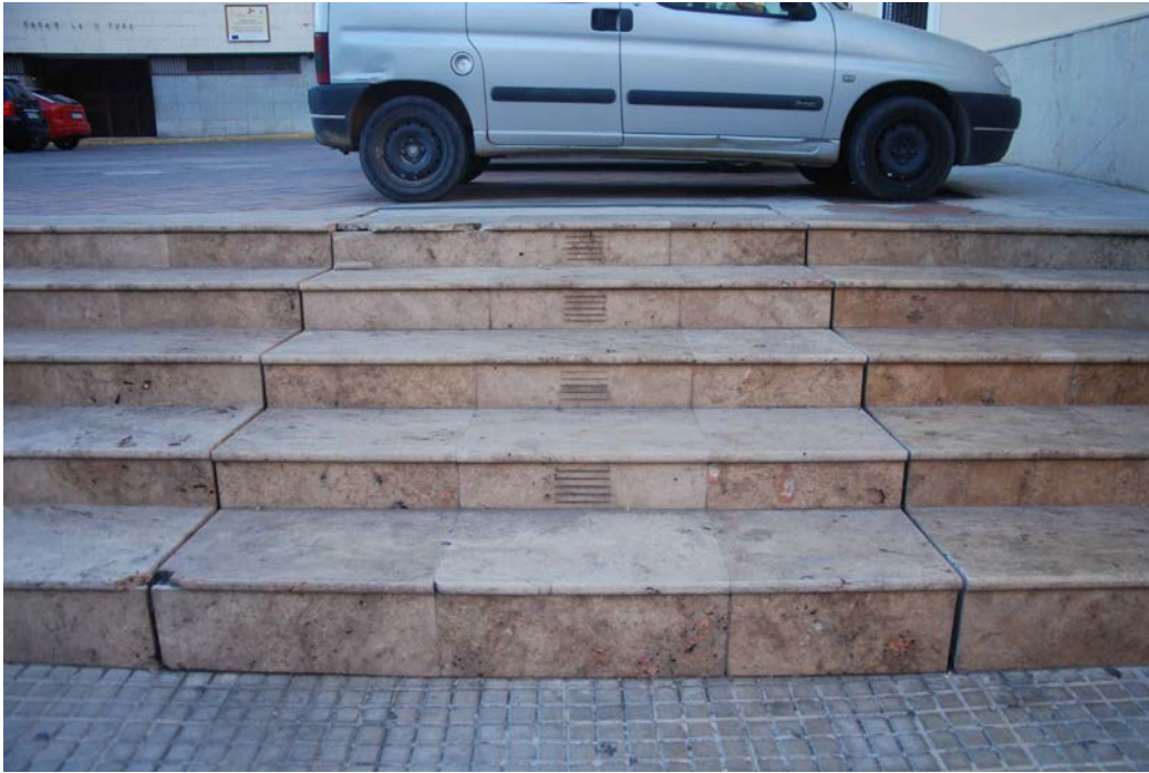
Fig. 148. Puerta de acceso al aljibe del castillo, disimulada con la escalera de la nueva plaza. Foto del autor.
