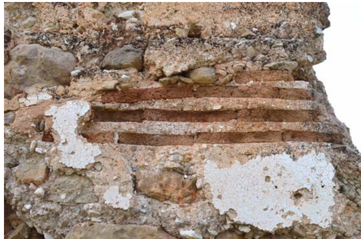
Fig. 179. Reparaciones con ladrillos en el Castillo de Corbera
