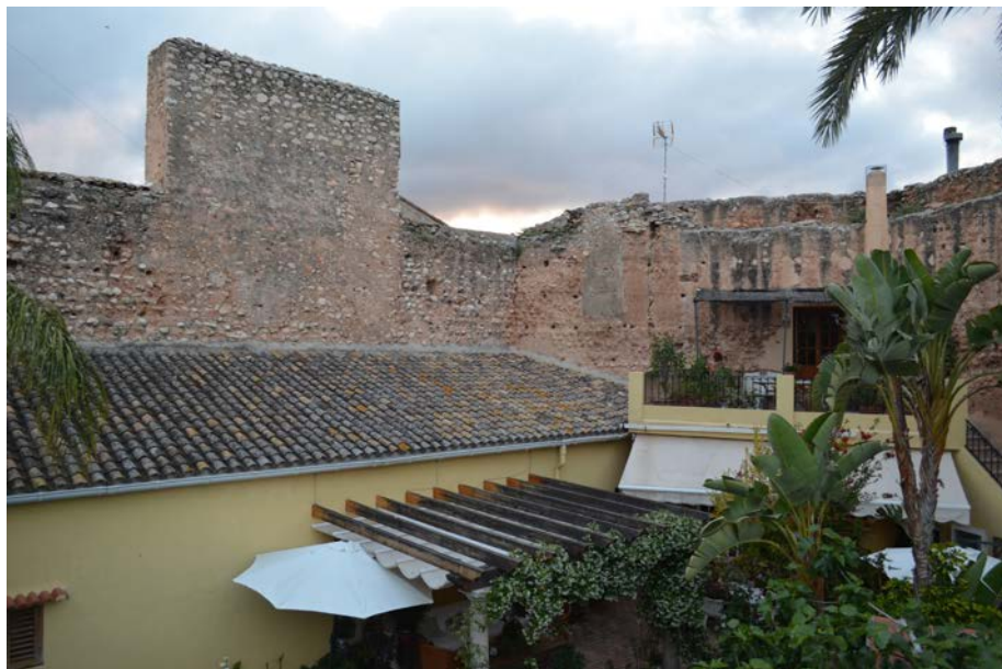
Fig.158 y 159. Murallas de la torre o castillo de Catadau que asoman sobre las casas. Fotos del autor.
