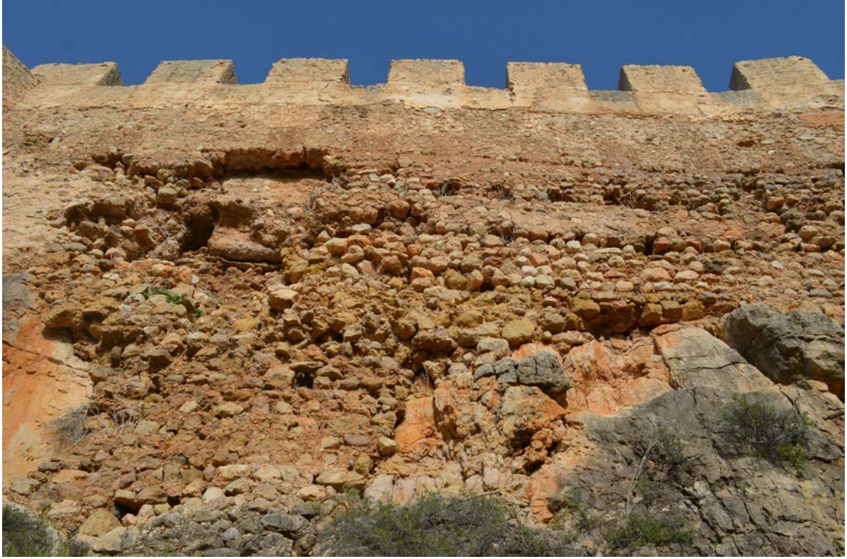
Fig. 180. Erosión, desprendimiento del material, descarnado de los muros. Fases constructivas diferentes, hiladas de almenas. Castillo de Corbera.
