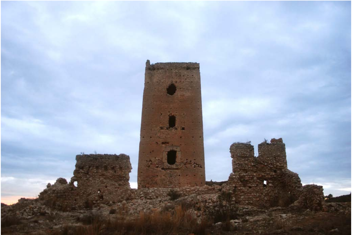
Fig. 106. Fachada principal de la torre de Alèdua con su entrada en altura y los muros barbicanes. Foto del autor.
