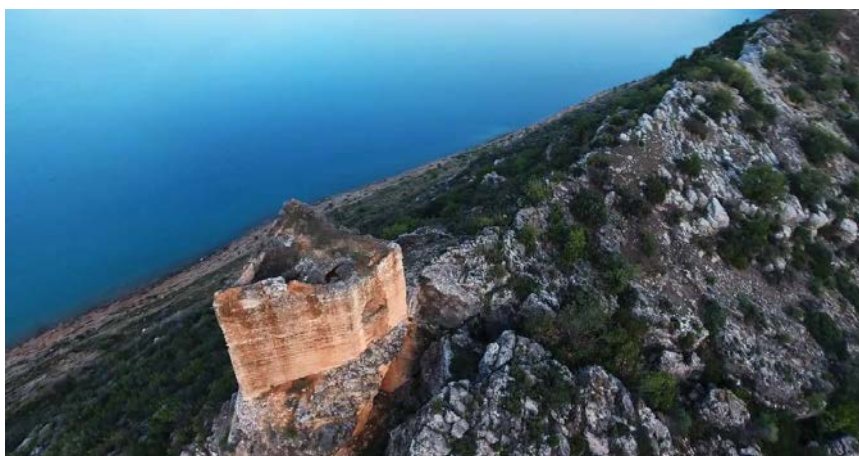
Fig. 70. Castillo de Tous, Torre de vigilancia, separada unos 200 m. De la fortificación principal. Foto del autor. Dron: F. Mestre y S. Bellver
