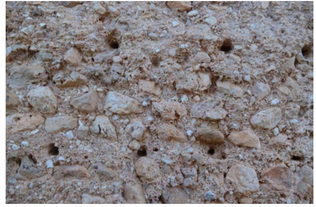
Fig. 175, y 176. Muro de tapial donde se observan los cajones de encofrados, los agujeros de los travesaños y la pérdida de la costra protectora o enlucido. Composición del interior del cajón de encofrado. Castillo de Corbera.
