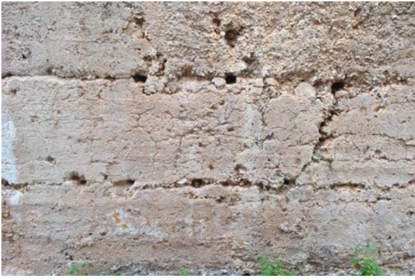
Fig. 175, y 176. Muro de tapial donde se observan los cajones de encofrados, los agujeros de los travesaños y la pérdida de la costra protectora o enlucido. Composición del interior del cajón de encofrado. Castillo de Corbera.
