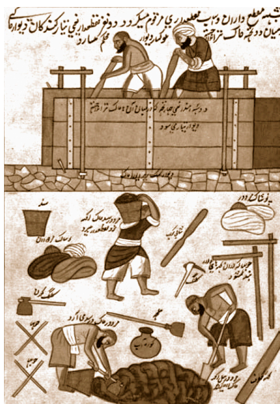
Fig. 174. Fabricación de un muro de tapial 756 .
