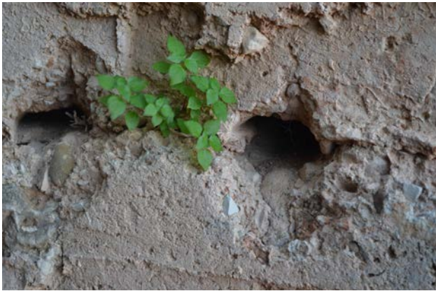
Fig. 177 y 178. Anidación de animales y plantas en los muros y desprendimiento de bloques. Castillo de Corbera
