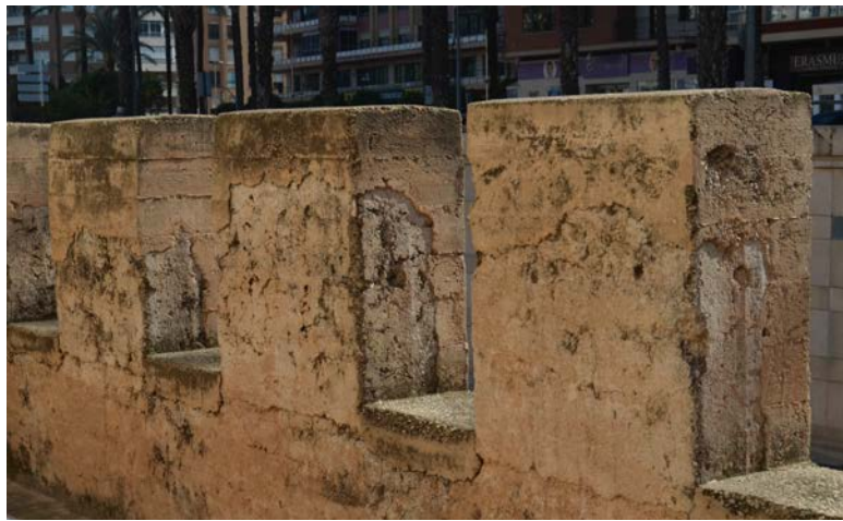
Fig. 40. Almenas islámicas. Foto del autor
