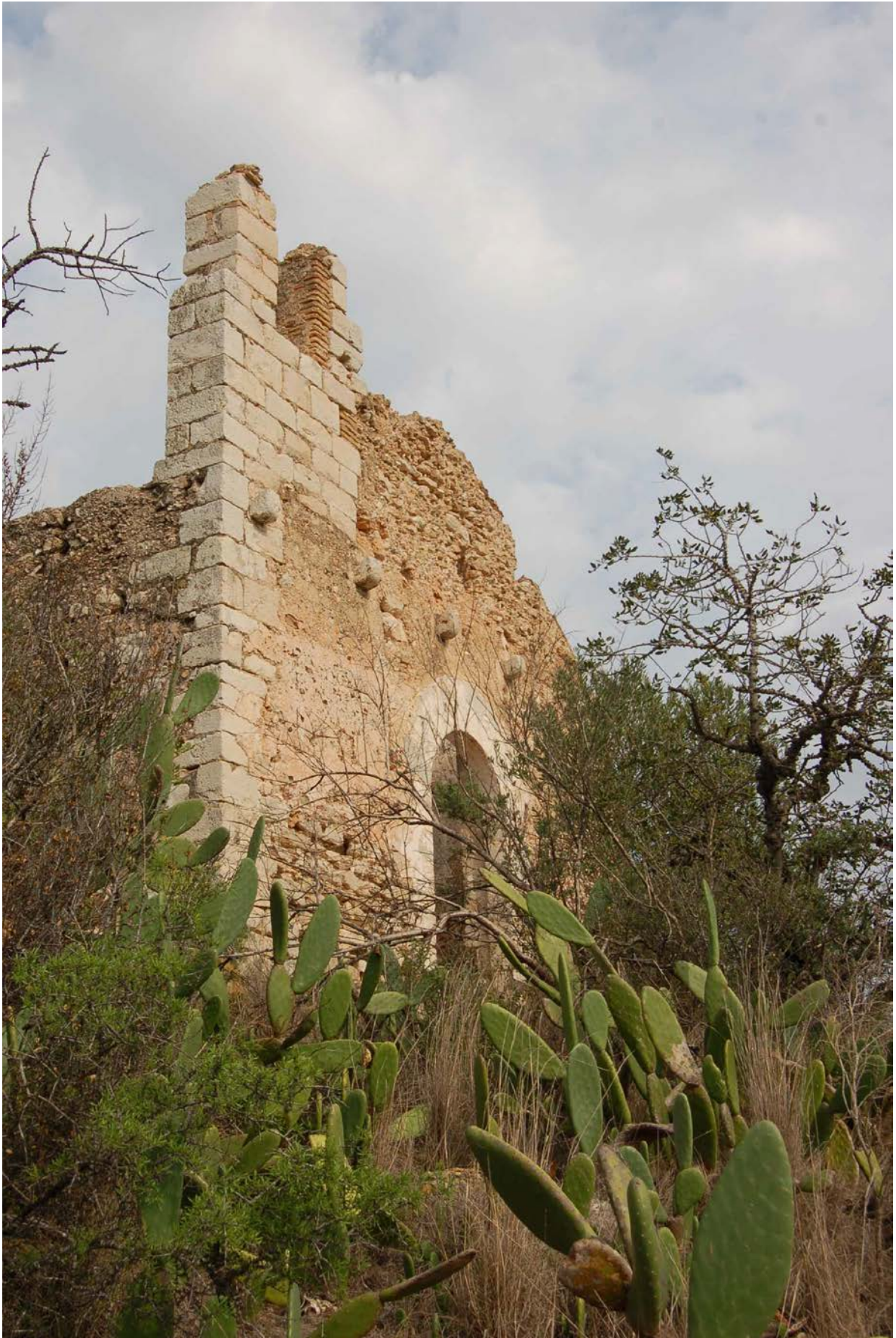
Fig. 137. Iglesia romanico-gótica de Sant Miquel. Foto del autor.
