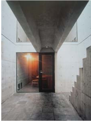
Patio, Row House de Tadao Ando, Sumiyoshi, Osaka -Japón- 1975-76. [📷] Architettura del XX secolo . Peter Gössel y Gabriele Leuthäuser, I -2005. Milano: L'Espresso 2006: 494.
