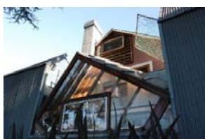
Exterior de la cocina, Casa de Frank Gehry .
