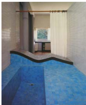
Villa Savoia, Poissy, Francia, 1929-31. [📷] Architettura del XX secolo . Peter Gössel y Gabriele Leuthäuser, I. Milano: L'Espresso , 2006: 233.
