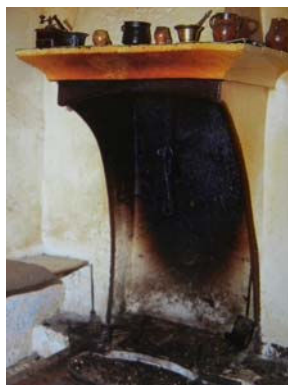
Chimenea elemental, poco eficiente. [📷] Biarge, 2002: 221.
