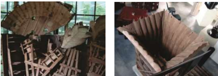
Fig. 118. Dos fotografías con diversos moldes de madera para cimbrar las piezas en concreto aparente en Las Pozas . Museo Edward James, Xilitla. Foto: Autor. 2011.
