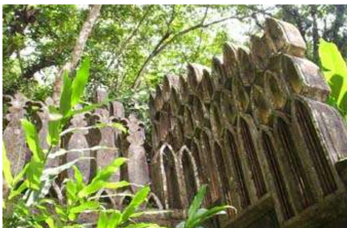
Fig. 225. Detalle de columnas con remate en flor de lis y pared con marcos de arcos apuntados u ojivales que conviven con la vegetación del lugar. Las Pozas , Xilitla, México. 2011.
