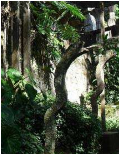
Fig. 170. Dos fotografías (a) y (b). Edward James. Los Siete Pecados Capitales . Detalle de serpientes realizadas en cimbra. Concreto cubierto con piedra de río de la región. Las Pozas , Xilitla, México. Fotografías: Autor. 1999 y 2011. Ubicación en el mapa de la Fig. 164: 10-H, I.
