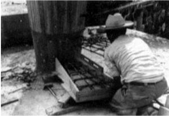
Fig. 126. Detalle de la construcción de los escalones helicoidales que forman parte de la obra El Cinematógrafo . Rancho La Conchita, Xilitla, S.L.P., México. Hacia 1960-1970. Colección privada de la Sra. Otilia Cisneros Vda. de Muñoz.
