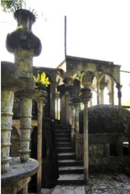
Fig. 202. La bóveda de los murciélagos Hacia 1960-1984. Las Pozas , Xilitla, S.L.P. Autor, 2005.
