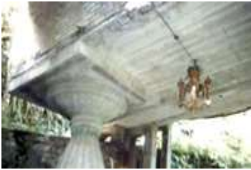
Fig. 218. Detalle de columna gruesa y bulbosa que sostiene una losa con paredes de ladrillo de la región. En el techo de la habitación sin paredes de la planta baja, pende un candelabro que ha perdurado al paso del tiempo. Las Pozas , Xilitla, México. Fotografía: Autor, 2011.
