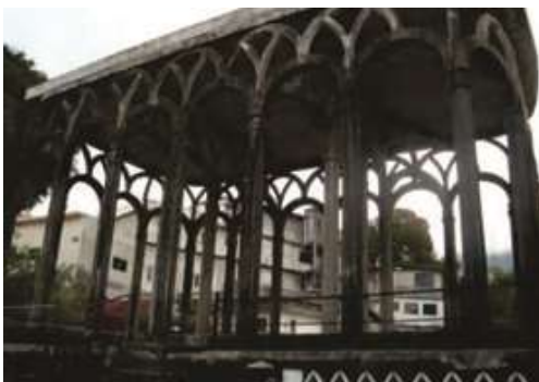
Fig. 38. Detalle de azotea de la Posada El Castillo, 2011.
