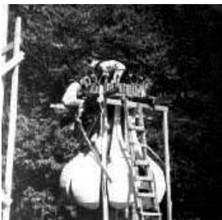
Fig. 203. Detalle de construcción del madroño en concreto. La bóveda de los murciélagos Hacia 1960-1970. Museo Edward James, Xilitla, S.L.P., México.
