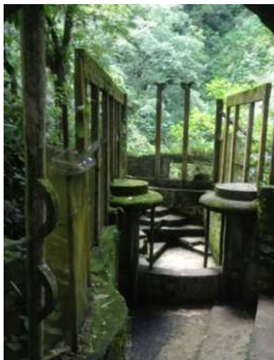
Fig. 226. Detalle de diversas columnas, escaleras y muros realizados en concreto aparente . Las Pozas , Xilitla, México. 2012
