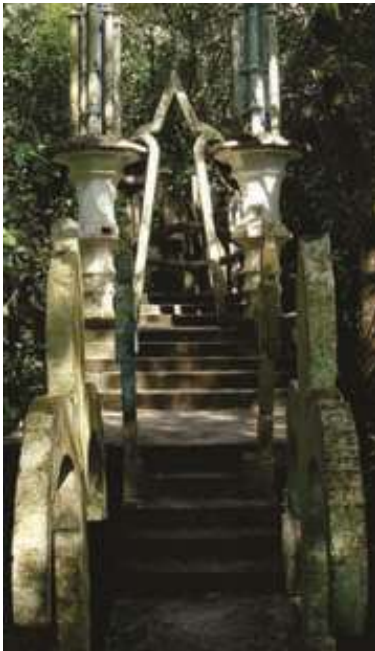
Fig. 178. Detalle de El puente de la fleur-de-lis . Hacia 1962-1980. Concreto aparente Las Pozas , Xilitla. Ubicación en el mapa: 7-H, I. Ver Fig. 164.
