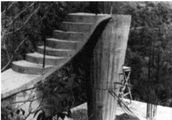
Fig. 127. Construcción de puente-escalera helicoidal que forman parte de la obra El Cinematógrafo . Rancho La Conchita, Xilitla, S.L.P., México. Hacia 1960-1970. Colección privada de la Sra. Otilia Cisneros Vda. de Muñoz.
