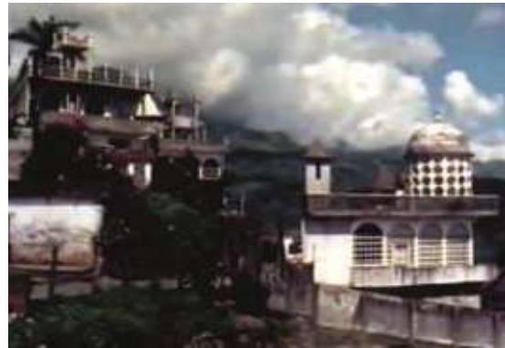
Fig. 45. Detalle de la casa ubicada en la Calle Ocampo núm. 5, Xilitla, S.L.P. México. Hacia 1970.
