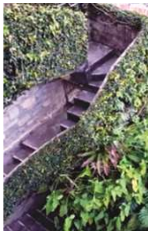
Fig. 36. Detalle de escaleras de la Posada El Castillo, 2011. Foto: Autor.
