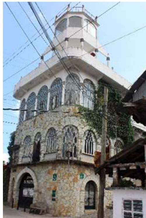
Fig. 41. Esquina de la Posada El Castillo, 2011. La banca de concreto colocada sobre la calle 20 de noviembre y cercana a la cochera, es un recuerdo del Cnel. José Castillo realizada en 1934.
