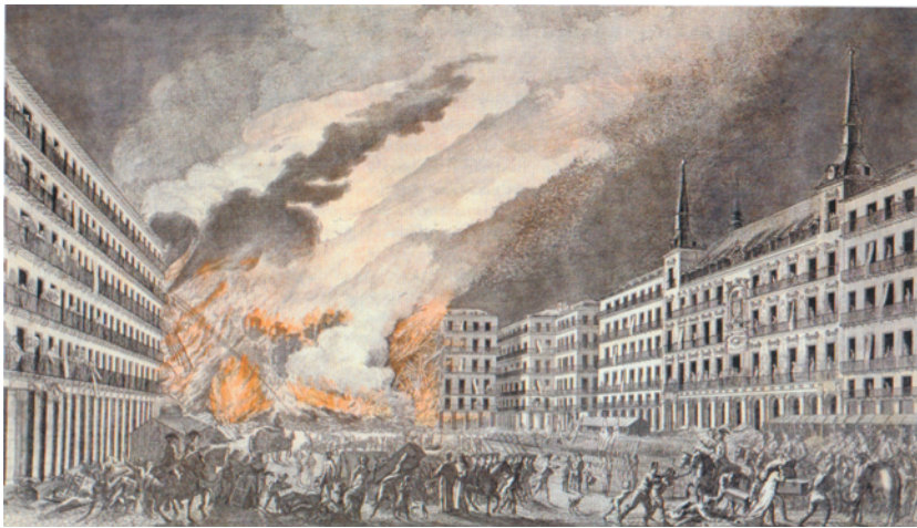
FIG. 94: Vista nocturna del incendio de la Plaza Mayor de Madrid acaecido el 16 de agosto de 1790, (detalle), 1790, José Ximeno dib. & grab.
