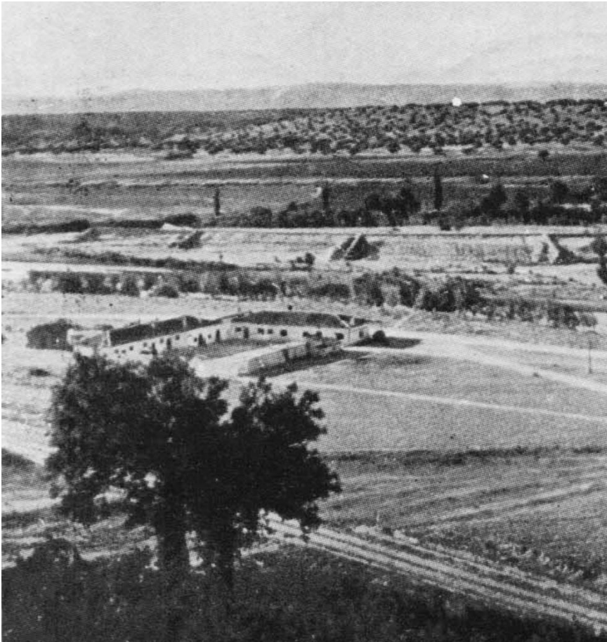
Fig. 35 Los edificios del Destacamento Penal Presa del Alberche vistos desde uno de los cerros-terrera
