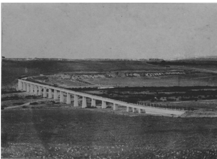
Fig. 33 Para construir el Acueducto del Prado, cerca de Calera hubo un pequeño campamento.
