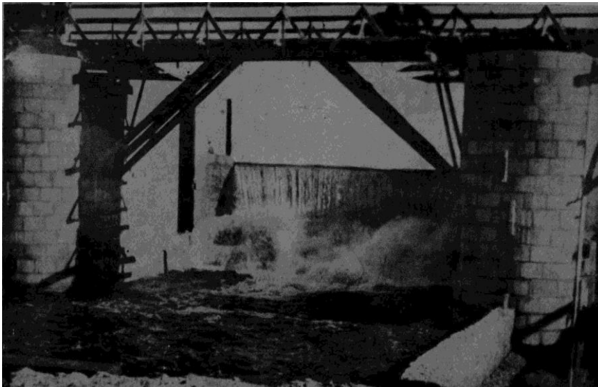
Fig. 16 Vista de uno de los cierres provisionales abovedados colocados en los vanos de las compuertas.
