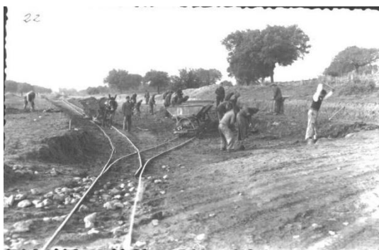
Fig. 6 En la imagen puede verse a los presos de la brigada de tierra picando y a las mulas tirando de las vagonetas sobre raíles para transportar la tierra.
