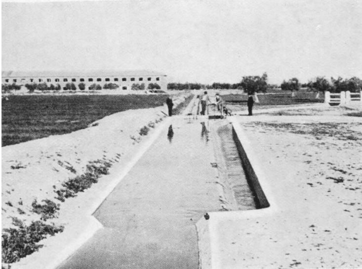
Fig. 31 Vista de una de las acequias que distribuyen el agua del canal.
