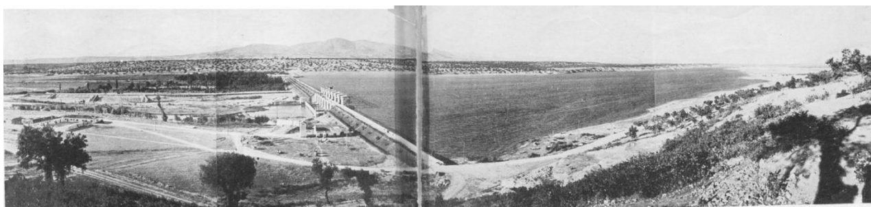
Fig. 30 Fotografía panorámica del embalse del Alberche a la finalización de las obras en 1950. En primer término se aprecia el dique con la zona de compuertas en el centro. A la izquierda de la foto se distingue el edificio del Destacamento Penal Presa del Alberche.
