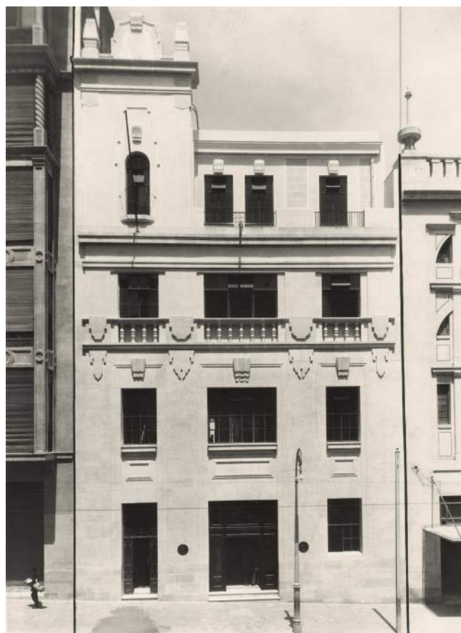
Figura 4.126: Central telefónica, Alicante, 1931, Ignacio de Cárdenas Pastor. Archivo Histórico Fotográfico de Telefónica.
