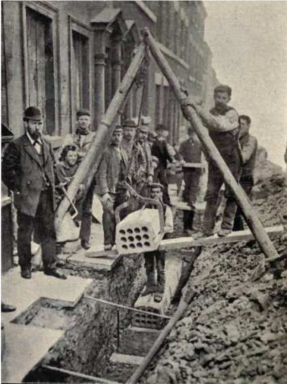
Figura 2.13: Tres imágenes del libro de 1903 “Telephone lines and methods of constructing them overhead and underground” , del ingeniero inglés Walter C. Owen. Arriba, a la izquierda, el sistema conocido en España como “americano”. En el interior de la zanja se colocan los bloques de hormigón que forman las canalizaciones por las que se introducían los mazos de cables de pares. De esta forma quedaban bien protegidos de la humedad, los roedores y otras inclemencias. A la derecha, un método menos habitual y más costoso en el que el mazo estaba recubierto por cable de acero. Abajo, un esquema de distribución de cableado subterráneo urbano, en el que se pueden ver las canalizaciones y las cajas de registro.
