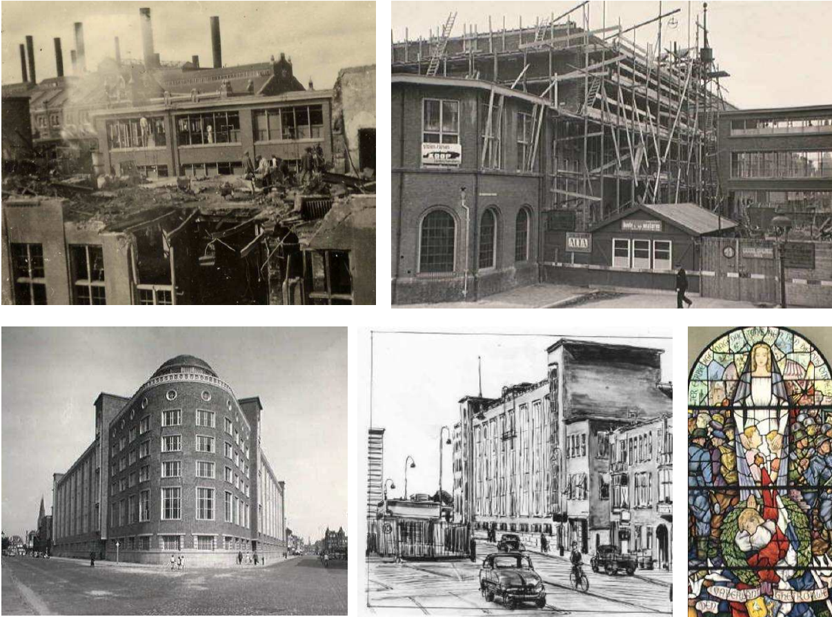
Figura 5.19: La Haya, central en la Marnixstraat . Arriba, daños del bombardeo de 1943 y obras de reparación en 1948. Abajo, nuevo edificio, construido en 1953, arquitectos A. v.d. Vorst y G. Bakker. La perspectiva de 1963 es de una serie de paisajes urbanos del dibujante W. F. Meijer. La vidriera es un homenaje a la acción del personal de la PTT durante la guerra. Fuente: Haags Gemeentearchief .
