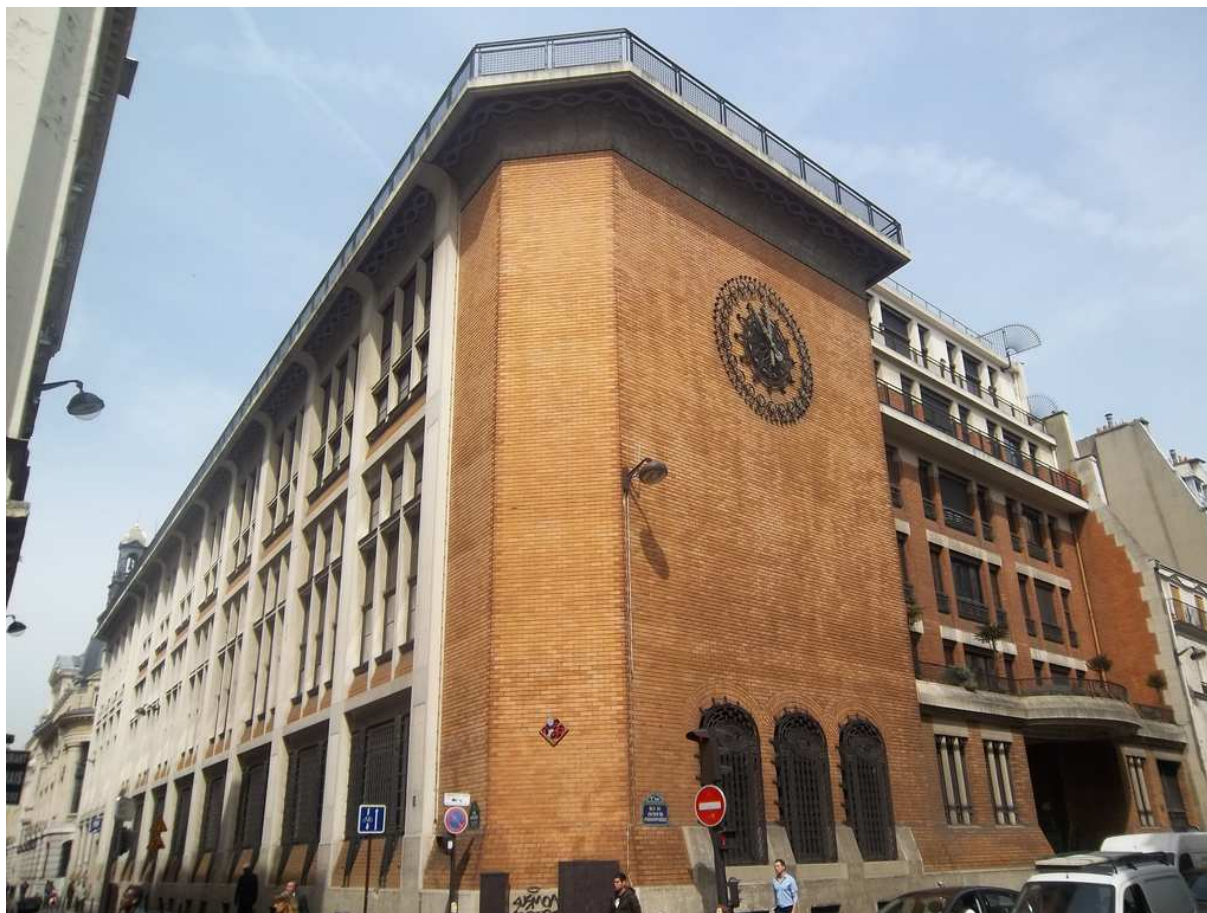
Figura 3.155: Paris, central de la Rue de Bergère , 1912, François Lecoœur. Fotografía: Jamie Barras
