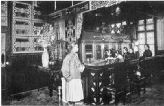
Figura 3.51: Fotografía del interior. Fuente: Cyclopedia of Telephony & Telegraphy , 1919.
