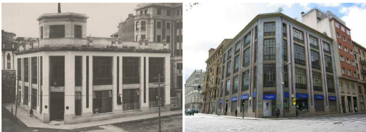
Figura 4.99: Central telefónica “Ensanche”, Pamplona, 1927, Jose María de la Vega Samper. Ubicada en la desembocadura de la calle de la Estafeta y frente a la plaza de toros da nombre a la “curva de Telefónica” del recorrido San Fermín. A la derecha, vista en 2008. Fotografía: Judit Alberich Daroca.
