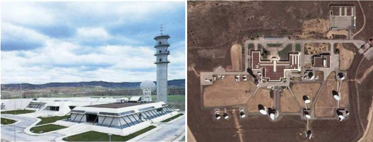
Figura 6.42: Estación de seguimiento de satélites de Armuña de Tajuña (Guadalajara), 1984-1986, Jaime López-Amor Herrero. CTNE, Memoria 1986, p. 21 y Google Maps,
