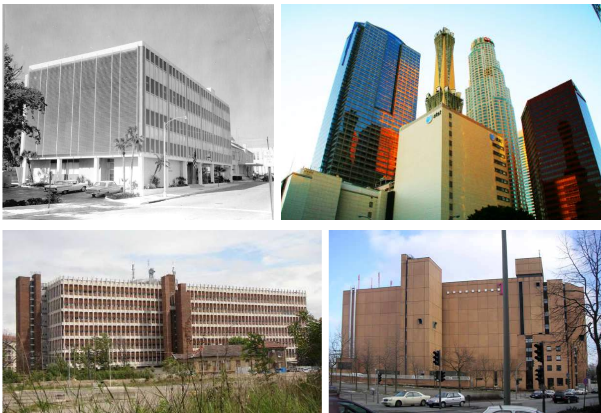
Figura 5.65: Arriba, a la izquierda, central de GTE en Ocala, Florida (EEUU), 1965. Fuente: State Library and Archives of Florida . A la derecha, central de AT&T en el Downtown de Los Angeles (EEUU), 1961, Donald D. Parkinson, John D. Parkinson. Fotografía: Kenneth Han . Fuente: Wikimedia Commons . Abajo, a la izquierda, central Lacassagne, Lyon (Francia), 1972, André Gutton, Fuente: Rues de Lyon . Abajo, a la derecha, central telefónica en Hamburgo (Alemania), 1978. Fotografía de autor desconocido.
