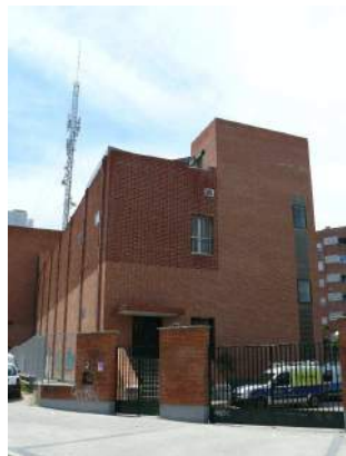
Figura 5.124: “Bellas Vistas”, Madrid, 1966, Julio Cano Lasso, Estado en mayo de 2011. Se distinguen con facilidad las ampliaciones por el distinto tono del ladrillo Colección propia del autor.
