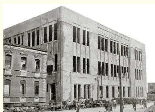
Figura 2.40: Interior y exterior de la central Hamacho de Tokyo, un edificio moderno de estructura de hormigón, cuyo equipo se perdió por el incendio.
