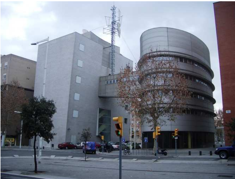
Figura 6.51: Central telefónica de la Villa Olímpica, calle Joan d'Àustria Barcelona, 1989-1992, Jaume Bach y Gabriel Mora. Fotografía de autor desconocido. Fuente: descobrisanmarti.org
