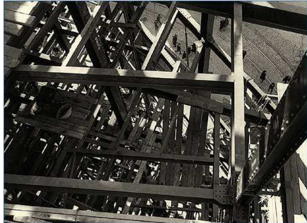
Figura 2.37: El esqueleto metálico de la central convertido en obra de arte fotográfica por Claret. Archivo Histórico Fotográfico de Telefónica.
