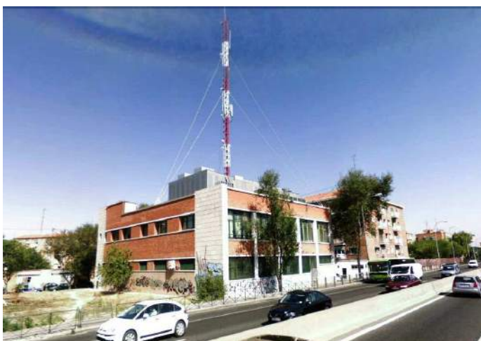
Figura 5.113: Arriba, central telefónica “Moscardó”, Madrid, 1960-1964, Francisco Riestra Limeses. Guía COAM 184 , ficha 363. Fotografía COAM. Sobre estas líneas, central “Campamento”, Madrid, 1962, Francisco Riestra Limeses. Google Street View.
