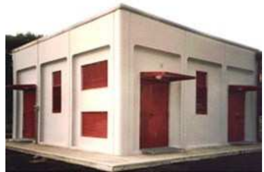
Figura 1.47: Edificio tipo MD6 de Telecom Italia . Fotografía de autor desconocido.
