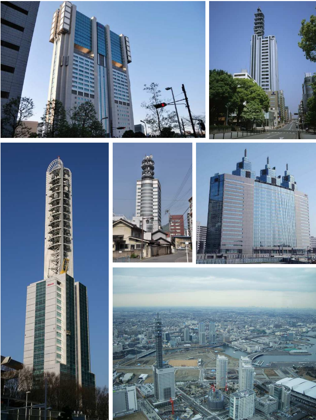
Figura 6.18: Centrales-torre de NTT DoCoMo. Fila superior izquierda, Shinagawa (Tokyo), 2003. Fotografía: Ykanazawa. A su derecha, Nagoya, 2002-2005. Fotografía de autor desconocido. Columna izquierda inferior, Saitama, 2001. Fotografía de autor desconocido. Fila central izquierda, Nagano. Fotografía de autor desconocido. Fila central derecha, Kawasaki, Fuente: structurae.de. Fila inferior, Yokohama Media Center, 1999. Fotografía de autor desconocido. Todos los edificios están firmados por NTT Power and Building Facilities, en la actualidad, NTT Facilities.
