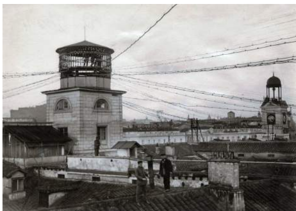
Figura 2.9: Madrid, 1927. Templete de la calle Mayor poco antes de ser desmontado. Fuente: Telefónica .
