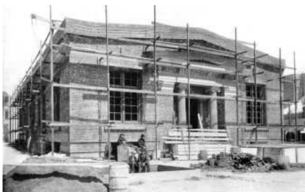
Figura 3.24: Central South , construida en Mission Revival Style según el propio pie de foto.
