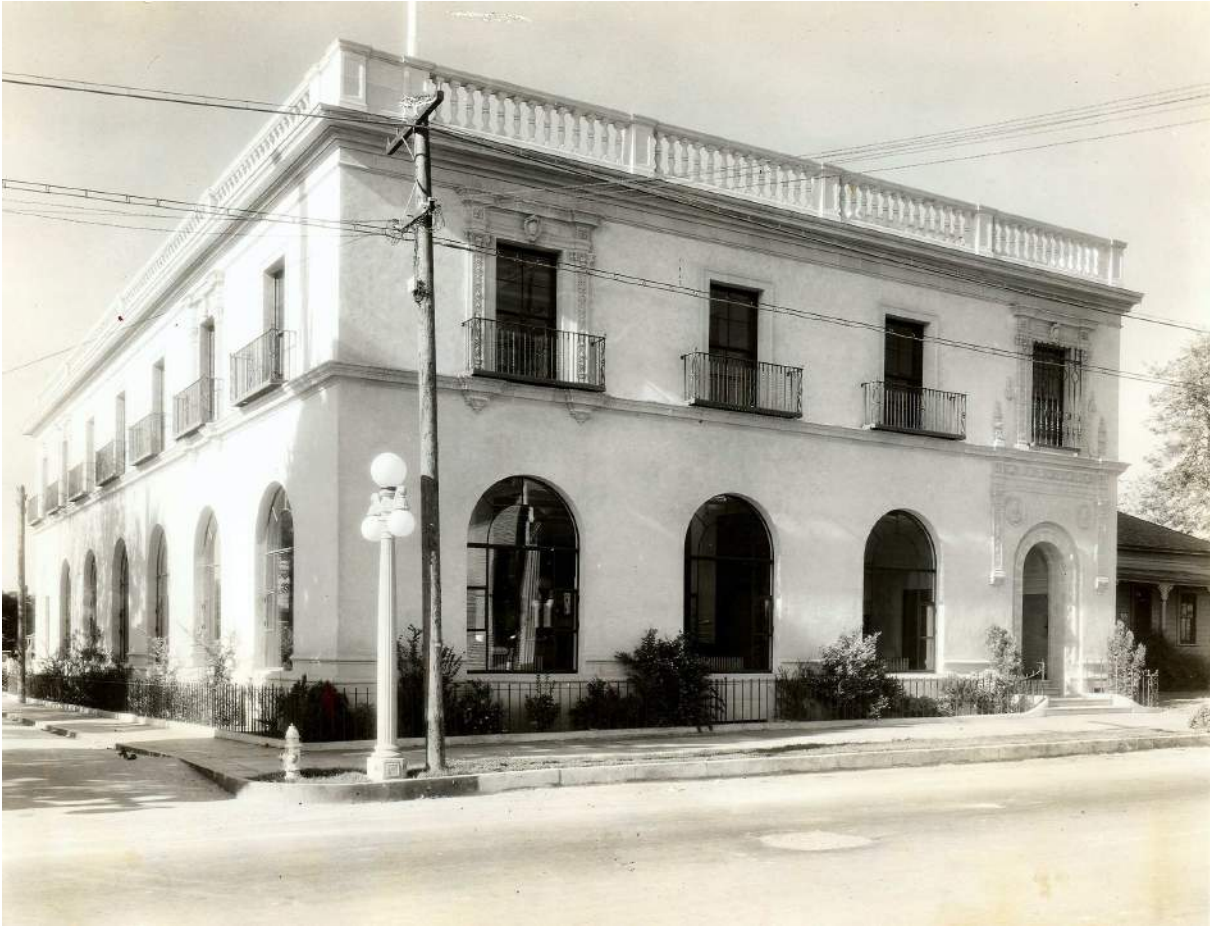
Figura 3.104: AT&T Toll Building, San Bernardino (California), 1930, no constan datos de autoría. Cortesía del archivo histórico de AT&T.
