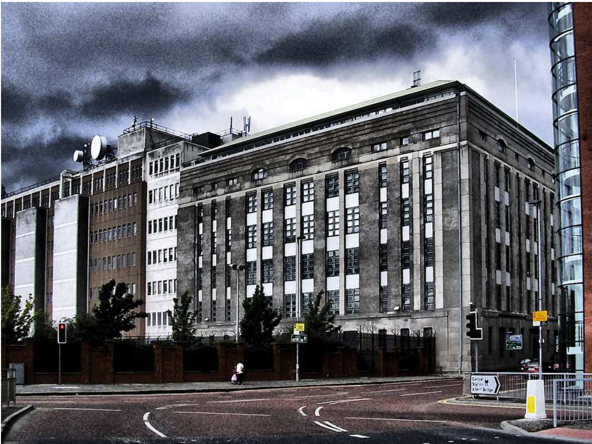
Figura 3.166: Telephone House , Belfast (Irlanda del Norte), 1934, T. F. O. Ripplingham. El cuerpo de la izquierda es una ampliación de 1959. Foto: John D. McDonald.
