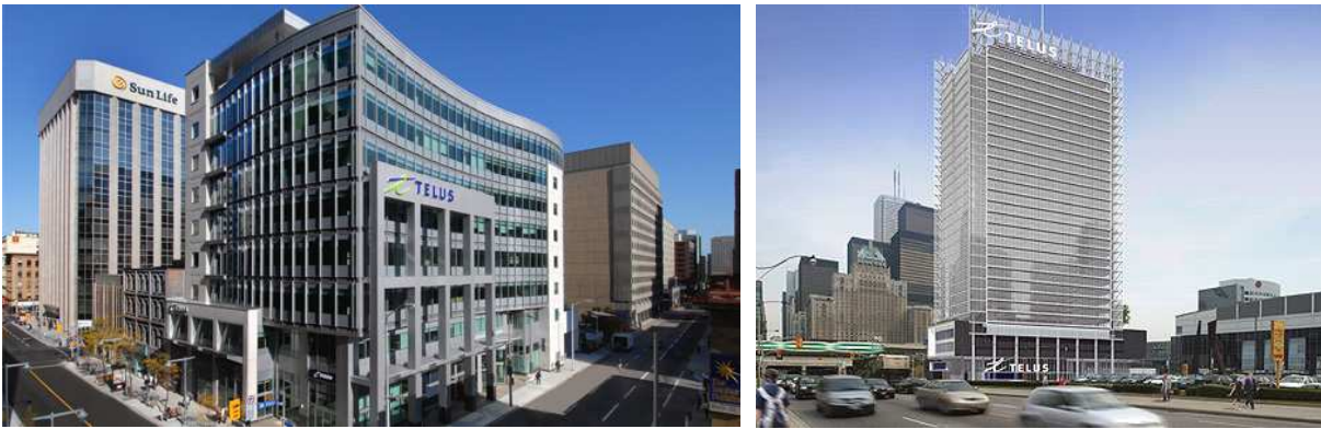
Figura 6.10: Izquierda, Telus Ottawa (Canadá), 2007, Richard Chmiel Architect and Associates . Derecha, Telus Toronto , 2009, Adamson Associates International . Infografías de los respectivos estudios:
