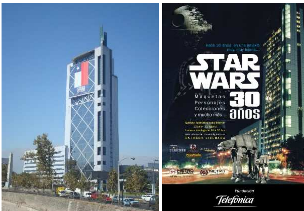
Figura 6.68: Torre Telefónica, Santiago de Chile, 1992-1996, Iglesias, Prat, Paredes y Corvalán. A la izquierda, imagen de los primeros días de marzo de 2010. Entonces sirvió de soporte a una pancarta que decía “Chile está llamando. Juntos respondamos 'Aquí estoy'”, en referencia al terremoto, que causó algunos daños al rascacielos. Es el edificio anuncio del que habló Ignacio de Cárdenas en los años veinte. Fotografía: Wikimedia Commons. A la derecha, cartel de la exposición sobre los treinta años del estreno de Star Wars , organizada por la Fundación Telefónica de Chile en 2007. Aquí, el contenedor del evento se convierte en decorado de un paisaje ciencia ficción poblado por las máquinas de guerra imaginadas por la factoría de George Lucas.
