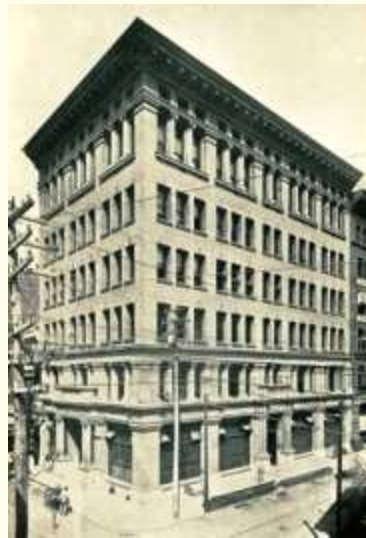
Figura 3.33: Bell Telephone Building, "The Official Office Building Directory and Architectural Handbook of Philadelphia", The Commercial Publishing and Directory Co. , Philadelphia, 1899, p. 129. Aunque no cita autor, con gran probabilidad es James Hamilton Windrim (1840-1919), que introdujo el modelo de rascacielos de Chicago en la ciudad
