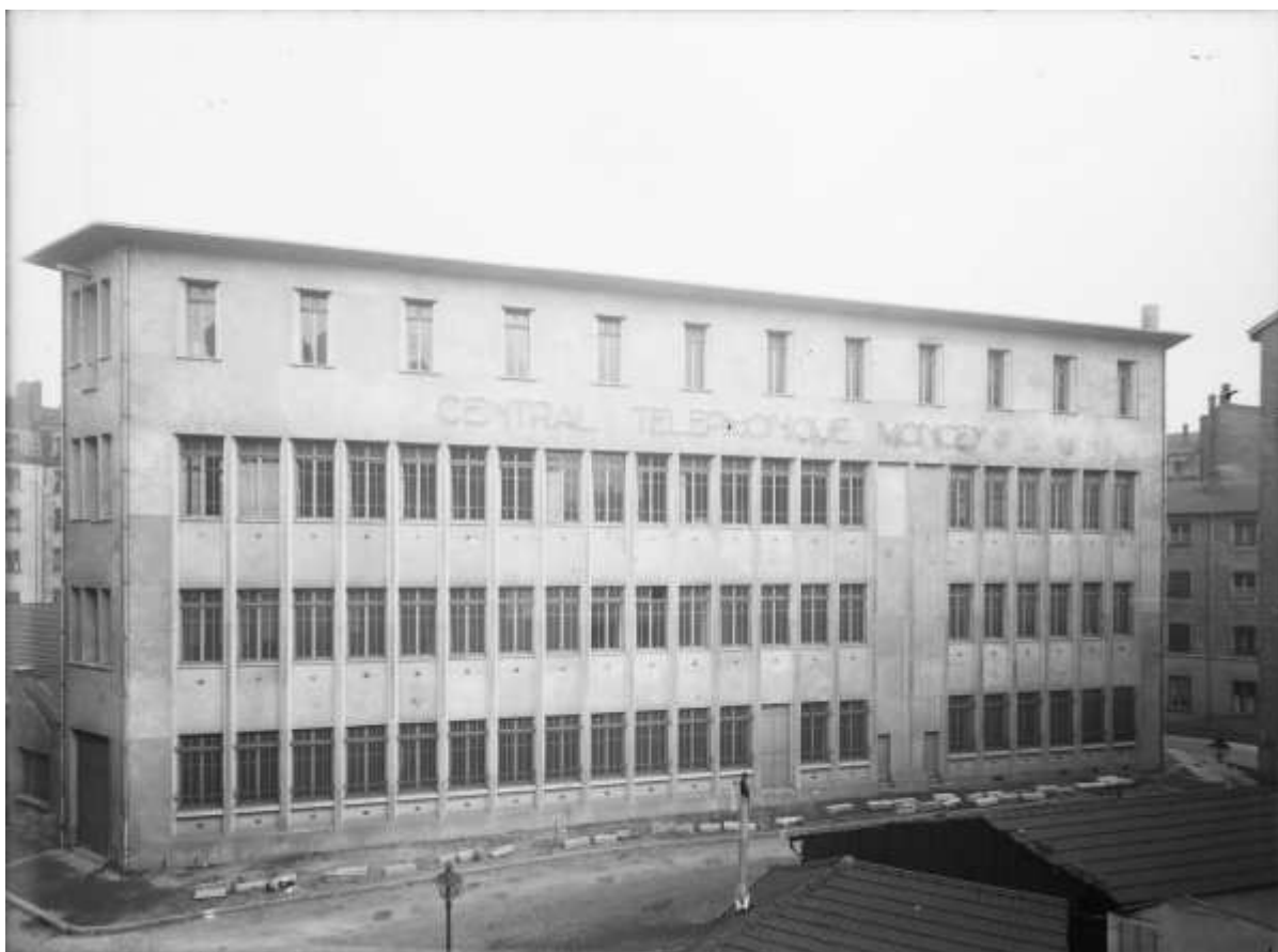
Figura 3.170: Central Moncey en la Rue de Vaudrey, Lyon (Francia), 1927-1933, Tony Garnier. Fuente: Bibliothèque municipale de Lyon
