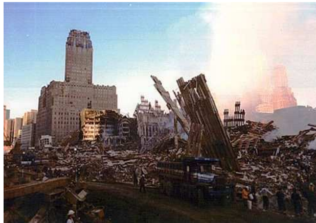
Figura 3.75: Septiembre de 2001, el Barclay-Vesey en la Zona Cero. Fuente: FCC
