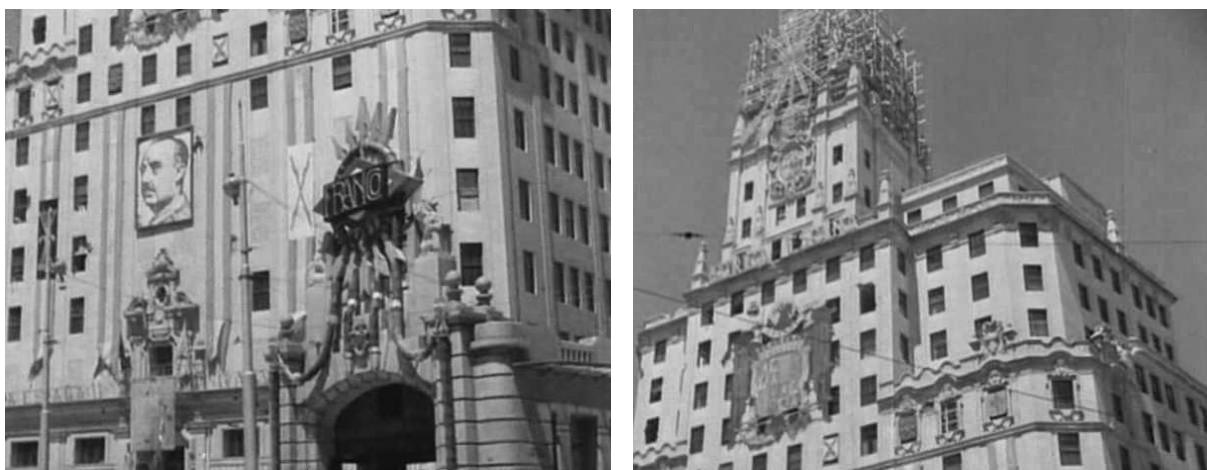
Figura 5.43: Dos fotogramas del NO-DO que muestran el castillo de fuegos artificiales que se montó en el edificio de Gran Vía en mayo de 1939 66 para celebrar la victoria de Franco. No había habido tiempo para reparar los daños de la artillería, así que las banderas y colgantes se colocaron para disimular los boquetes en los muros.
