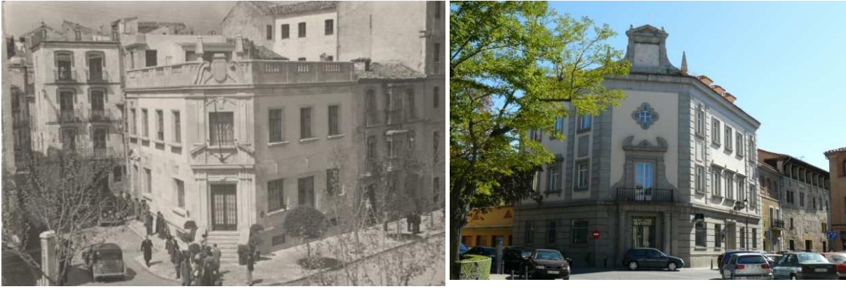
Figura 5.52: Izquierda, central telefónica de Jaén, 1947, Departamento de Edificaciones. Archivo Histórico Fotográfico de Telefónica . Derecha, central telefónica de Segovia, 1950, José María de la Vega Samper. Estado en octubre de 2008. Colección propia del autor .
