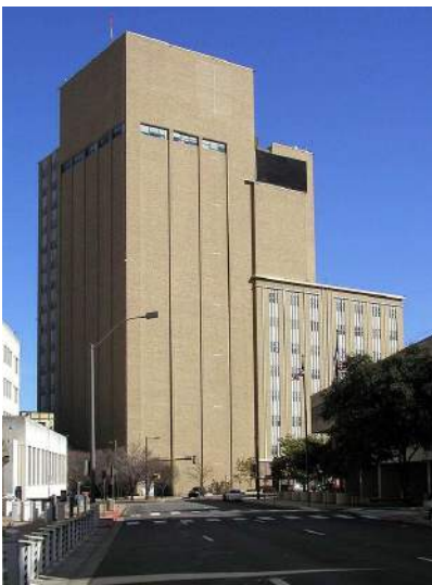
Figura 5.10: Southwestern Bell , Fort Worth, Texas. Esta central ha vivido múltiples transformaciones en más de un siglo de servicio. La imponente torre de ladrillo es un diseño típico de la telefonía de la segunda mitad del siglo XX, Komatsu & Associates , 1971. Fuente: Fort Worth Architecture .
