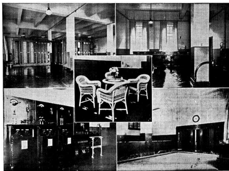
Diversas dependencias de la nueva Central Telefónica de Gijón
