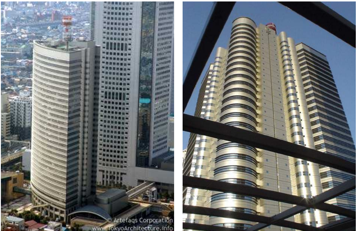
Figura 6.17: Sede central de NTT ( NTT East en la actualidad), Shinjuku, Tokyo, 1990-1995, César Pelli. Fuente: Tokyo Architecture.
