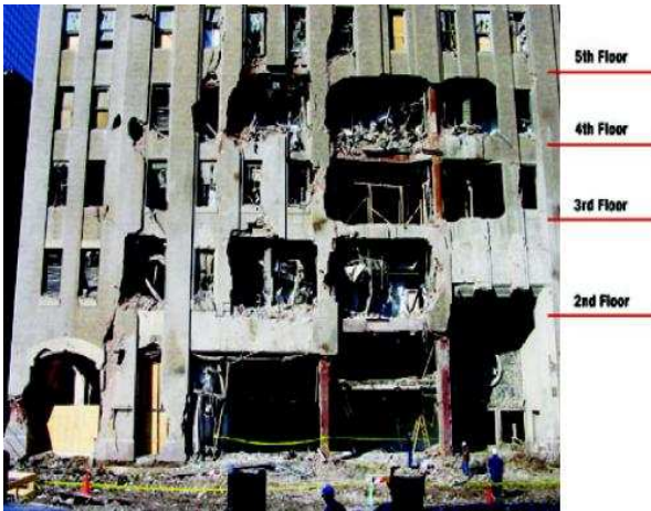
Figura 3.74: Parte inferior de la fachada de la calle Washington. Fuente: The WTC Report .
