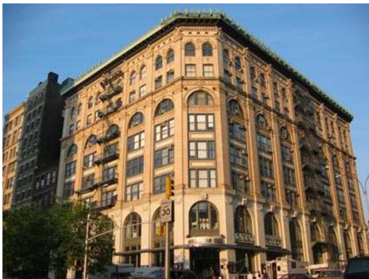
Figura 3.20: Cable Building , Nueva York, 1892-1894, McKim, Mead & White. Fuente: nyc-architecture.com
