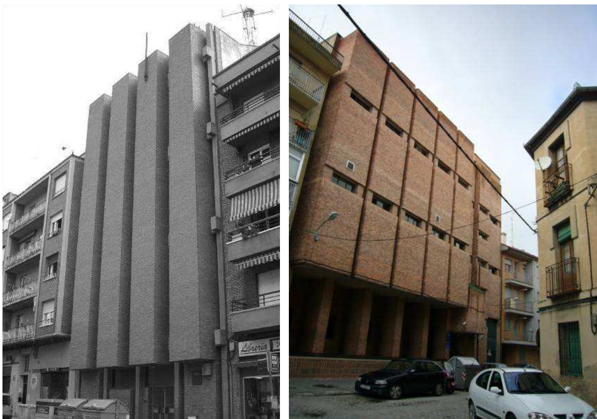
Figura 5.170: Izquierda, central de Calahorra (La Rioja), 1970-1973. José Luis de Arana Amurrio. Fuente: Arquitectura Siglo XX . Derecha, Segovia “Caño Grande”, 1970-1973, José Luis de Arana Amurrio. Fuente: DOCOMOMO .
