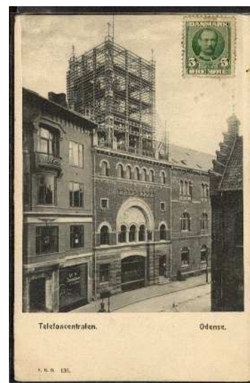
Figura 3.136: Odense (Dinamarca), central de la compañía local, de estilo neorrománico y con un gran templete metálico.
