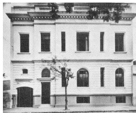
Figura 4.140: Arriba, central automática de Santurce (Puerto Rico) 331 , 1945. Centro, central de Chillán (Chile) 332 , 1929. Abajo, Central "Gómez", Buenos Aires, 1940. 333
