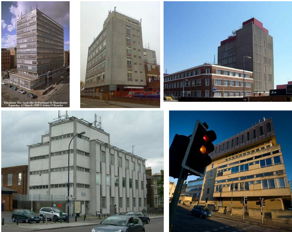
Figura 5.79: Algunos ejemplos de centrales británicas “odiosas” de los años 60 y 70. Arriba, izquierda. Telephone House, Manchester (1961). Fotografía: Aidan O'Rourke. En el centro, central de Newbury 128 . Fotografía de autor desconocido. A la derecha, torre de Grimsby (1973) junto a la antigua central Art Déco. Fotografía: David Wright. Abajo, izquierda, central Forest Hill en Dulwich. Fotografía: Danny Robinson. A su derecha, central de Bath, 1967, W. S. Frost. Fotografía del profesor David Lewis-Baker.
