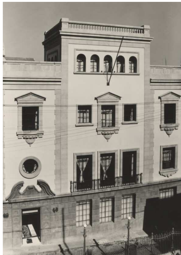
Figura 5.53: Central telefónica de Santa Cruz de Tenerife. 1949, Departamento de Edificaciones. Archivo Histórico Fotográfico de Telefónica .
