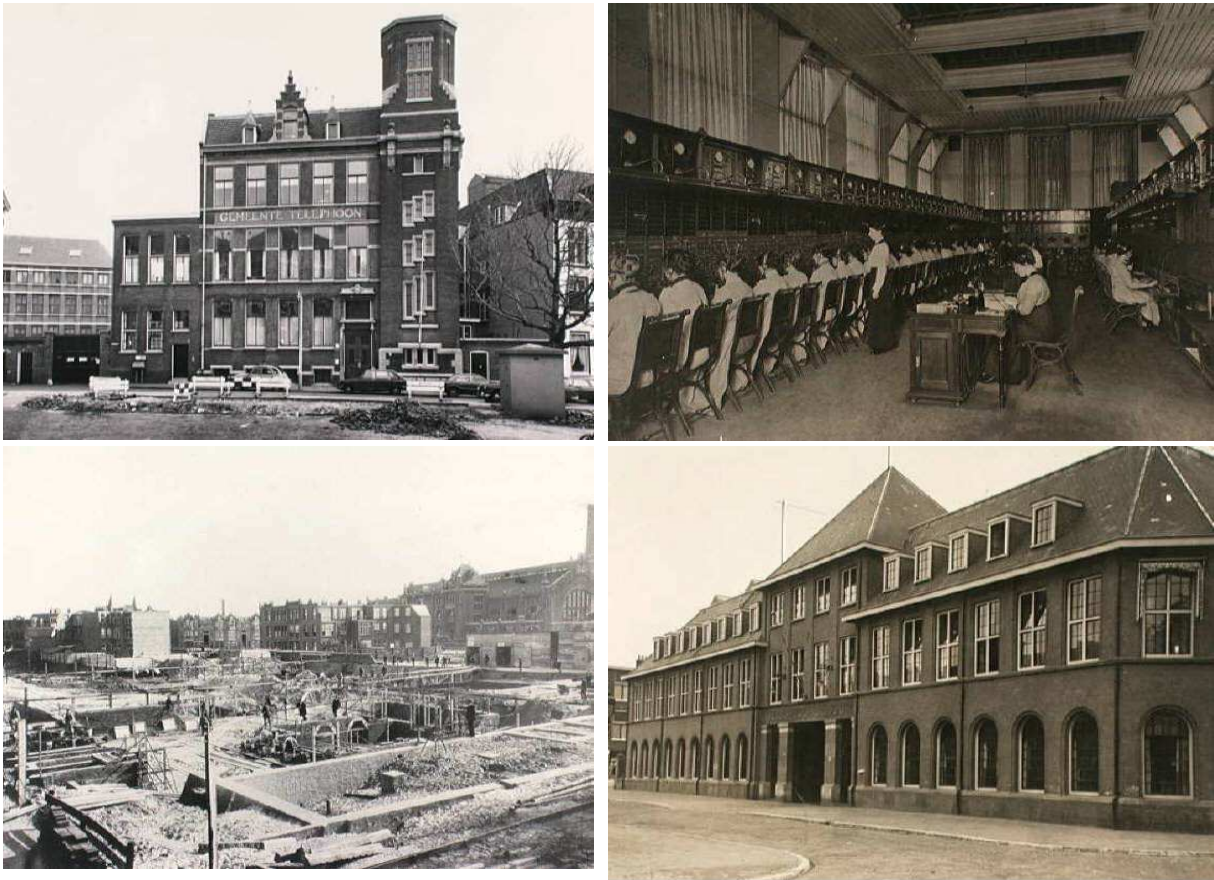
Figura 3.139: Arriba, central Centrum , en la Hoosstraat , La Haya, 1910. Vistas exterior e interior. Abajo, central en la Marnixstraat de la misma ciudad, 1912. Fotografía de las obras y vista exterior. Fuente: Haags Gemeentearchief .
