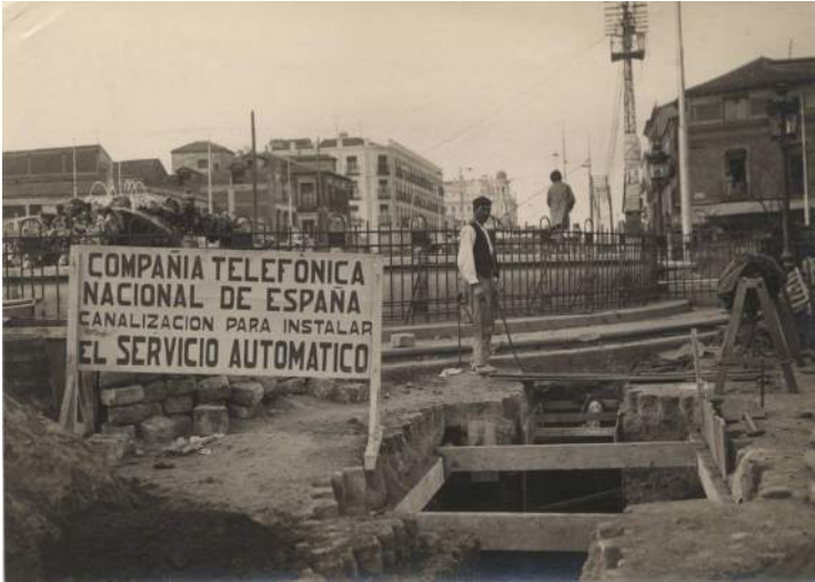
Figura 2.11: Madrid, 1926. Excavación de zanjas para la red telefónica en la plaza de Neptuno. Al fondo se puede ver una torre metálica del viejo tendido aéreo. Archivo Histórico Fotográfico de Telefónica.
