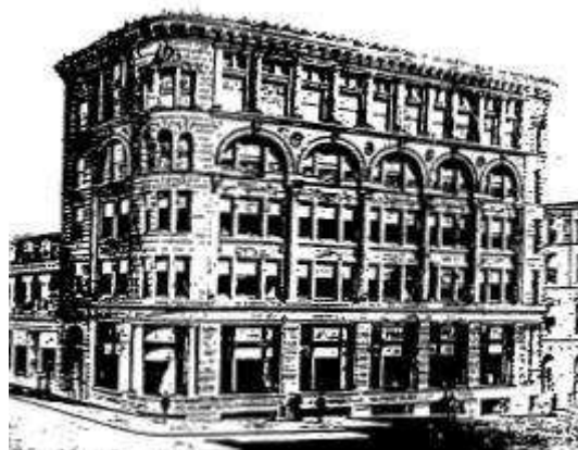
Figura 3.18: Arriba, plano original de Edward Maxwell con el alzado de la central de la Rue de Notre-Dame (1895-1897). Fuente: McGill University . Derecha, vista del edificio una vez terminado. ( Poitras , 1996, p. 212).
