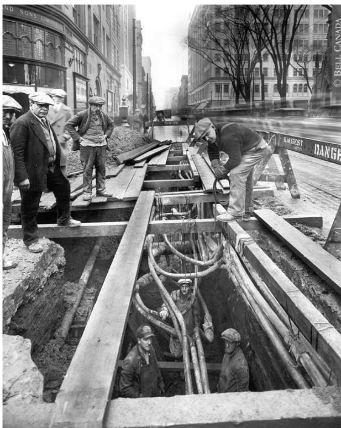
Figura 2.12: Izquierda, Instalación de cables subterráneos en Montréal, 1930. Fotografía: Millar Studio, Museo McCord. Derecha, caja de registro con un operario trabajando en su interior. Se pueden ver los conductos de cable. (Pole, 1894, p. 258).
