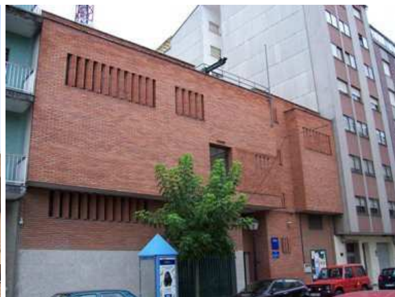
Figura 2.21: Vigas de carga y puertas de materiales. A la izquierda, en la central “Florida” de Alicante. Están situadas en un extremo de la fachada, Arriba, central de Monforte de Lemos (Lugo), 1972, Jaime Martínez Ramos y José Luis de Miguel Rodríguez. En este edificio sólo hay una puerta para dar servicio a la primera planta. El modelo de viga es normalizado para todas las centrales. En este segundo caso se observa con claridad como el hueco de la puerta no se abre en la vertical de la entrada principal, para no bloquear el acceso al edificio con las operaciones de carga y descarga. Colección propia del autor.
