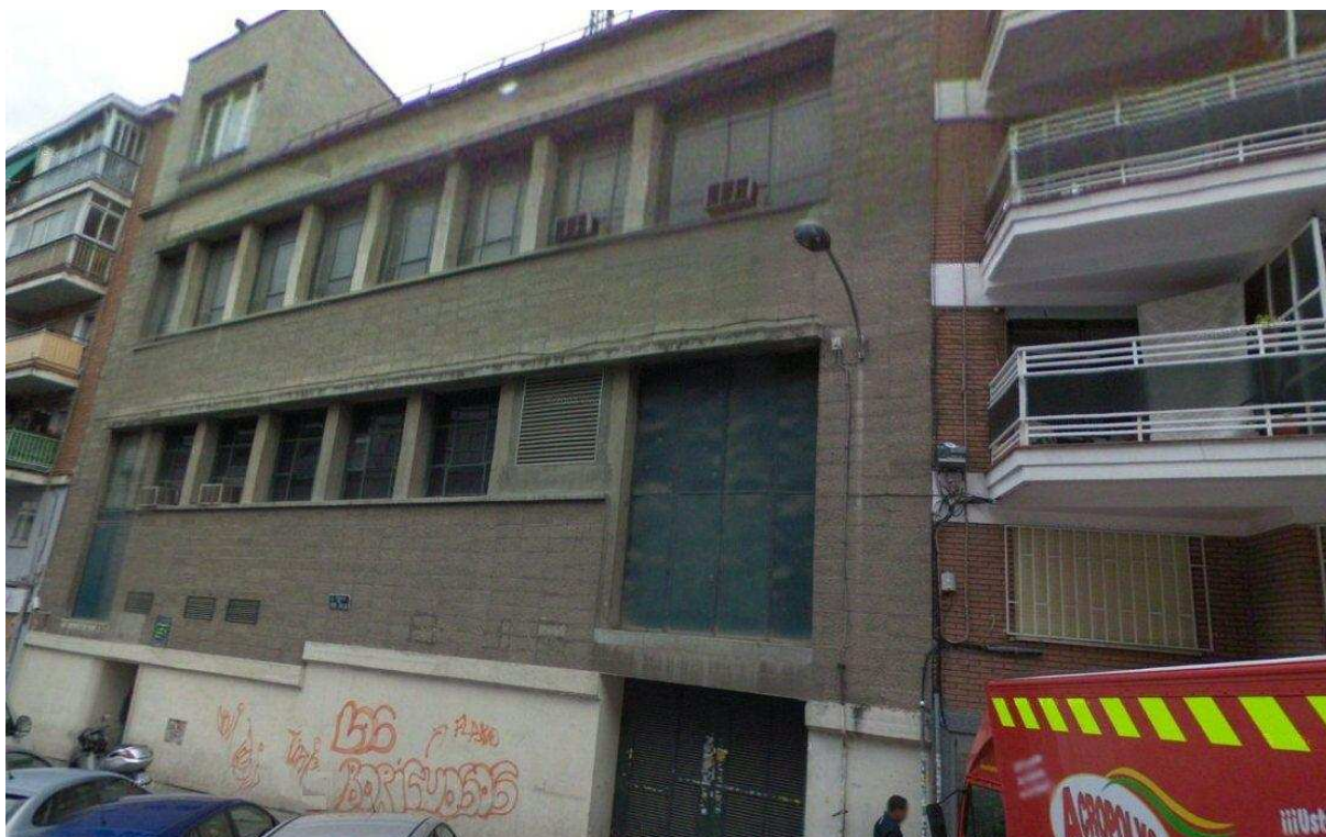
Figura 5.114: Central telefónica “Aragón”, Madrid. 1960, Francisco Riestra Limeses. Fotografía: Google Street View,
