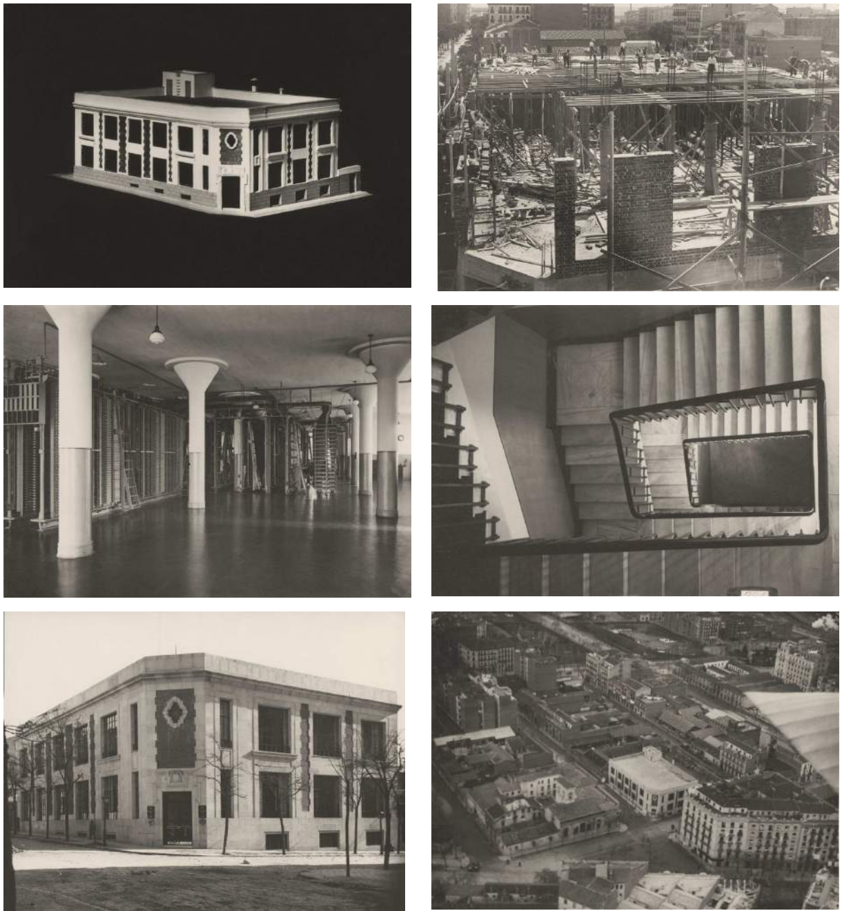
Figura 4.80: Central “Delicias”, Madrid, 1928, Ignacio de Cárdenas Martín y José María de la Vega Samper. Maqueta, vista de las obras, sala de conmutación con columnas fungiformes y dos imágenes del edificio terminado. La aérea es de la serie que realizó Marín. No consta autor de la espectacular fotografía con perspectiva cenital de la escalera interior, aunque es posible que fuese también de Marín. Archivo Histórico Fotográfico de Telefónica.
