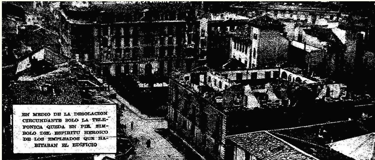
Figura 4.44: La central de Oviedo (ver fig: 4.93) rodeada de edificios destruidos en la plaza de Porlier. La escasa calidad de la reproducción no disminuye su valor como testimonio. Foto: Díaz Casariego, Blanco y Negro.
