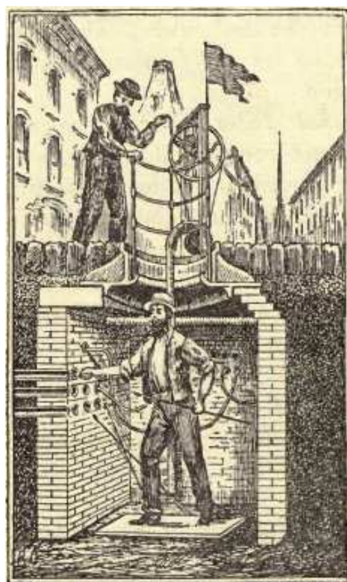
Figura 2.12: Izquierda, Instalación de cables subterráneos en Montréal, 1930. Fotografía: Millar Studio, Museo McCord. Derecha, caja de registro con un operario trabajando en su interior. Se pueden ver los conductos de cable. (Pole, 1894, p. 258).
