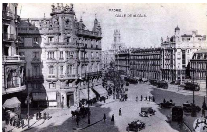
Figura 4.46: Casa del Cura de la Iglesia de San José, en la calle de Alcalá, 1910-1913, Juan Moya Idígoras. Postal de los años 30. Fuente: www.alexmadrid.es .
