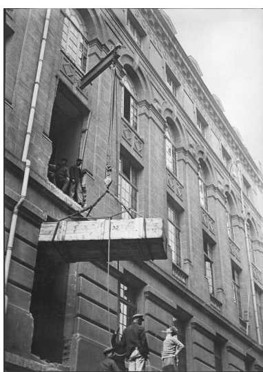
Figura 3.187: Central Trindade , Lisboa (Portugal), inaugurada en 1925. A la izquierda, introducción de equipo para convertirla en la primera automática del país en agosto de 1930. La viga de carga es provisional y ha habido que dismantelar dos balcones para permitir el paso. A la derecha, anuncio de la Anglo Portuguese Telephone Company sobre el acontecimiento. Fuente: Fundação Portuguesa das Comunicações .
