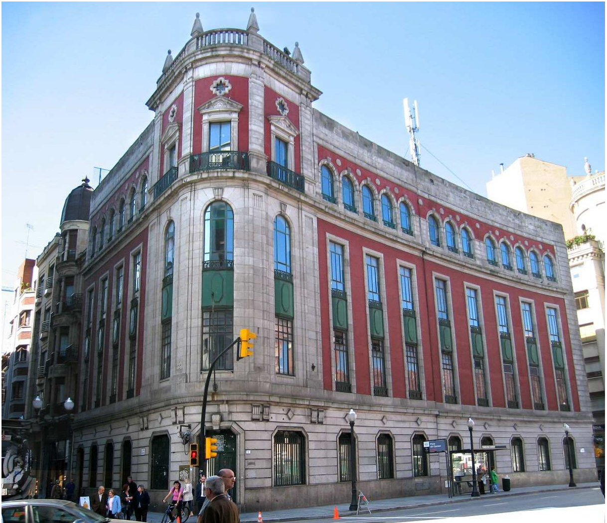
Figura 4.94: Central telefónica, Gijón, plaza del Carmen, 1930-1932, José María de la Vega Samper. Imagen actual con la extensión que se hizo en la fachada de la plaza. Puede apreciarse la junta entre el edificio original y el cuerpo más nuevo. Fotografía: Juan Hernaz.
