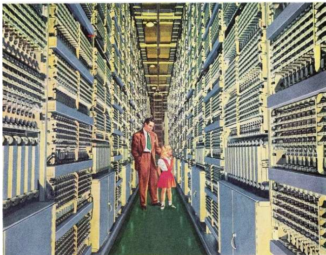
Figura 5.9: Anuncio de Western Electric de 1950, un padre muestra orgulloso a su hija el interior de una central electromecánica de barras cruzadas. La disposición de los equipos era la misma que para las centrales tipo Rotary o Strowger , pero el volumen ocupado por cada línea de abonado resultaba menor. También se redujo el coste de mantenimiento. Obsérvese la completa falta de luz natural.
