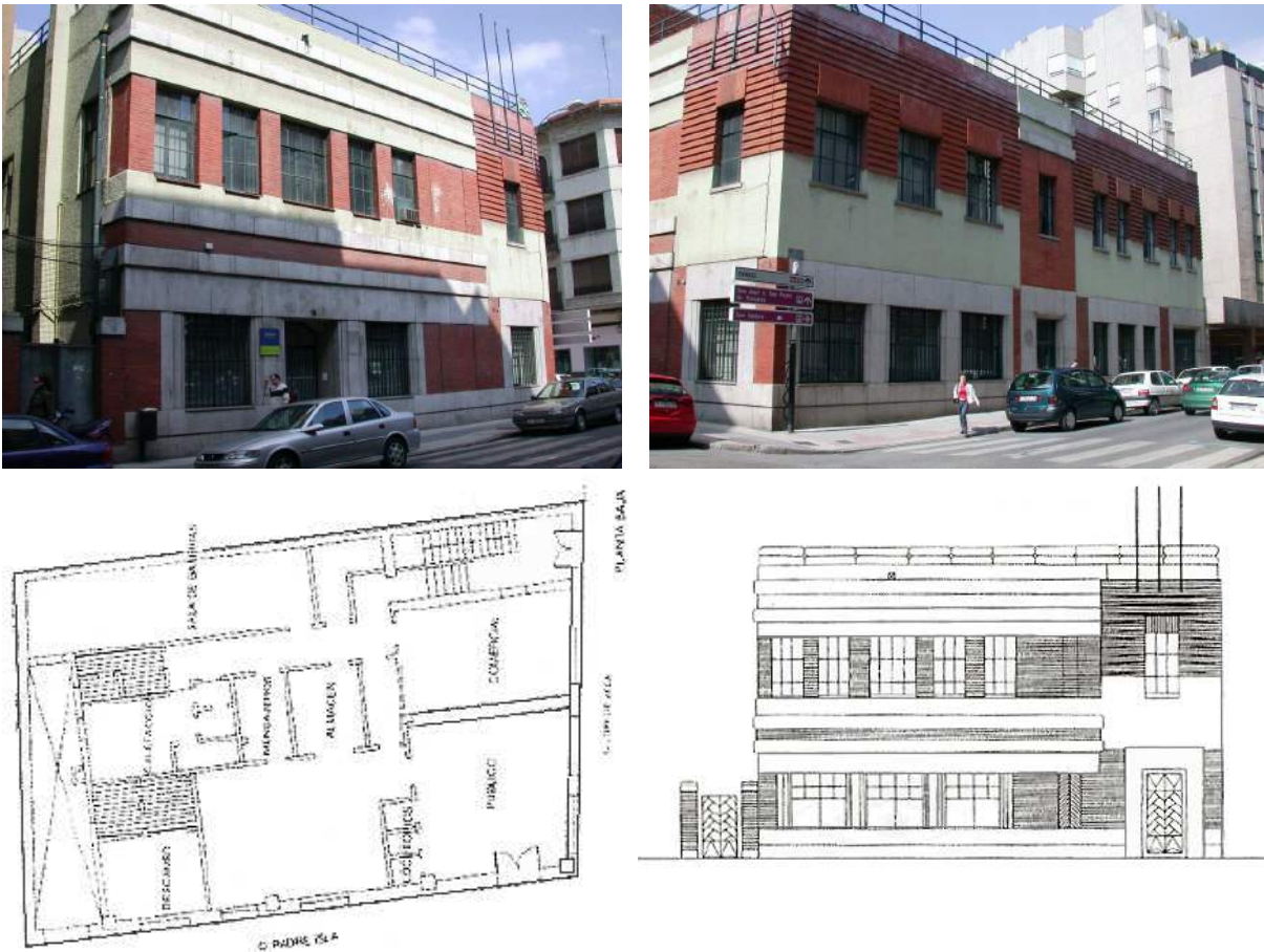
Figura 4.85: Central telefónica de León, 1932, Ignacio de Cárdenas, José María de la Vega y Paulino J. Gayo Notario. Arriba a la izquierda, vista desde la calle Padre Isla con el aspecto original y a la derecha la fachada a la calle Lope de Vega con el cuerpo añadido en 1949. Abajo, planos de la planta baja original y el alzado de la calle Padre Isla. Fuente: Ayuntamiento de León.
