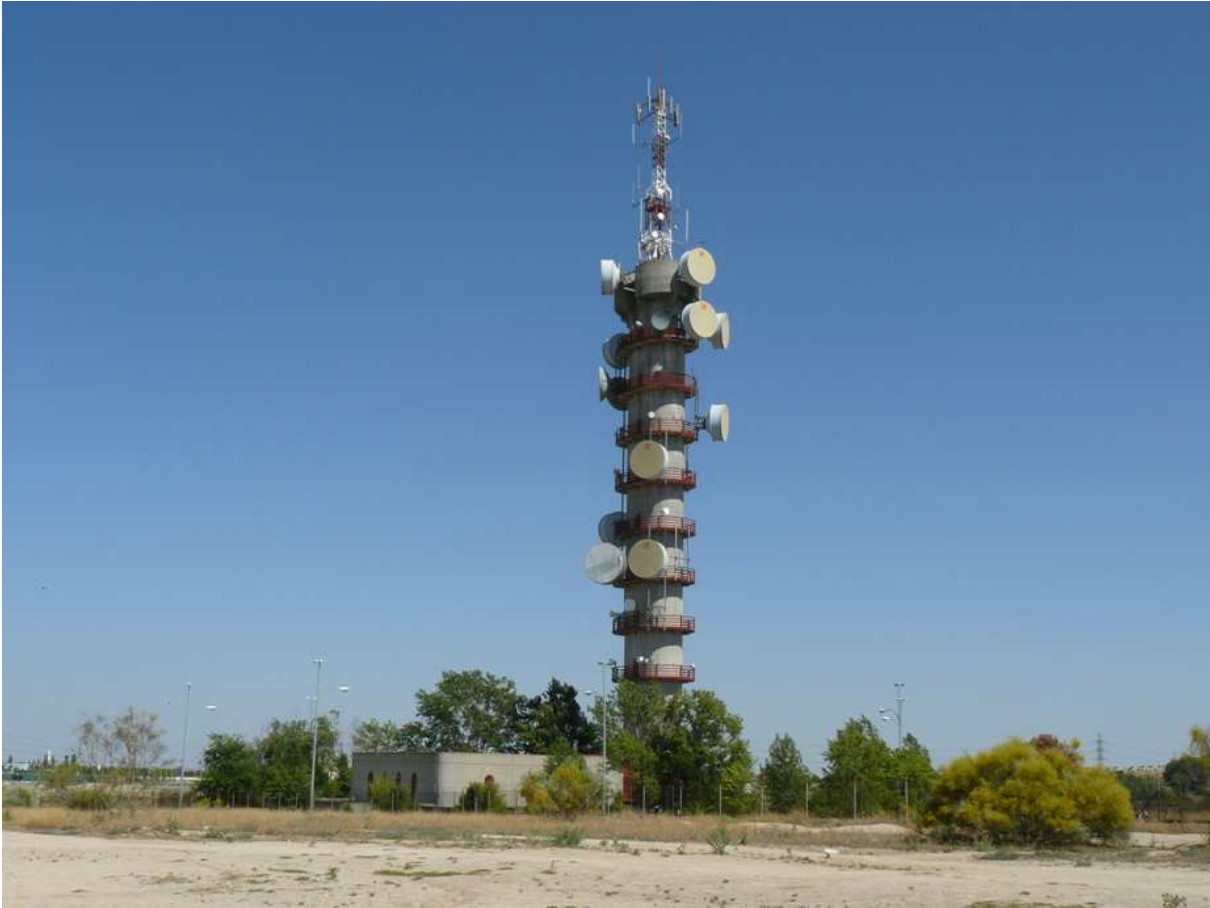
Figura 5.132: Torre de radioenlaces de Telefónica en Pozuelo de Alarcón (Madrid), 1978-1979, Antonio Fernández Alba, con la colaboración del ingeniero José Ortiz. Fotografía tomada en junio de 2009. Colección propia del autor.
