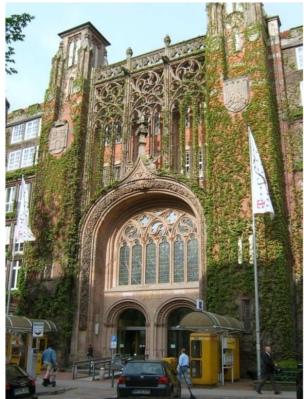
Figura 3.142: Oficina principal del Reichspost de Hamburgo, 1902-1907, Paul Schuppan y Willy Sucksdorff. En la postal de época de la parte superior, se puede ver la leyenda “Nueva central telefónica (la mayor del mundo)” 270 . Las dimensiones del edificio eran colosales para la telefonía de principios del siglo XX, pero hay que tener en cuenta que también servía de sede postal, administrativa y telegráfica.
