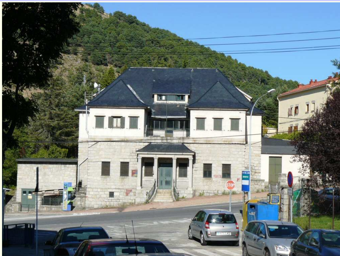
Figura 5.64: Central telefónica de San Rafael (Segovia), 1945, José María de la Vega Samper. Fotografía tomada en octubre de 2008, colección propia del autor.
