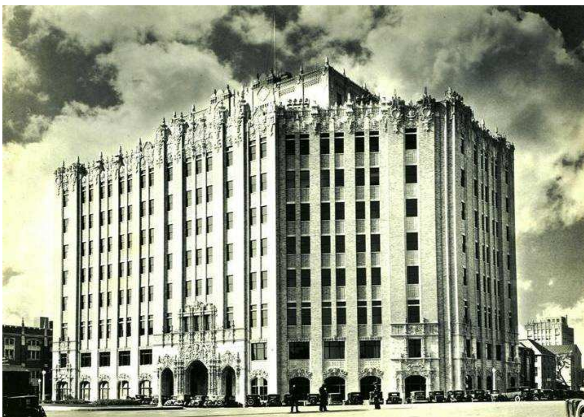
Figura 3.101: Southwestern Bell , San Antonio (Texas), 1932, I. R. Timlin. Cortesía del archivo histórico de AT&T.
