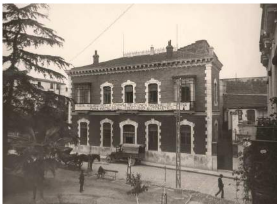
Figura 4.118: Jerez de la Frontera. Edificio adquirido para reforma e instalación de la central automática, 1927. Fotografía: Marín. Archivo Histórico Fotográfico de Telefónica.
