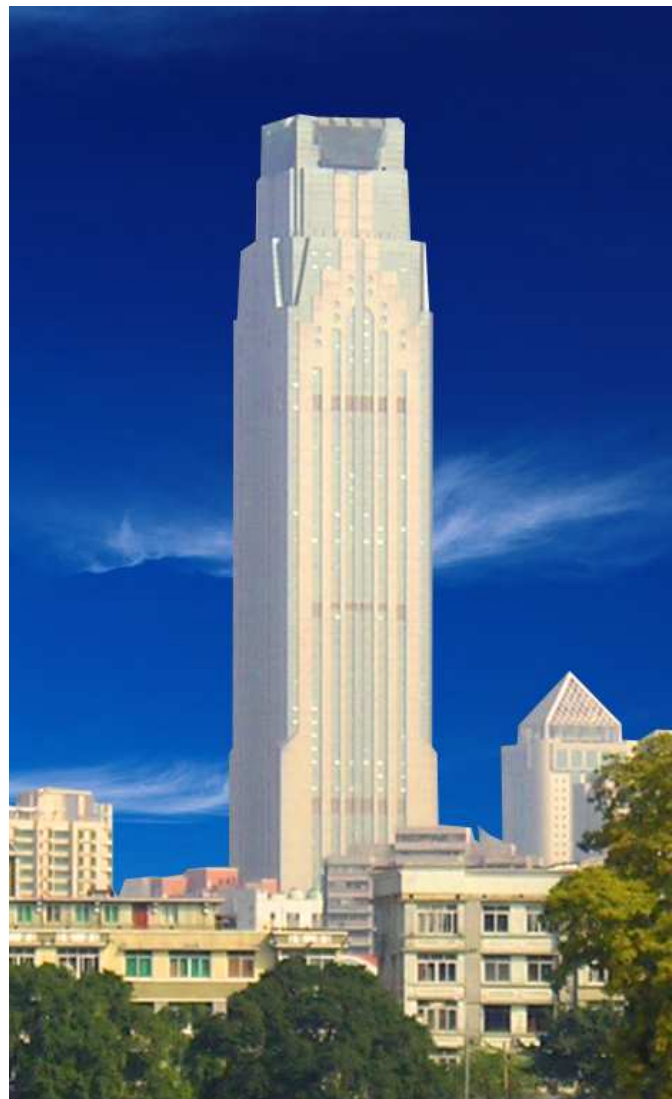
Figura 6.24: Guangdong Telecom Plaza, 1997-2003, sede de la filial de China Telecom en Guangdong. Fuente: skyscrapers.cn
