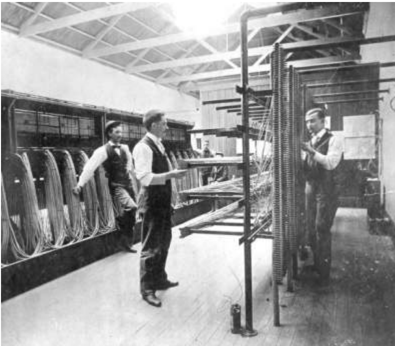
Figura 2.18. En esta imagen de principios del siglo XX, unos operarios están empezando a trabajar en un pequeño repartidor, aun prácticamente vacío de cables. A la izquierda están los equipos de conmutación manual abiertos.
