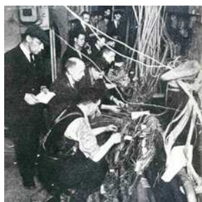
Figura 3.194: Reparación urgente en una central bombardeada.
