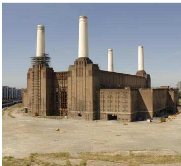
Figura 3.161: Battersea Power Station, Londres, 1930-1940. Giles G. Scott. Fotografía de autor desconocido.
