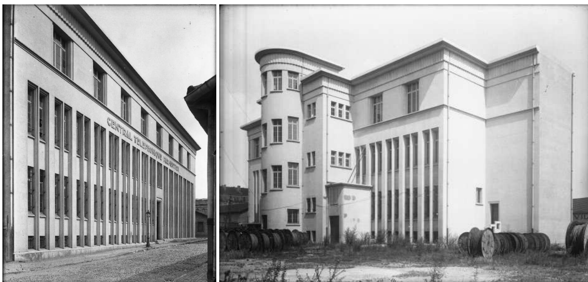
Figura 3.171: Izquierda, central Parmentier , Lyon, 1930, Charles Meysson. Fuente: Bibliothèque municipale de Lyon.
