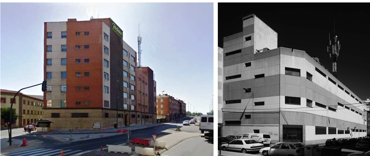
Figura 5.182: A la izquierda, León "Corredera", 1972 (edificio original en primer plano), Ramón Cañas Represa. Google Street View . A la derecha, Ferrol "Inferniño", Ramón Cañas Represa. Fuente: COAG .
