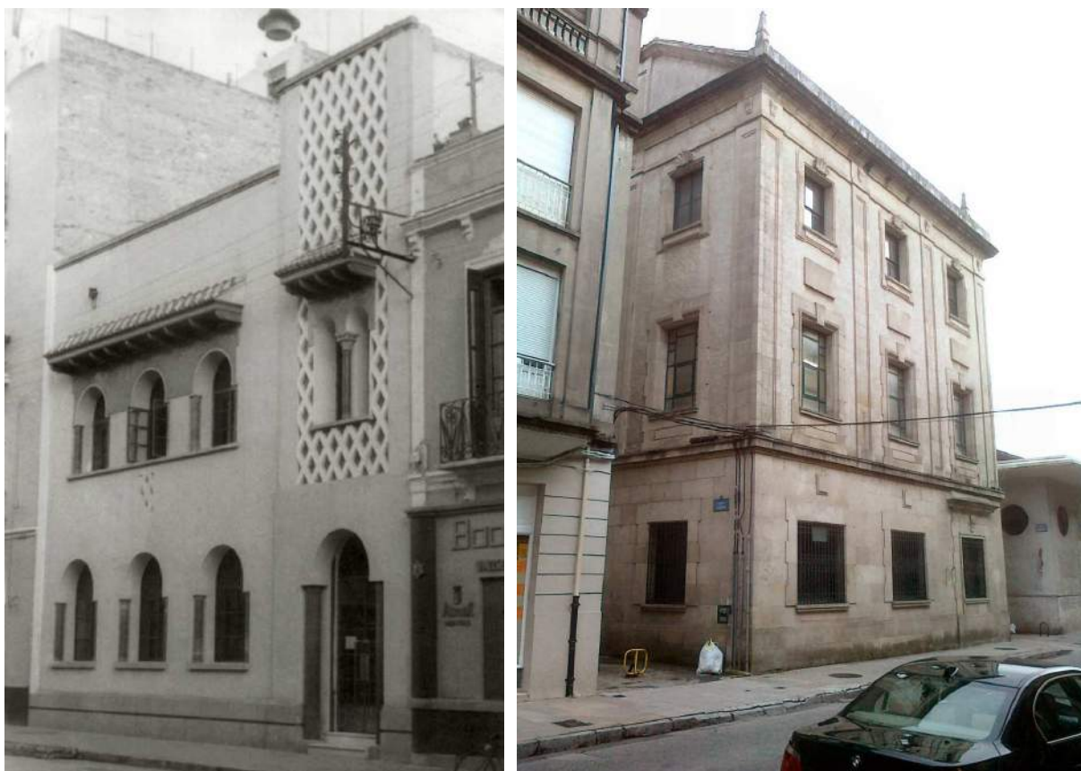
Figura 5.57: Izquierda, central de Melilla, 1946, José María de la Vega y Paulino J. Gayo Notario, Archivo Histórico Fotográfico de Telefónica . Derecha, central de Lugo, 1950-1951, de los mismos autores 93 . Las ventanas del segundo piso se adornan con conchas de vieira. Colección propia del autor .
