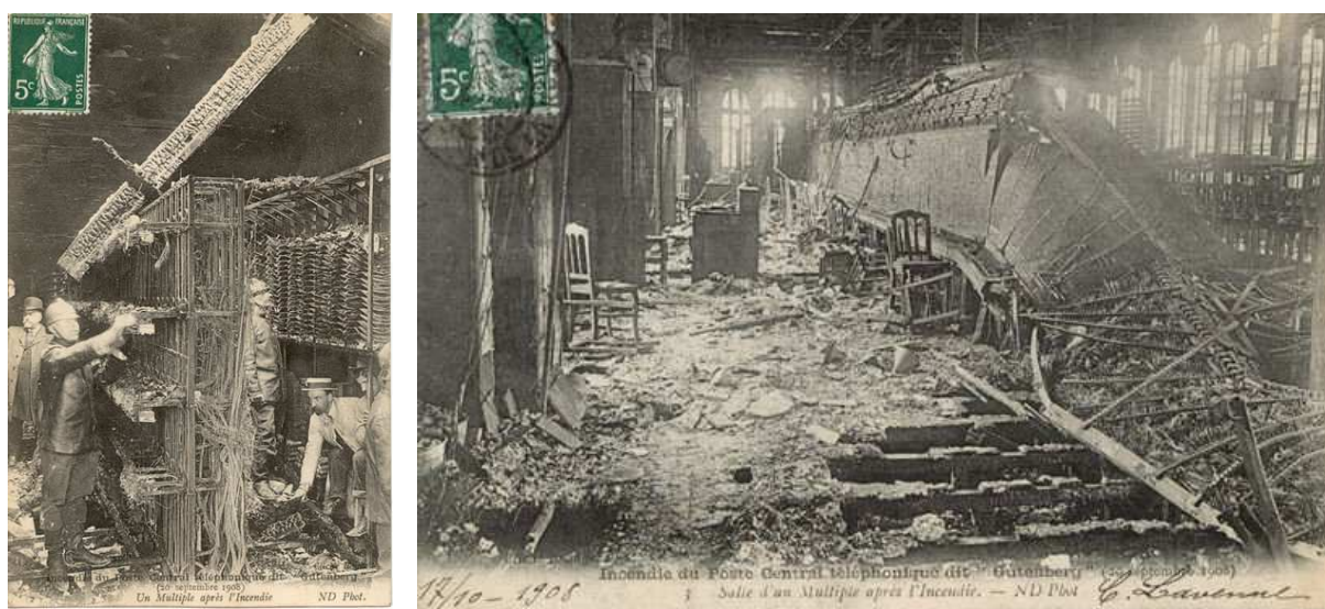
Figura 3.151: Dos postales de 1908 con la destrucción total del interior de la central Gutenberg de París como resultado de un incendio. Colección de Jean Godi.
