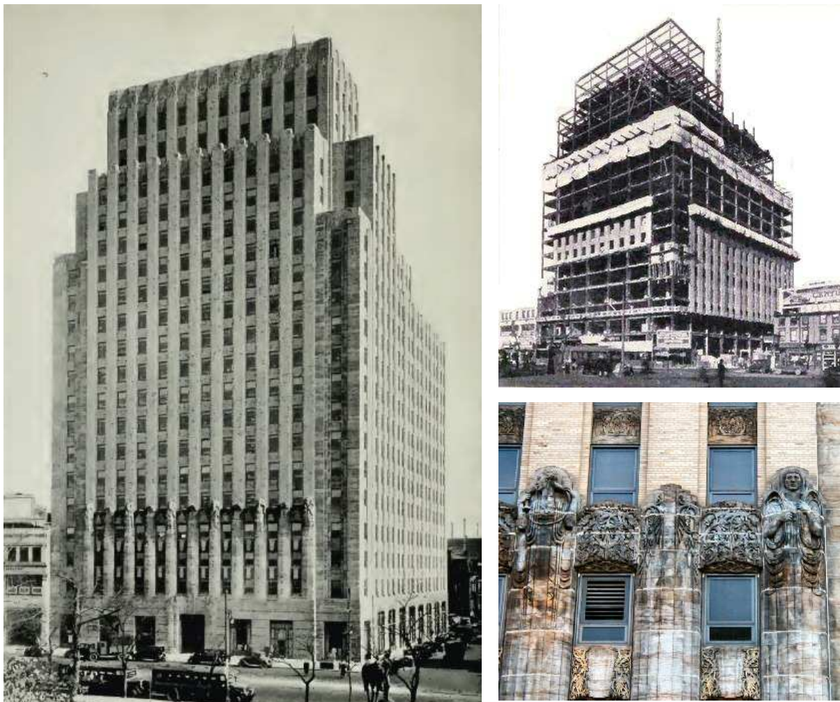
Figura 3.78: New Jersey Telephone Co. , Newark, 1927-1929, Ralph Thomas Walker. A la izquierda, fotografía publicada en The Bell Telephone Quarterly , (Coe, 1929, p. 203). Arriba, a la derecha, durante su construcción. Las lonas, con calefacción interior, se instalaban para mantener una temperatura apta para el fraguado del cemento en los meses de invierno. (Starrett, 1929, p. 223). Debajo: mujer hablando por teléfono y lineman de Edward McCartan. Fotografía: Colin Rose.
