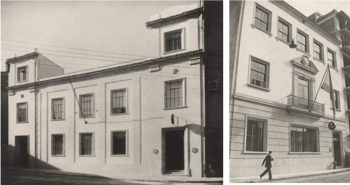
Figura 5.55: Izquierda, central de Torrelavega (Cantabria), 1954, Departamento de Edificaciones. Derecha, central telefónica de Avilés (Asturias), 1953, Departamento de Edificaciones. Archivo Histórico Fotográfico de Telefónica.
