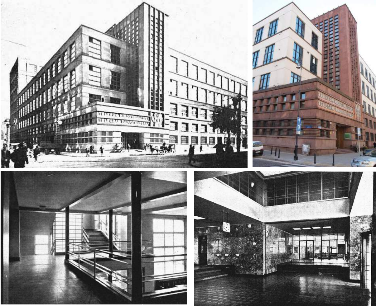
Figura 3.202: Edificio de telecomunicaciones de Varsovia (Polonia), 1928-1924, Julian Puterman. Arriba, vista general en 1934 y en la actualidad. Abajo, detalle de uno de los pasillos y del vestíbulo principal. Las fotografías aparecen en el artículo de Puterman de 1934, excepto la actual, de Colin Rose.
