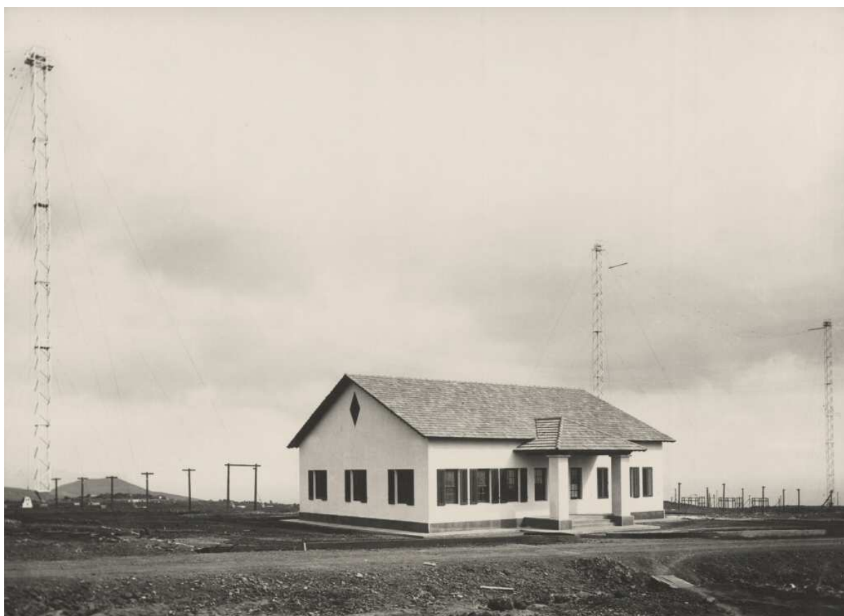
Figura 5.47: Estación radiotelefónica en El Tablero (Tenerife), 1944, Departamento de Edificaciones. Este enlace fue uno de los primeros frutos de la colaboración norteamericana, aun antes de finalizar la Guerra Mundial. Archivo Histórico Fotográfico de Telefónica.
