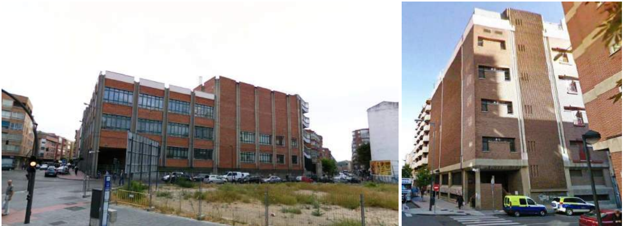
Figura 5.148: A la izquierda, Valladolid “Vadillos”, 1974, Damián Galmés de Fuentes y Manuel García Guerra. Google Street View . Derecha, Derecha, Zamora “Avenida”, 1972, mismos autores. Google Street View .
