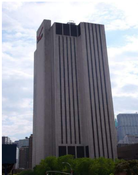
Figura 5.82: Verizon (originalmente NYTC), central de Pearl Street, Nueva York, 1972-1976, Rose, Beaton & Rose. Fotografía: Jack Cheng.
