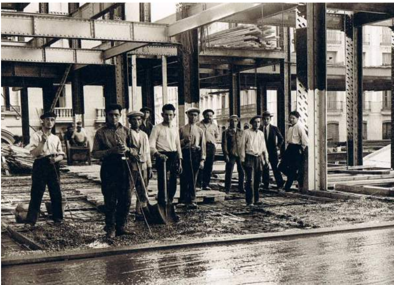
Figura 4.68: Izquierda, hormigonado de una de las plantas. Fotografía de Alfonso, 1928. Derecha: esquema original del encofrado ignífugo. Archivo Histórico Fotográfico de Telefónica.
