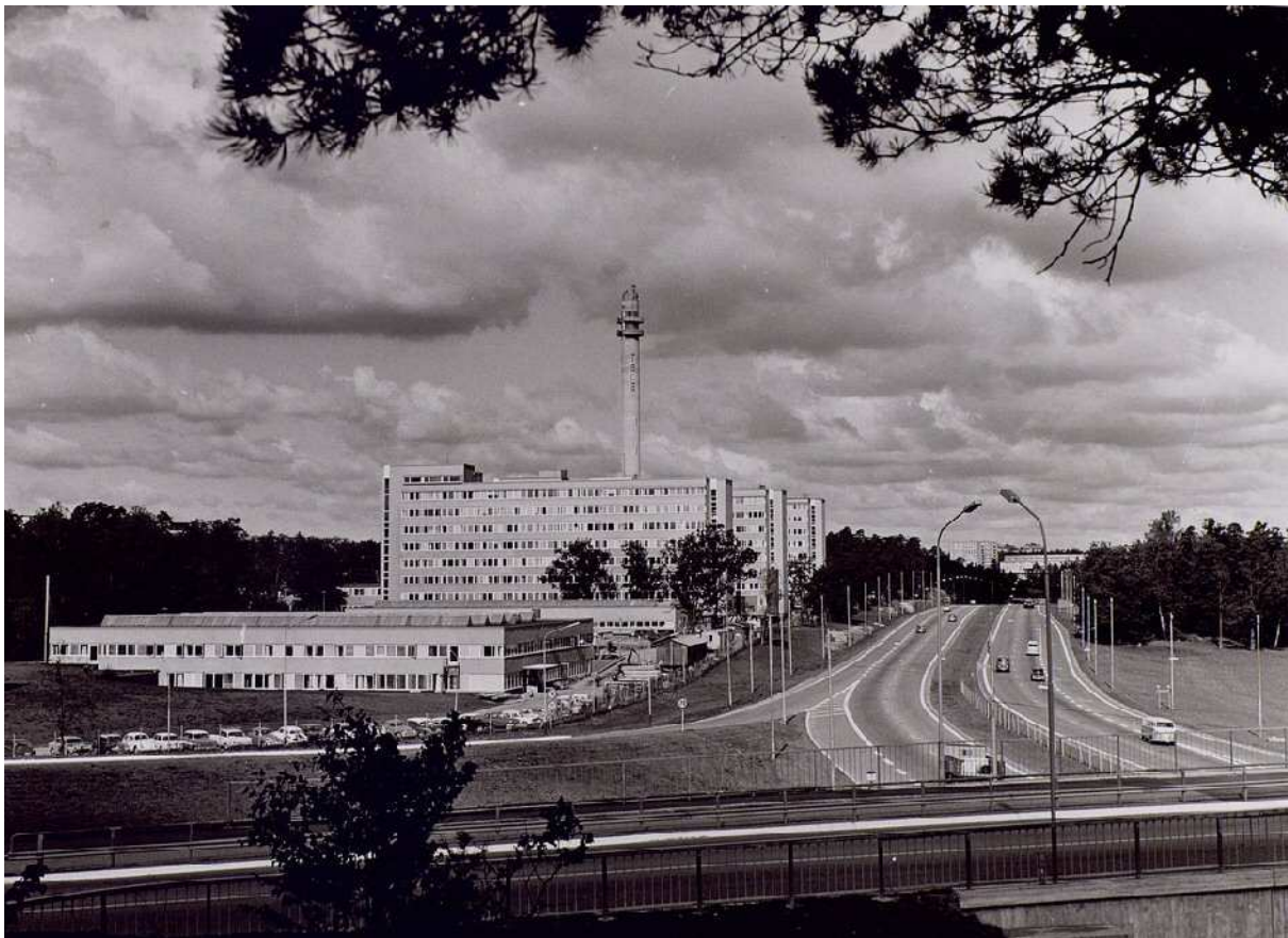
Figura 5.66: Arriba, a la izquierda, torres norte (en primer plano) y sur de la Alberta Government Telephones (hoy Telus ) en Edmonton (Canadá), 1969 y 1971, Rule and Wynn 102 . Fotografía: Sarah Blu . A la derecha, ampliación de la sede de Michigan Bell en Detroit, 1974, Smith, Hinchman & Grylls . Fotografía: Wayne Burkett . Abajo, sede central del Televerket sueco, en Farsta, cerca de Estocolmo, 1961-1969, Gösta Danielsson y Bengt Hidemark . Fuente: Telestyrelsen Farsta .
