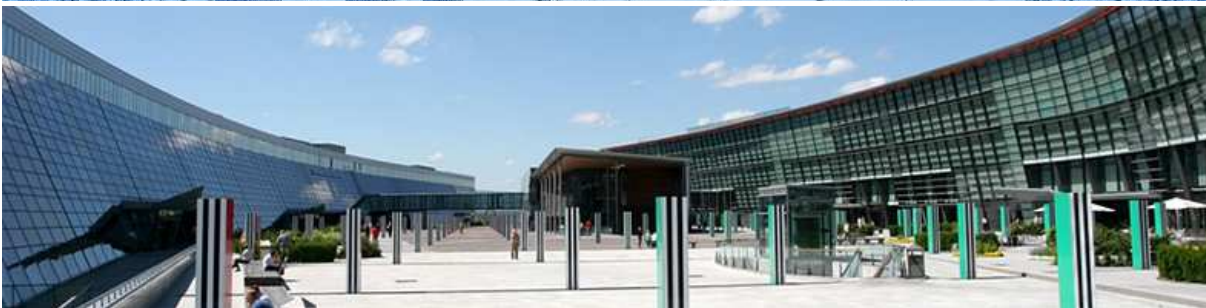
Figura 6.31: Campus de Telenor en Fornebu (Oslo), 1999-2002, NBBJ . Fila superior, infografía del proyecto y vista interior de uno de los edificios. Fotografía: Christian Richters . En el centro, un día de nieve. Abajo, la plaza central con algunas de las estelas de Daniel Buren. En la parte superior de los edificios de la derecha se ve el luminoso de Jenny Holzer. Fuente: Telenor .
