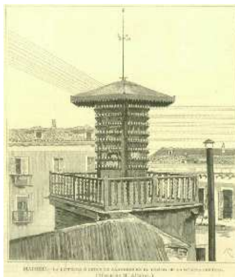
Figura 4.5: Torre de cableado de la primera central telefónica de Madrid. Dibujo de Manuel Alcázar. (Foronda, 1886, p. 192). Fuente: Biblioteca Virtual Miguel de Cervantes.
