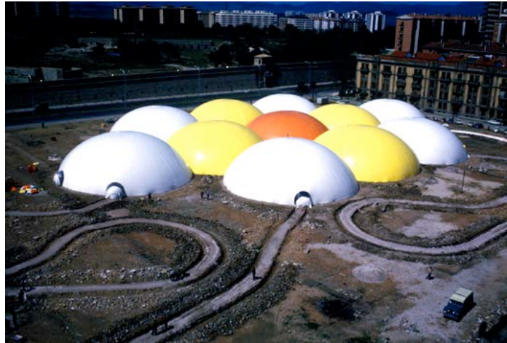
José Miguel de Prada Poole, Cúpulas neumáticas , construcción-instalación, 1972.
