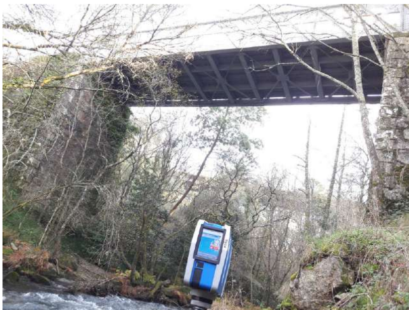
Figura 6.36 Imagen del escaneo con el láser Faro Focus3D X 330 del puente férreo del río Gadanha.
