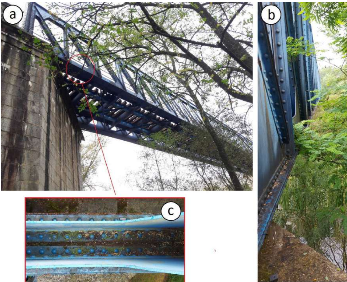
Figura 6.43 Detalle de exterior del puente de A Fillaboa. a) Vista de la parte inferior y exterior derecha del puente. b) Vista de detalle de la parte exterior derecha del puente. c) Vista en detalle del cordón inferior del puente donde se anclará la plataforma.
