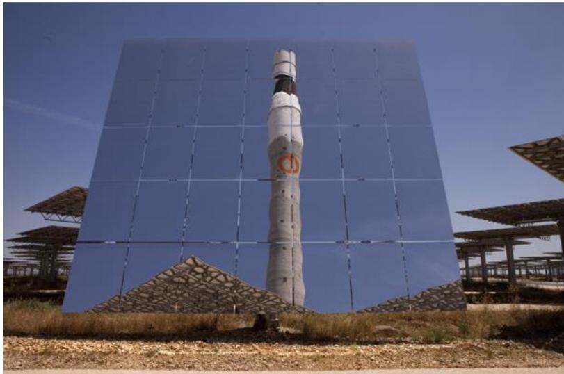
Figura 2.7. Heliostato diseñado por SENER en la planta Gemasolar - Fuentes de Andalucía (Sevilla).
