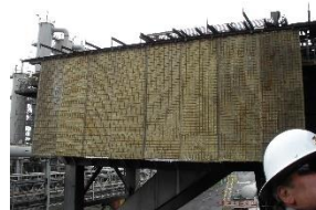
Figura 3.17. Aislamiento de zona de reparación. Fuente Imasa.
