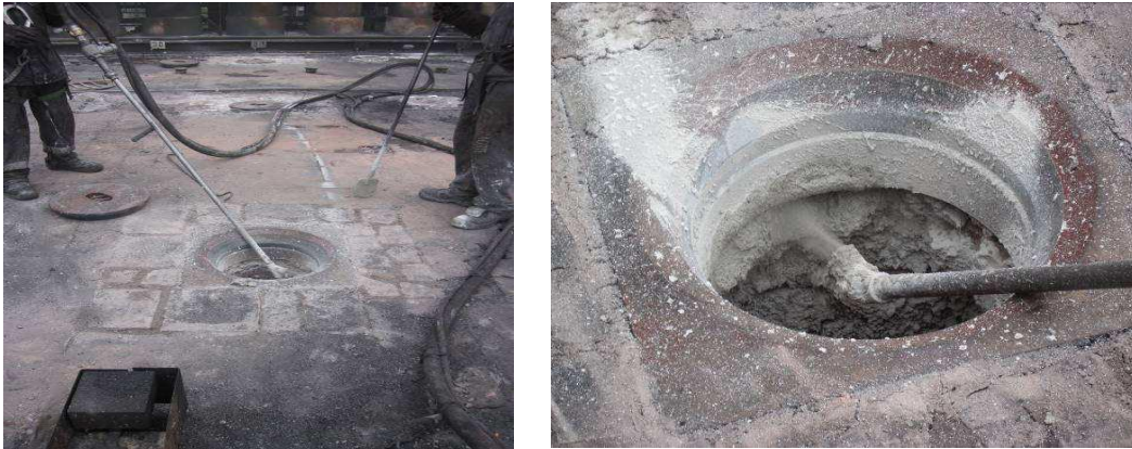
Figura 3.3. Gunitado de bocas de carga de horno. Fuente Pasek.
