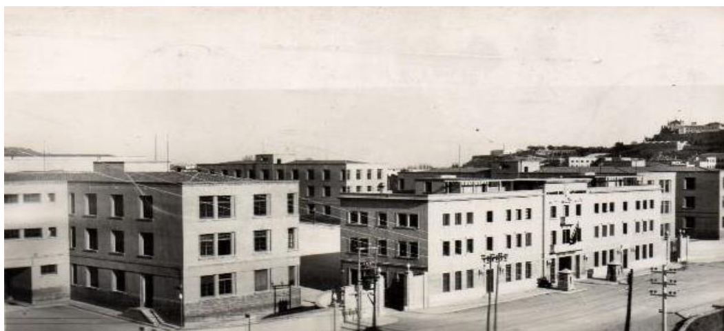
Imagen 9: Tarragona, cuartel General Contreras 311
