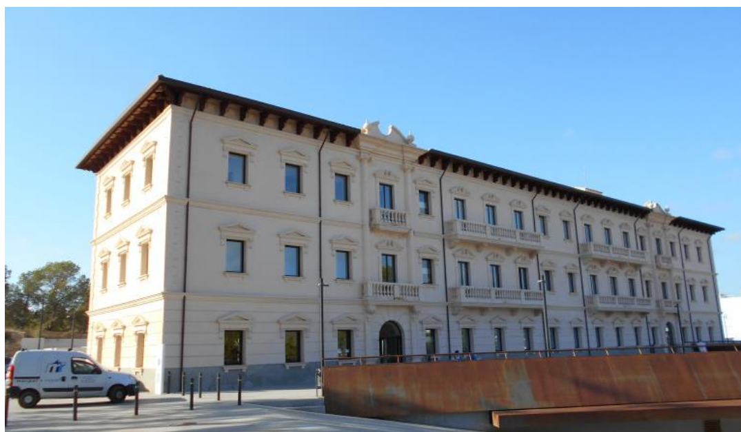
Imagen 88: Ibiza, Comandancia Militar rehabilitada 453
