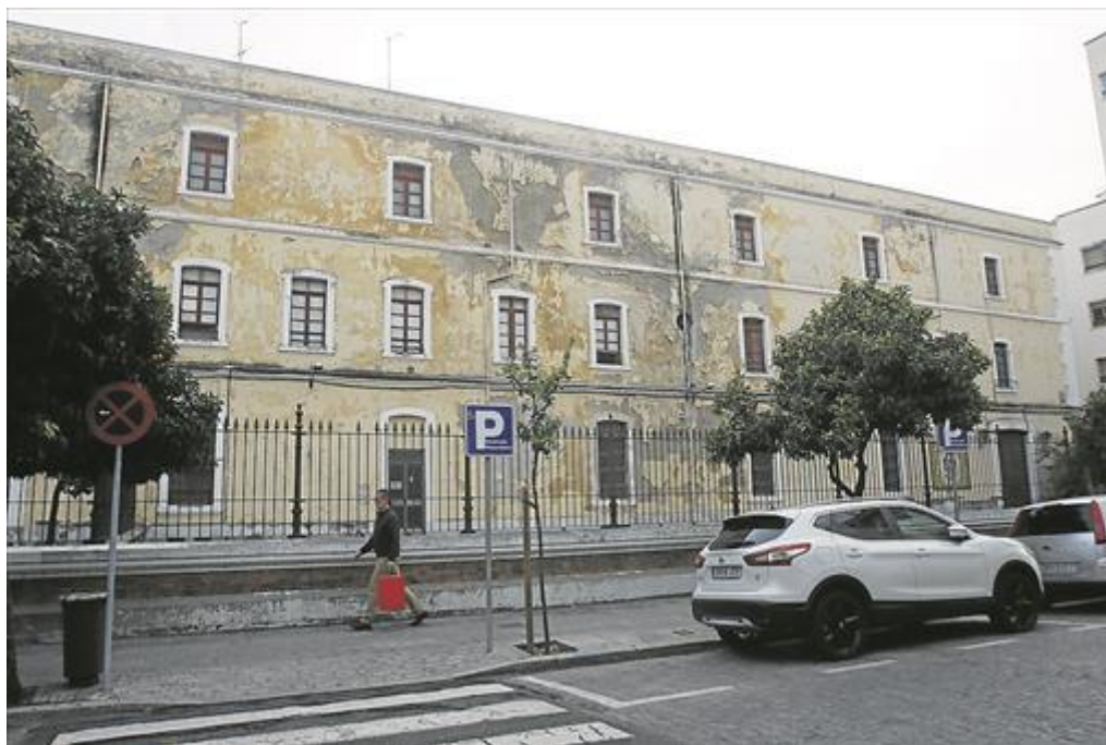
Imagen 35: Córdoba, el Cuartel de la Trinidad. Estado actual 352
