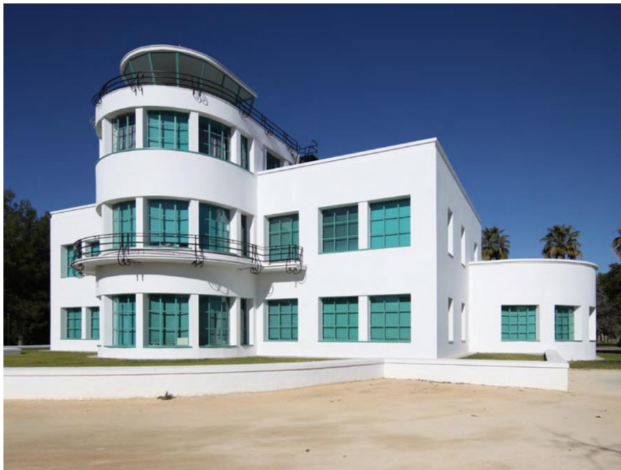
Imagen 74: Alicante, vista actual del Edificio de la Torre de Control 419
