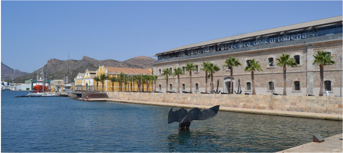
Imagen 57: Cartagena, vista actual del Cuartel de Instrucción de Marinería
