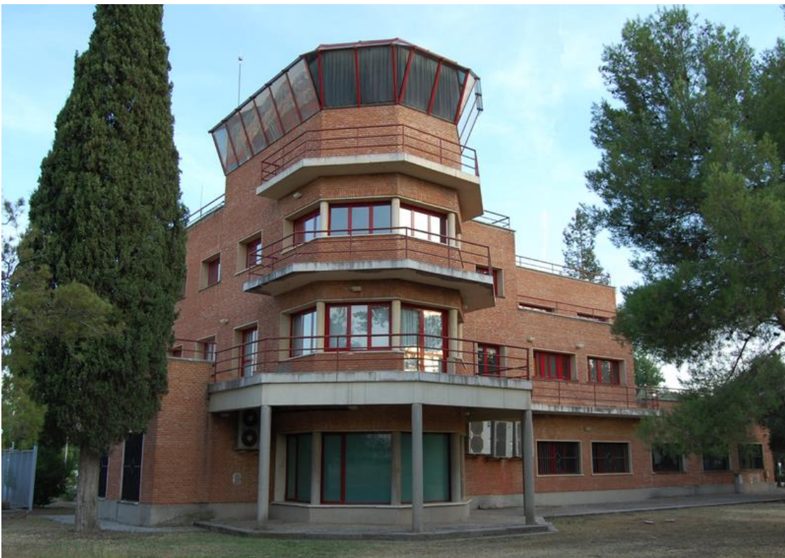
Imagen 112: Alcalá, Servicios Informáticos de la Universidad en la Torre de Control 516
