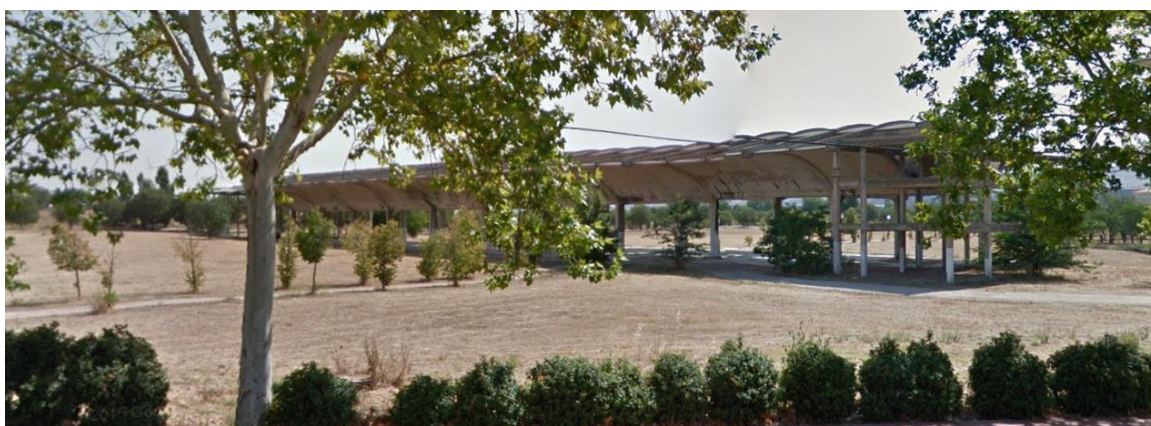
Imagen 110: Alcalá, vista actual de los hangares del Aeródromo
