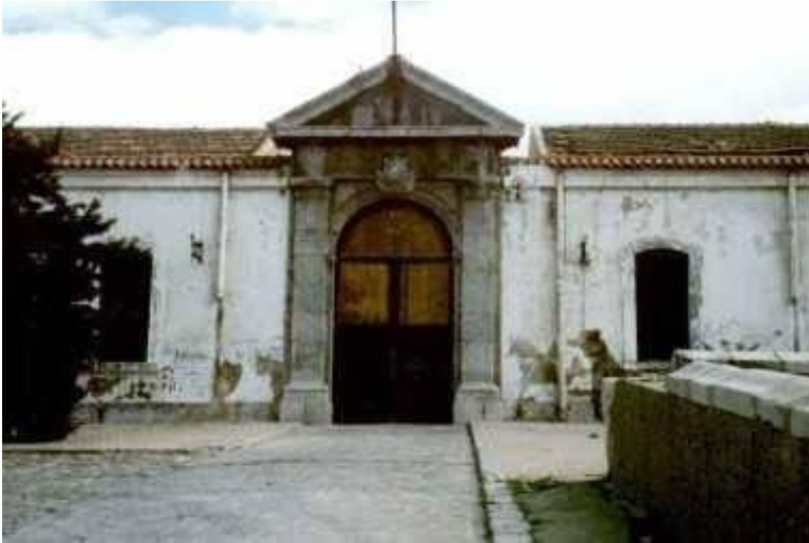
Imagen 53: Cartagena, entrada al Cuartel de Antigones antes de la rehabilitación 377
