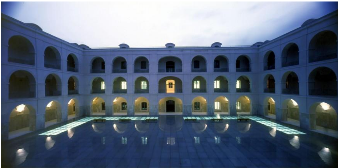
Imagen 50: Cartagena, vista actual del patio interior del Hospital de Marina 370
