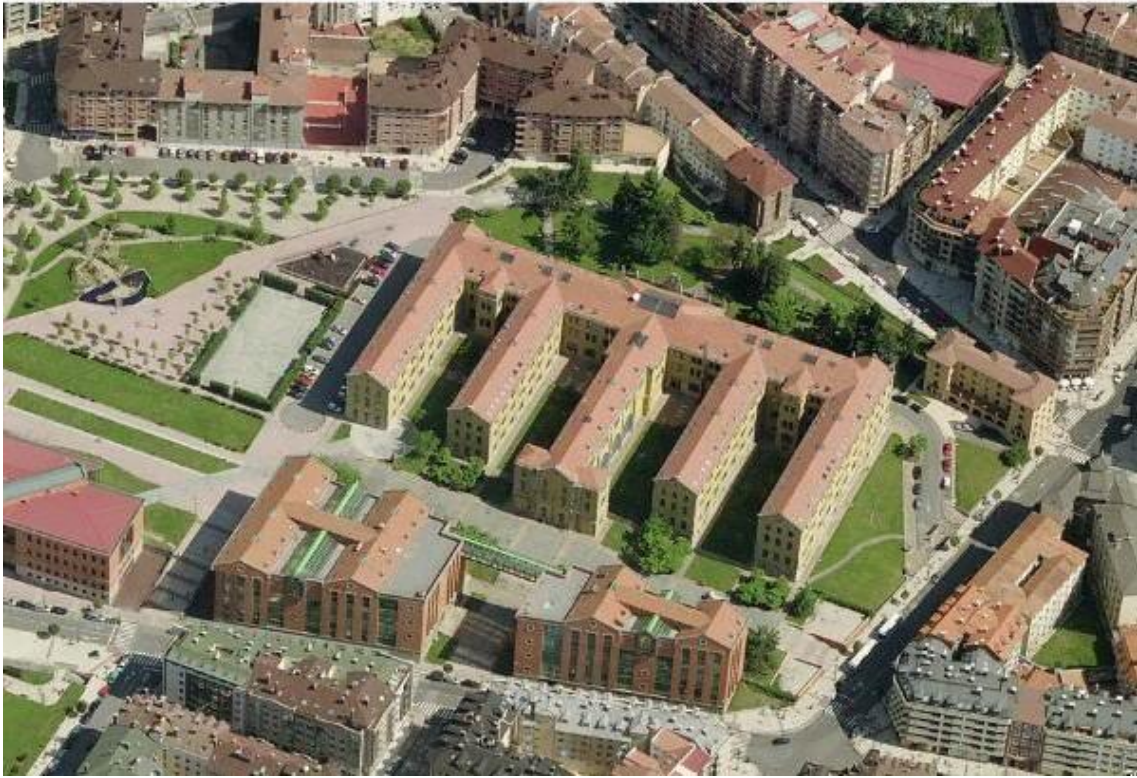
Imagen 40: Oviedo, vista actual del Campus del Milán
