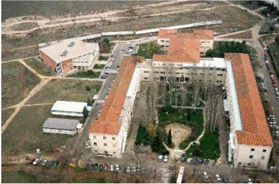
Imagen 113: Alcalá, edificios militares en el Aeródromo 517
