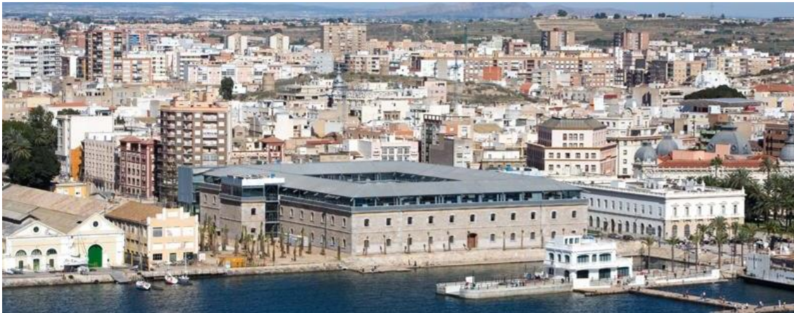
Imagen 56: Cartagena, cuartel de Instrucción de Marinería tras su rehabilitación 386
