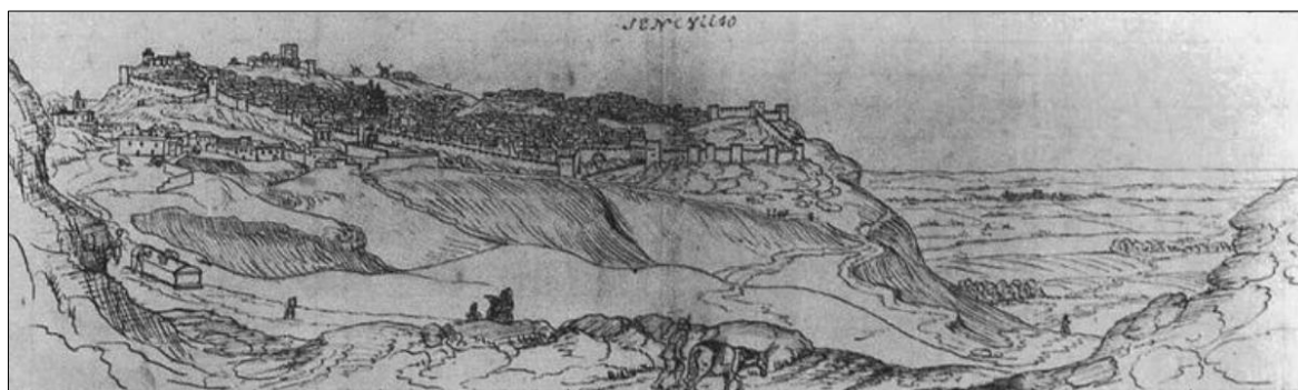
Figura 3. 13. Vista de Chinchilla de Monte-Aragón de 1563
