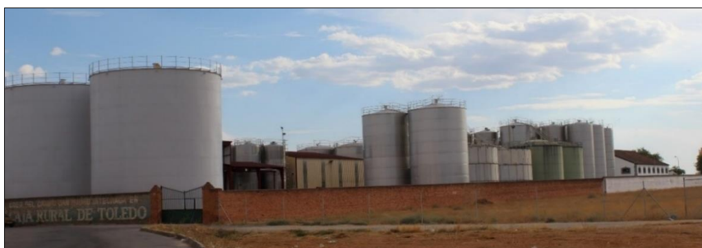
Figura 5. 37. Depósitos de vino y mosto de la Cooperativa del Campo San Isidro
