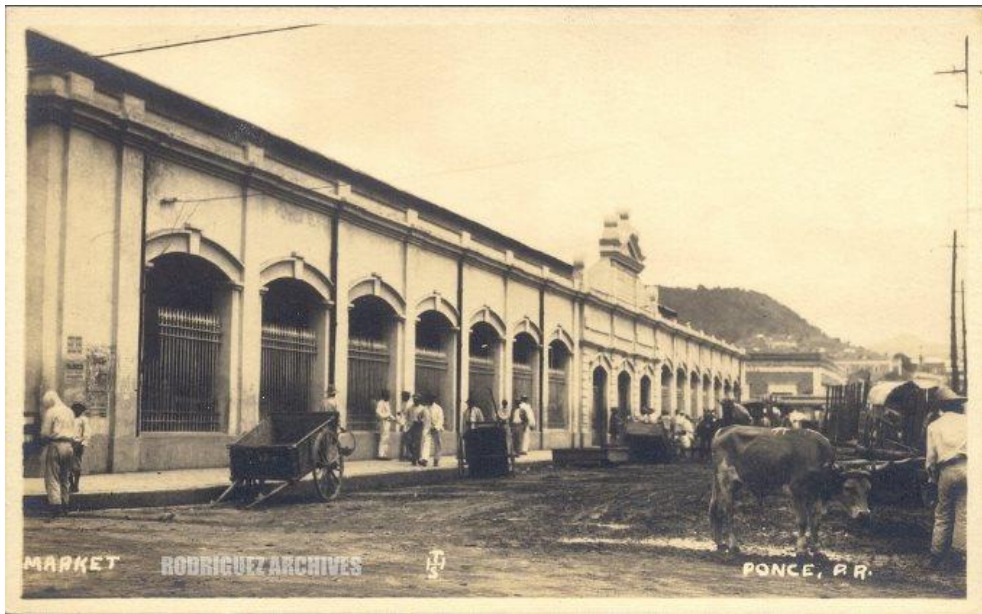
Foto 6. Plaza del Mercado Isabel II. Remodelada a principios del siglo XX con una estructura de hierro.
