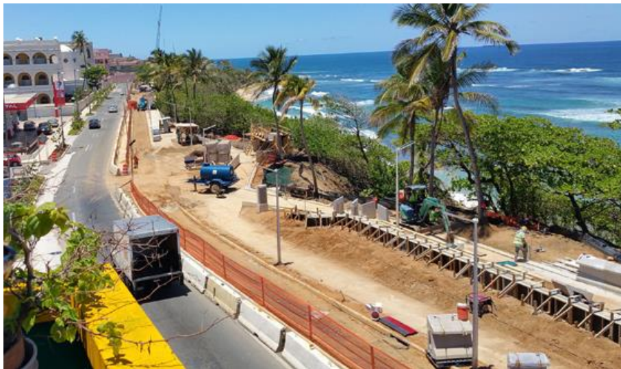
Foto 13. Etapa constructiva del Paseo Lineal de Puerta de Tierra, abril 2016.
