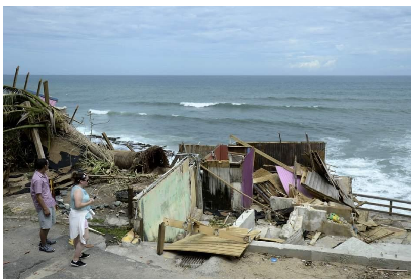
Foto 22. Derrumbe de una edificación en la comunidad de la Perla. Viejo San Juan, 25 de septiembre 2017.
