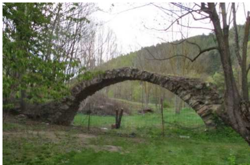
Figura 6.33. Restos del Pont del Diable (Isòvol).
