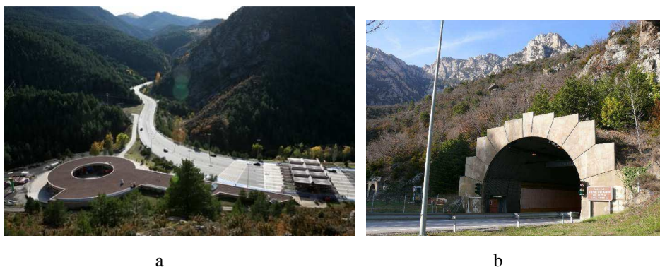
Figura 6.42. Imágenes del Túnel del Cadí.
