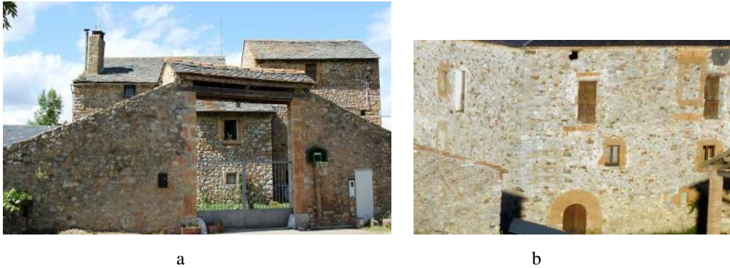
Figura 6.35. Casas de labranza fortificadas: Torre del Cadell (Bellver) (a) y Torre de Riu (b).
