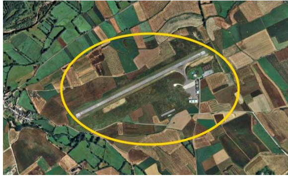
Figura 6.59. Vista aérea del aeródromo de la Cerdanya. (El aeródromo está dentro del óvalo amarillo).
