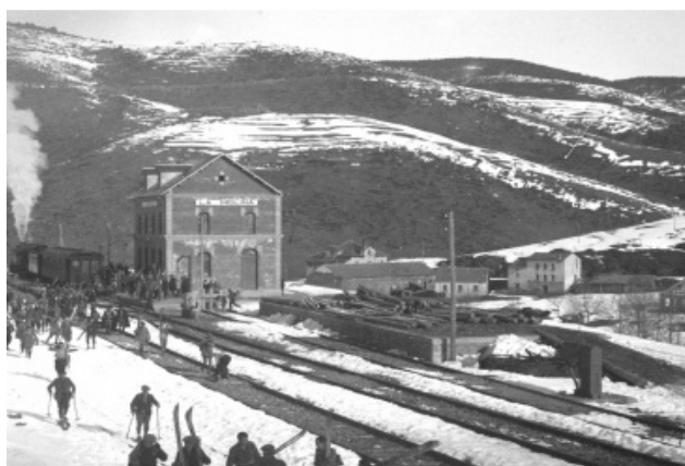
Figura 4.2. Estación de tren de La Molina (Cerdanya) (finales de los años 1920).
