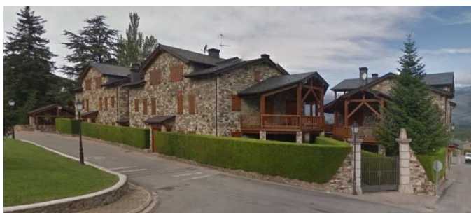
Figura 6.16. Nuevas construcciones residenciales en Queixans.
