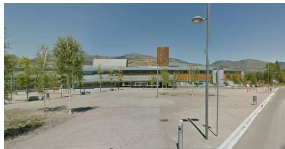
Figura 6.60. Vista del hospital transfronterizo de la Cerdanya.
