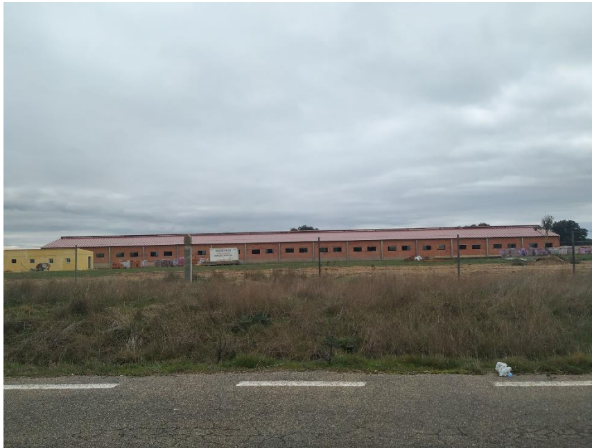
Imagen 7.18: Construcción de una nueva nave ganadera en el término municipal de Villares de Yeltes, comarca de Vitigudino.
