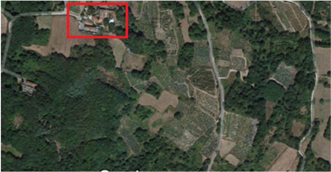
Panorámica aérea de Castellón (San Vicente) (Figura 18)
