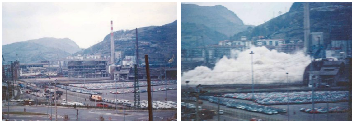
En la entrada de Lezo desde el que se puede ver el edificio de Quincasa antes y después de su voladura (16 de diciembre de 1988). Fuente: Archivo de Errenteria. A010F029 y A010F030.
