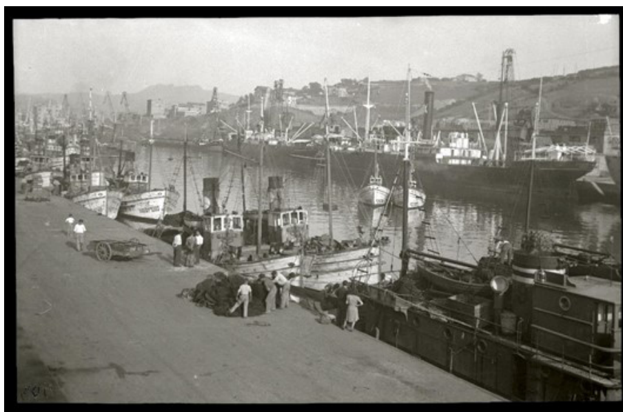
Ilustración 101. Barcos y trabajadores en el muelle de La Herrera (1940-1948)
