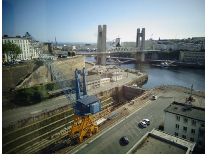
Ilustración 197. Dique seco, puerto militar de Brest
