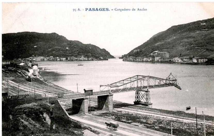
Ilustración 98. Cargadero de mineral de Antxo
