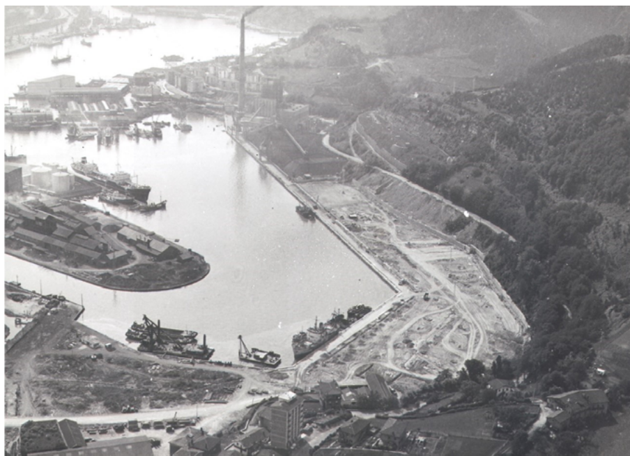
Construcción de los muelles Lezo 1, 2 y 3. Al frente Lezo. Fuente: Archivo de la Autoridad Portuaria de Pasaia. 10.2.012-45_m_r.
