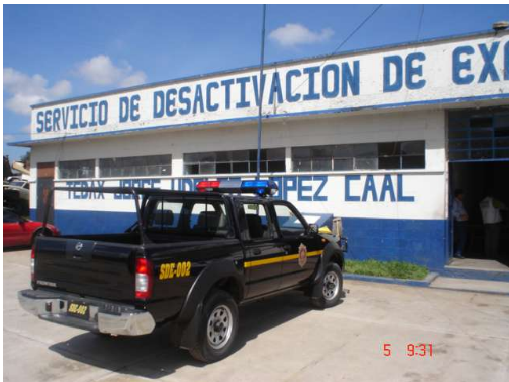
Edificio colindante al archivo donde había explosivos. 5 de julio de 2005 (Foto AHPN)
