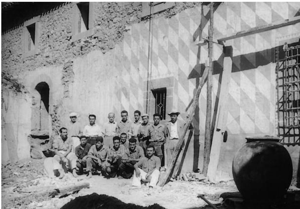
Paramento de la Hospedería en una fotografía de González-Valcárcel. Años 60 del pasado siglo. Picado el revoco a media altura para agrandar los huecos de los vanos superiores y aumentar su número. Todavía no se ha transformado el segundo vano inferior (en el centro) que lo convertira en uno como el de su derecha y la puerta de la izquierda (probablemente la del antiguo refectorio) desaparecerá. Archivo de la familia González-Valcárcel.
