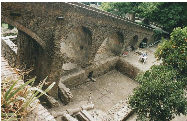
2001. Excavación de la fuente bajo la rampa en la zona del Jardín de la Rampa.
