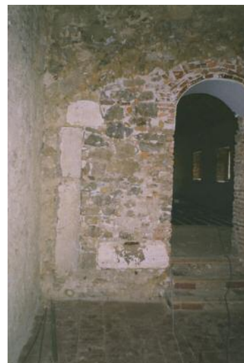
A la izquierda los restos de la jamba izquierda y el dintel de la primitiva puerta de las celdas. Y a la derecha el hueco horadado por González-Valcárcel, tras el cegamiento del original, con un falso paso abovedado.
