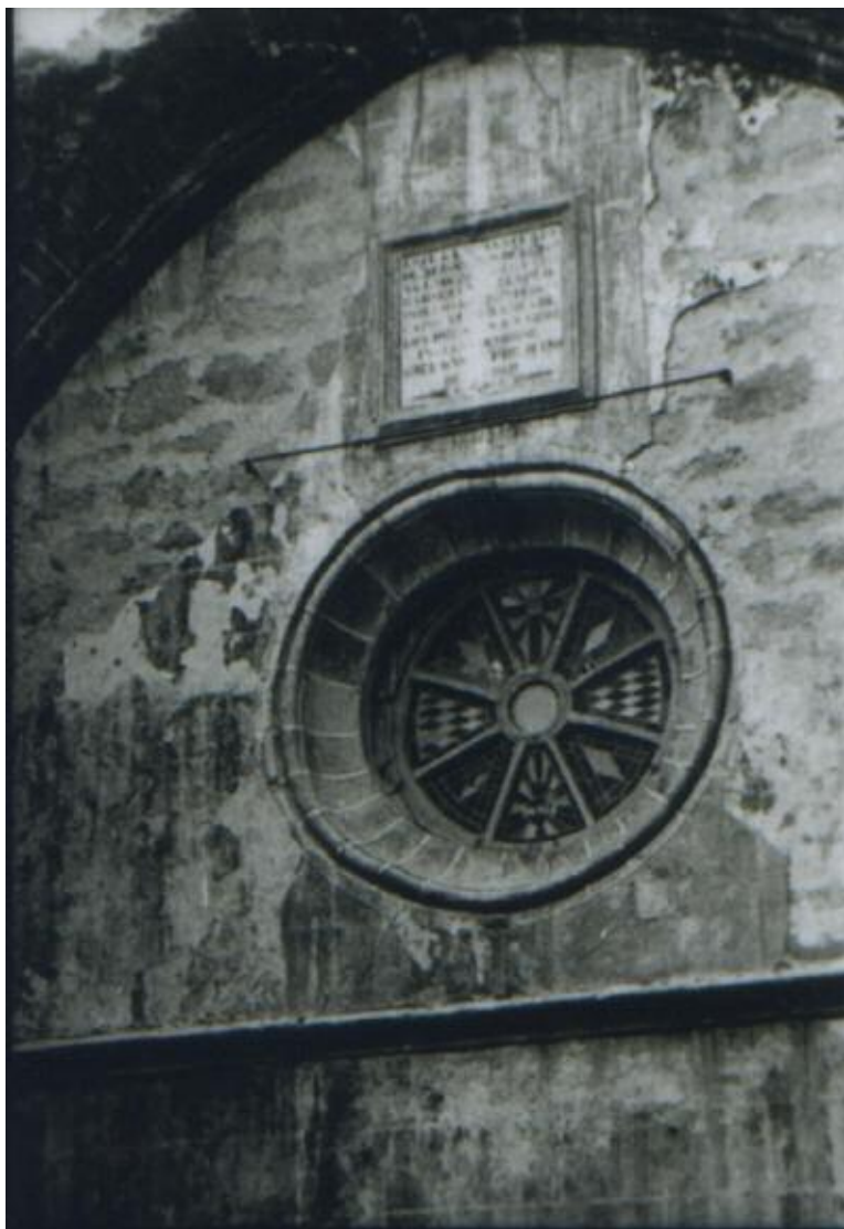
J.M. González Valcarcel. Paramento interior, portada de la iglesia. Restos de diferentes enlucidos y la vidriera del óculo con los vidrios colocados por los Terciarios Capuchinos. ca. 1941. Archivo familia G.V.
