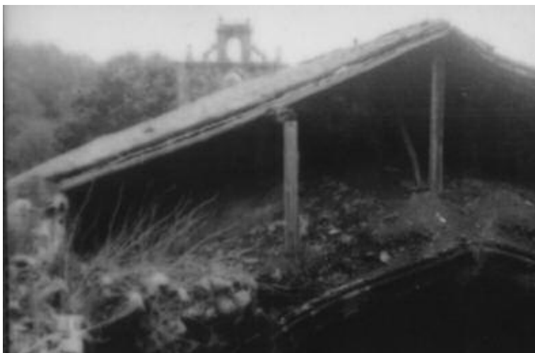
J.M. González Valcarcel. Cubierta de la iglesia y bóveda hundida. ca. 1941. Archivo familia G.V.
