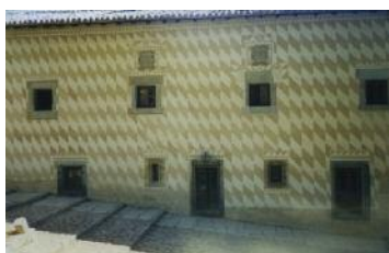
Esgrafiado de la fachada de Procuración. La ventana con la reja del centro originalmente era una puerta que daba acceso a la sala Capitular y Capilla de San Juan.
