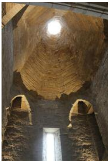
Cocina de la catedral de Santa María la Real, Pamplona, siglo XIV. Bóveda dodecagonal de piedra.
