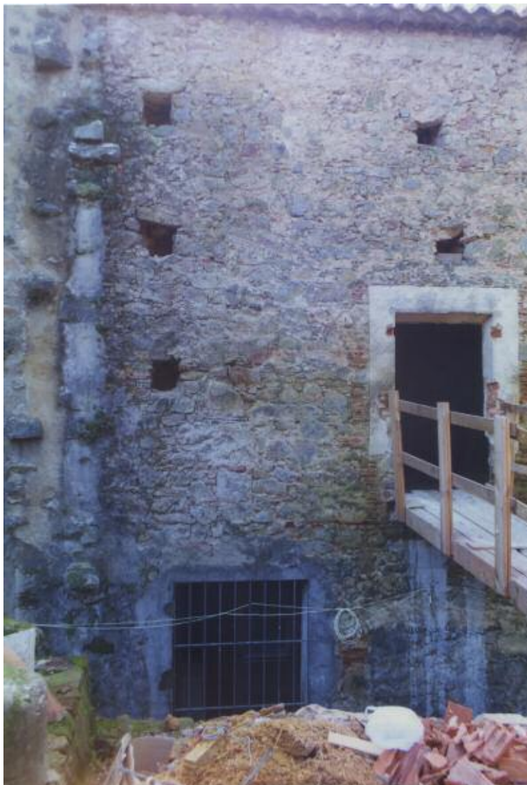
Paramento exterior de la crujía norte. Huella vertical (a la izquierda) del muro de la cocina.
