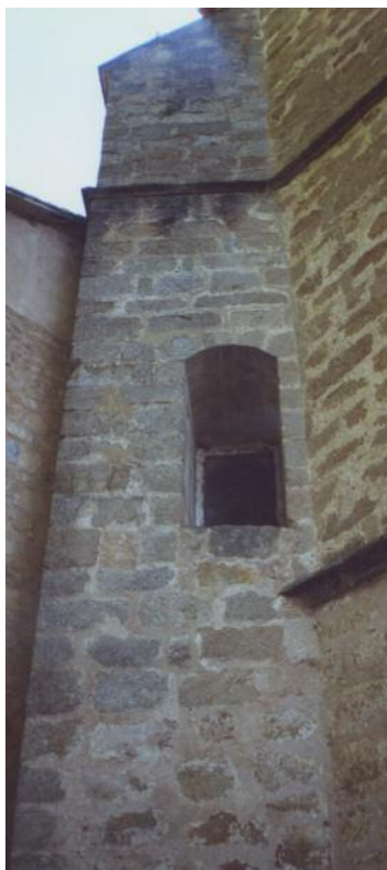
Vano para el paso del corredor a través del contrafuerte del lado norte de la iglesia. Al fondo, en la parte superior del hueco se ven las gorroneas para alojar sendas puertas.
