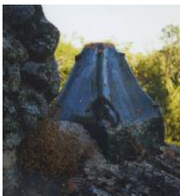
Remates cerámicos sobre la chimenea de la habitación del lado sureste.
