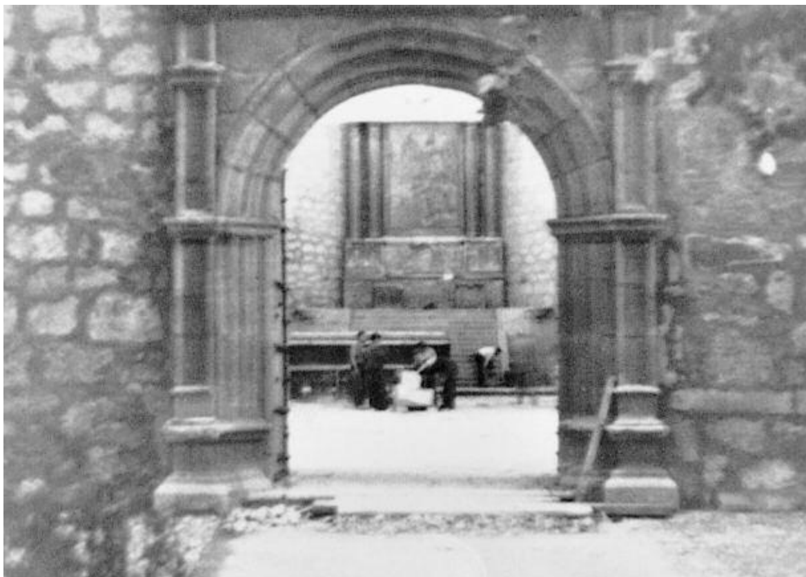
Fotografía de Jose Manuel González Valcárcel durante el proceso de montaje del retablo (1957-1958). Delante de las escaleras del presbiterio los cajones en los que han viajado las diferentes partes del retablo. En la portada de la iglesia, como en el interior, han sido eliminados todos los retos de enlucidos. Archivo de la familia.
