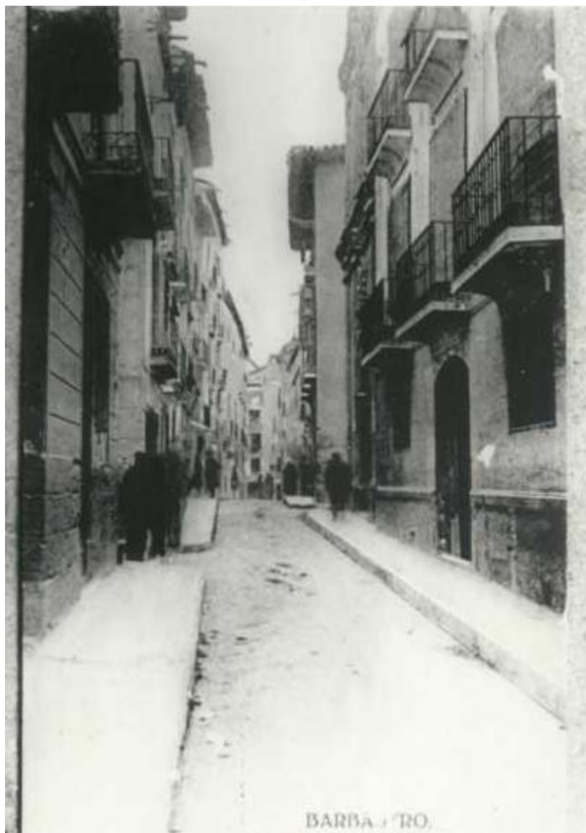
Vista de la Calle Camino de Monzón, actual Joaquín Costa, desde la Iglesia de Santa Lucía hacia el Calle Riancho, actual General Ricardos. (Postal de principios de siglo XX)
