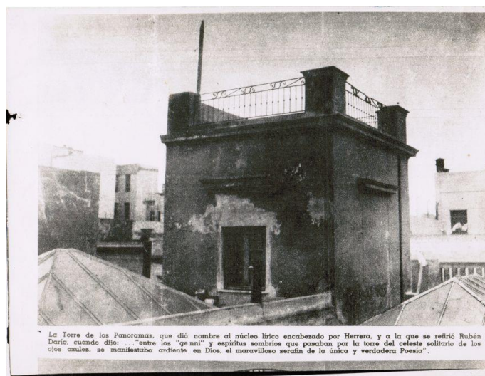
La Torre de los Panoramas en su estado original
