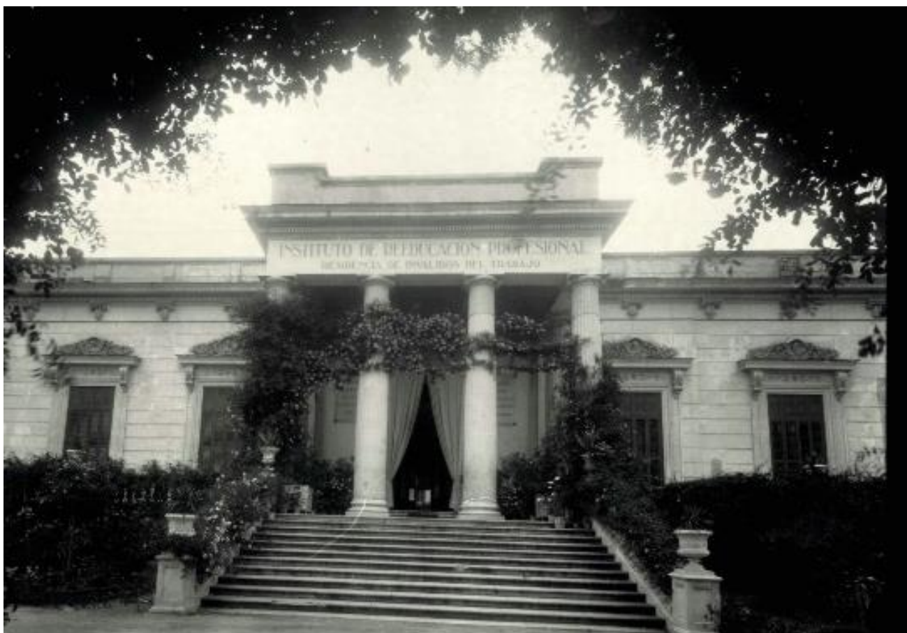
Figura 3. Fachada principal del palacio de Vista Alegre, Carabanchel (Madrid), en cuyo dintel está esculpida la leyenda Instituto de Reeducción Profesional. Residencia de Inválidos el Trabajo.
