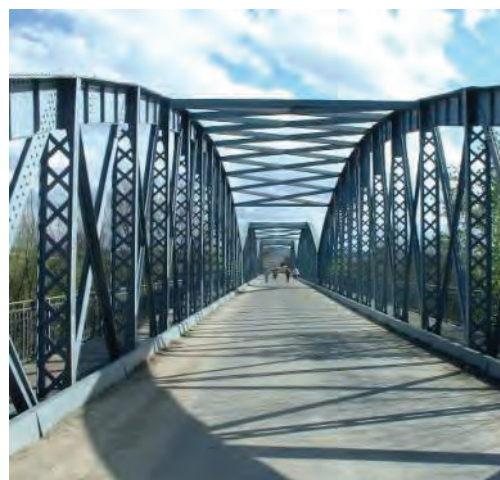
Figura 84 Puente de ferrocarril abandonado en Arganda del Rey (Madrid)
