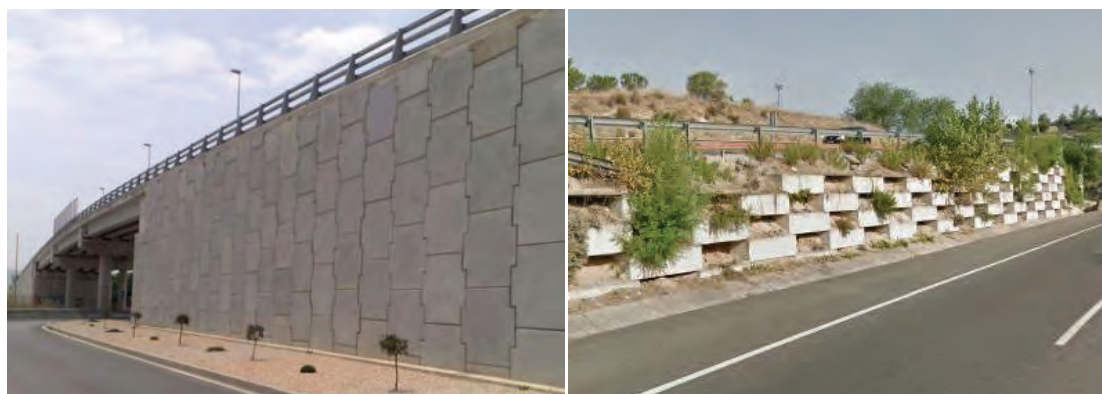
Enlace A-1/M-40, Madrid. Izquierda: Muros prefabricados. Derecha: Muros jardinera (Fuente: Autor)
