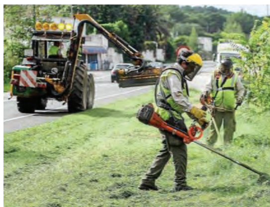
Figura 92 Desbroce en margen de carretera
