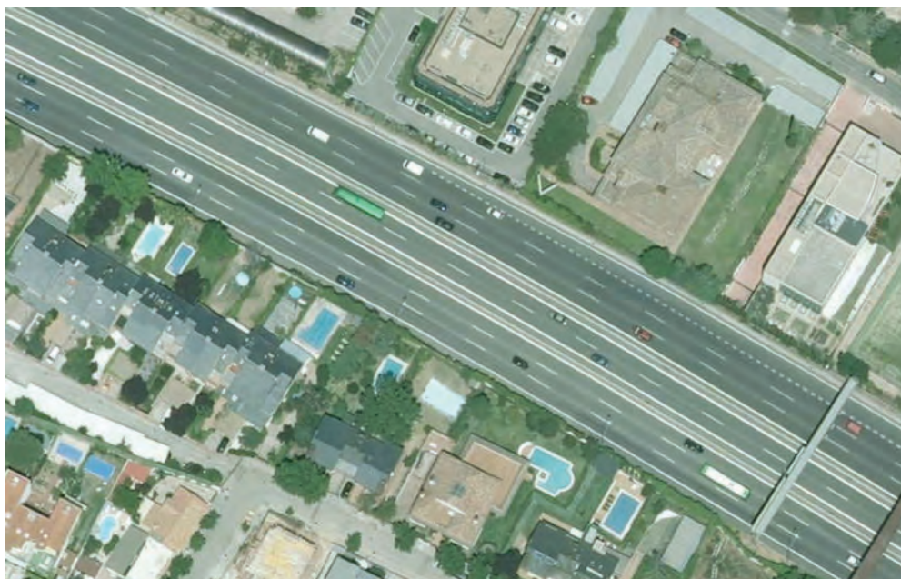
Figura 42 Carril central Bus-VAO en la autovía A-6, entre Madrid y Las Rozas
