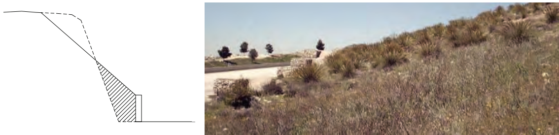
Figura 111 Empleo de muros para tender taludes de desmonte
