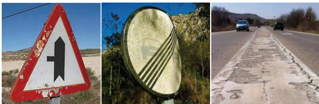
Figura 59 Señales y marcas viales envejecidas
