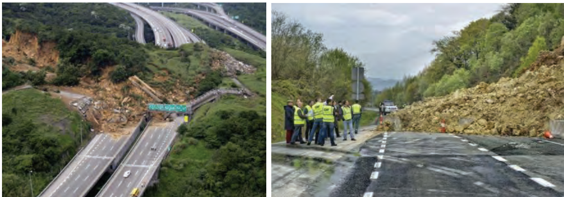
Figura 66 Deslizamientos afectando a carreteras
