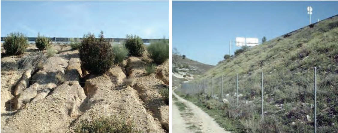
Figura 68 Efectos de la revegetación en la erosión de los taludes de una carretera
