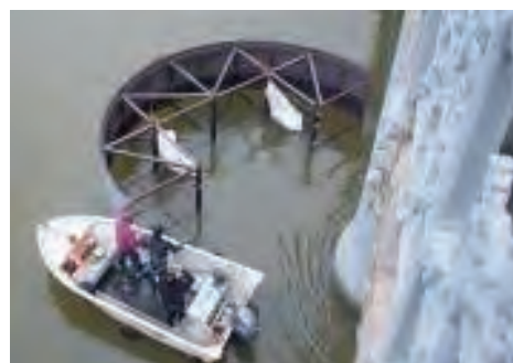
Figura 87 Refuerzo de cimentación
