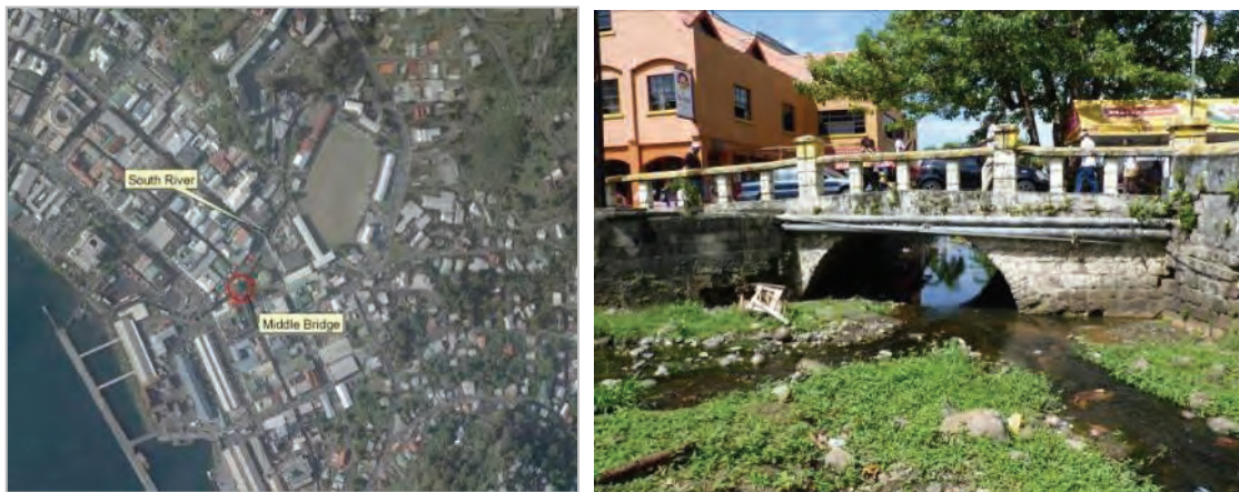
Figura 125 Middle Bridge sobre el South River en Kingstown
