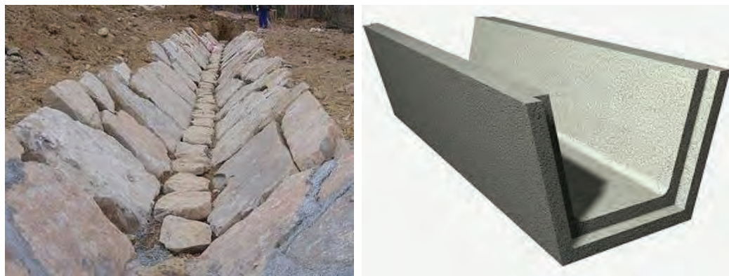
Figura 104 Cunetas de guarda con diferente impacto sobre la fauna
