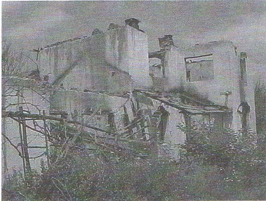
Casa destruida de uno de nuestros refugiados.
