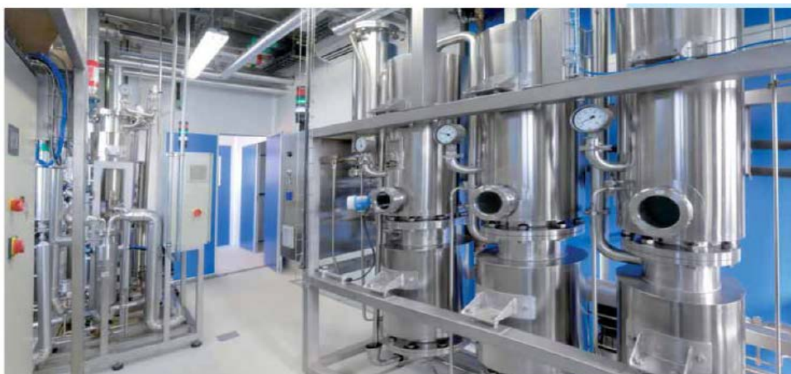
Fig.4.61(b). Planta de producción de Agua para Inyección WFI (en primer término se ven las columnas). Fuente: Telstar Puretech, 2015
