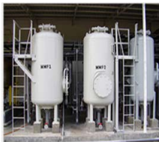
Fig.3.17. Esquema (a) y equipo comercial de un filtro multicapa (MMF) (b).
