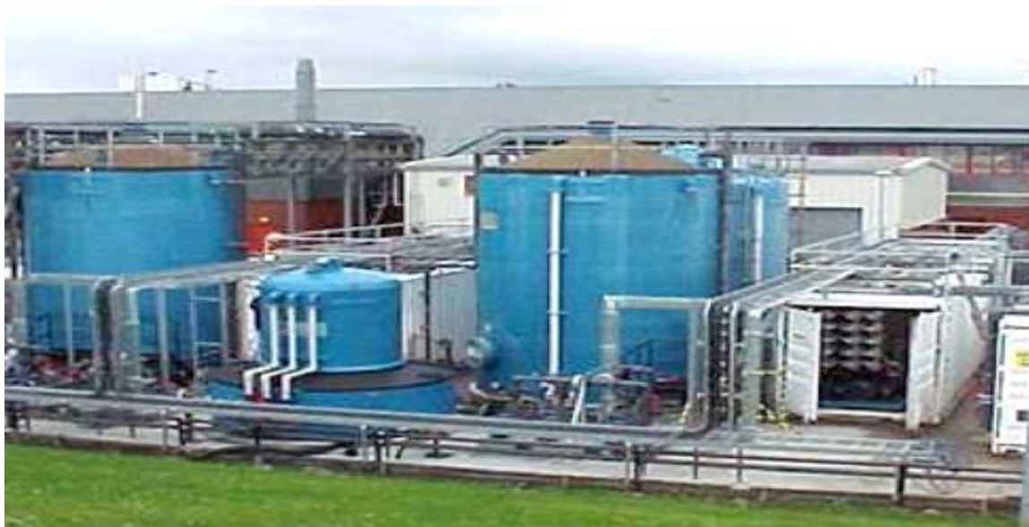
Fig.3.36. Planta de producción de agua ultrapura para la fabricación de obleas (wafer), (GE, 2016).
