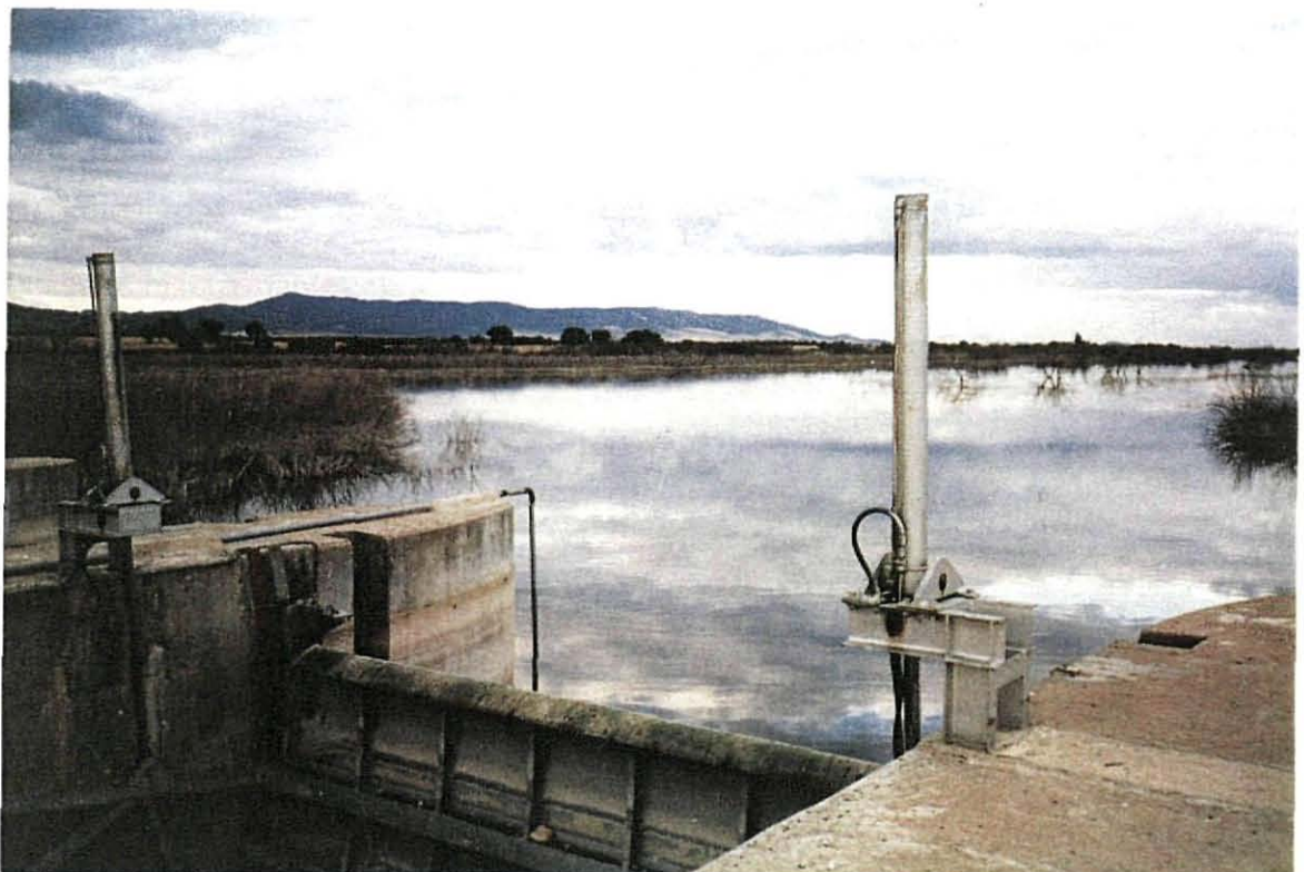
Foto 10 : Presa "ecológica" de Puente Navarro destinada a retener las aguas trasvasadas desde el acueducto Tajo-Segura. Octubre, 1991.
