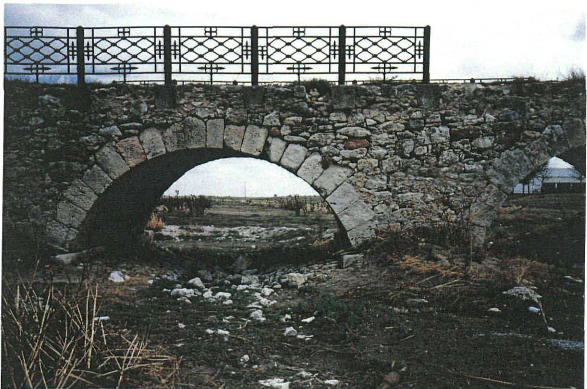
Foto 2 : Cauce seco del río Záncara en el Puente de San Benito (1.991)
