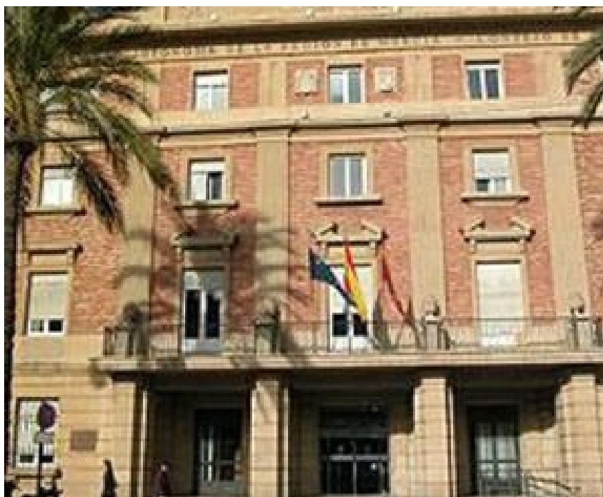
Foto 1: Edificio de la antigua Diputación Provincial de Murcia
