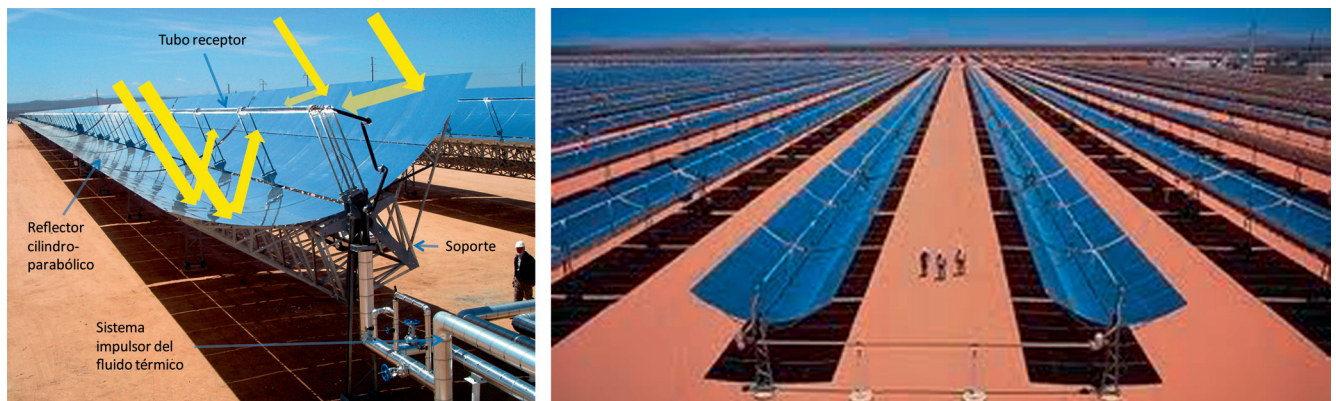
Figura 3. Colector solar y campo solar de tecnología cilindro-parabólica.
