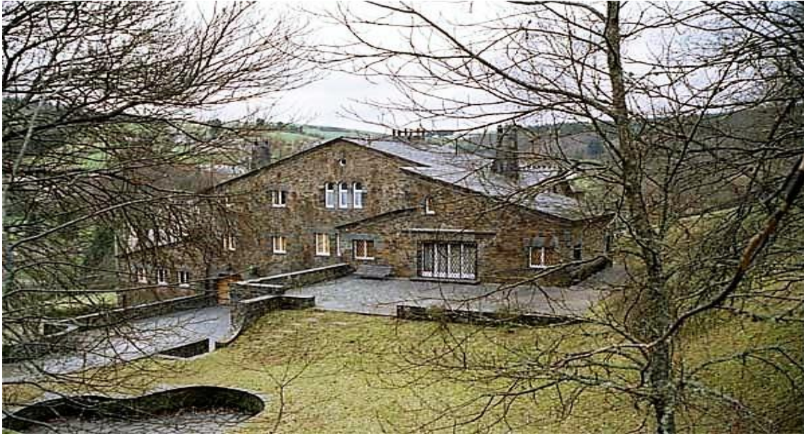
Foto 19: Casa de la Dirección, Grandas de Salime. Fuente: Ayuntamiento de Grandas de Salime ( http://www.grandasdesalime.es/index.php?M1=3&M2=45&CT=7&SC=15&PG=2 ). Consultado el 14 de junio de 2018.
