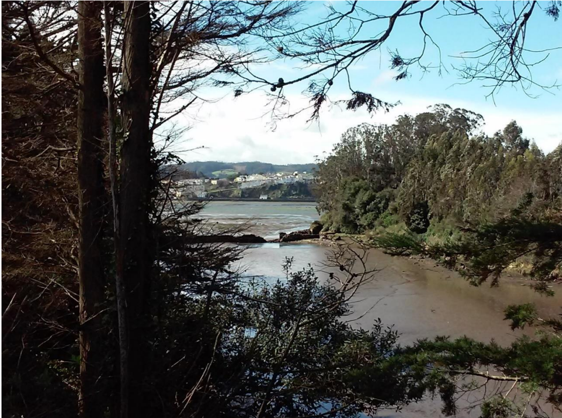
Foto 27: Estado actual del Molín das Acias . Se puede ver la presa y lo que queda del muro de contención de la misma. Al fondo la ría del Eo y el pueblo de Castropol. Fotografía propia.
