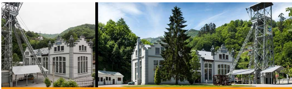
Foto 12: Casa de máquinas y castillete del Pozo San Luis. Fuente: http://www.ecomuseominero.es/pozo-san-luis/index.html . Consultado el 19 de mayo de 2018.
