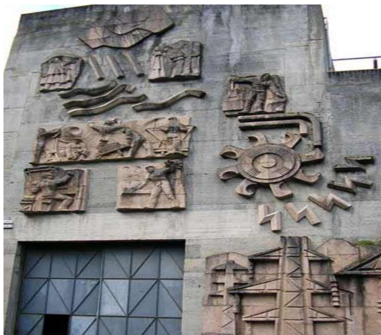
Foto 14: Relieves de hormigón de mármol rojo en la entrada a la central. Fuente: Fundación Parque Histórico del Navia ( www.parquehistorico.org/fotos2.php?codigo=30 ). Consultado el 23 de enero de 2018.
