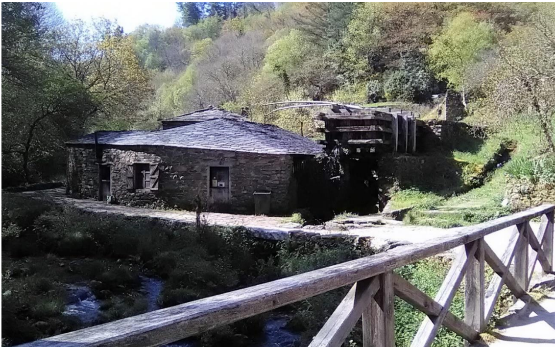
Foto 26: Instalaciones de Mazonovo (Santa Eulalia). Se aprecia el banzao de madera. Fotografía propia.
