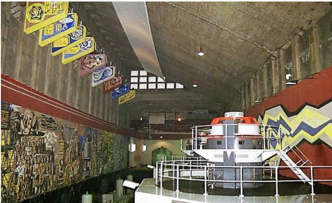
Foto 16: Sala de turbinas. Fuente: Ayuntamiento de Grandas de Grandas de Salime. http://www.grandasdesalime.es/index.php?M1=3&M2=45&CT=7&SC=15&PG=3 ) Consultado el 4 de junio de 2018.
