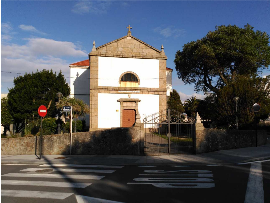
Figura 14.- Edificio de la Iglesia Parroquial de San Pedro de Visma – A Coruña; el edificio original de esta parroquial no estaba en este lugar durante el período analizado, sino otro punto de este ámbito territorial. 174
