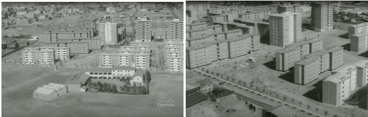
Fig. 24. Vistas aéreas del Gran San Blas (8:25 min) y Fig. 25. Vistas aéreas del Gran San Blas (8:34 min) del documental “Sesenta mil viviendas. Plan de Urgencia Social de Madrid”. Fuente: NO-DO
