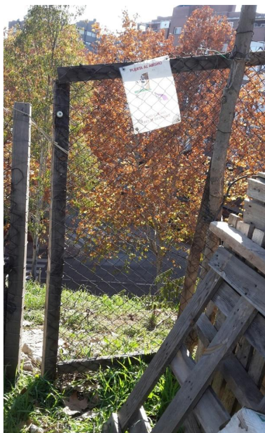
Ilustración 18. Puerta con el cartel "Puerta al abismo", que avisa del terraplén.
