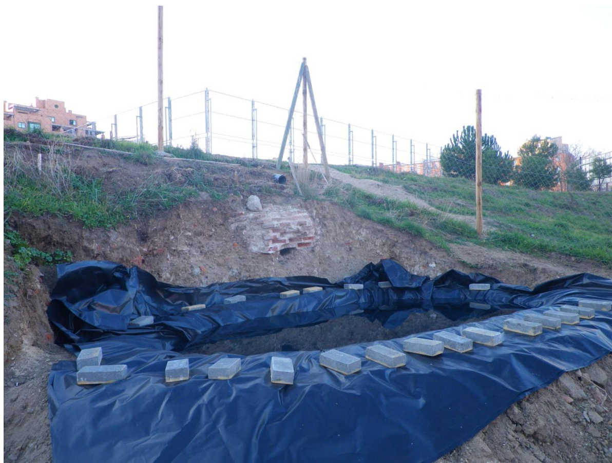
Ilustración 22. Construcción del estanque que abastece de agua de lluvia al bosque comestible
