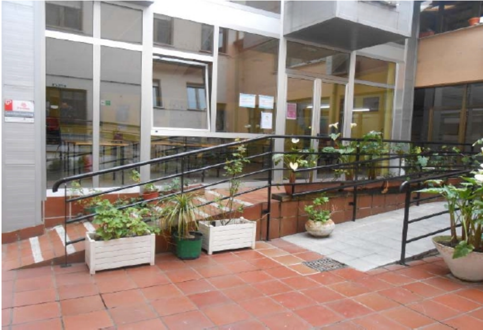
Patio interior y entrada al centro de día del albergue Cano Mata
