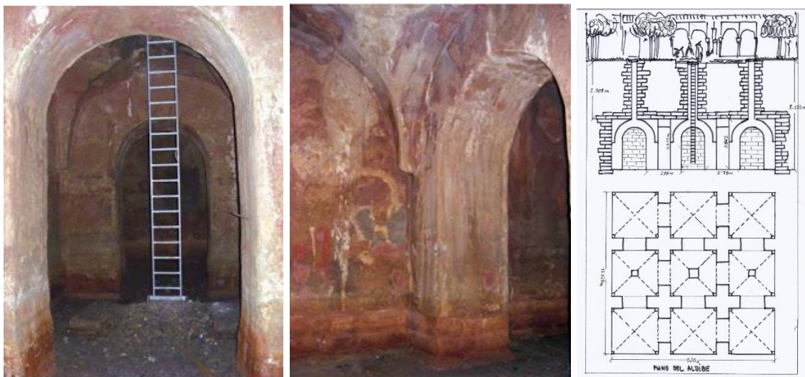
23. Entrada practicada al aljibe.
