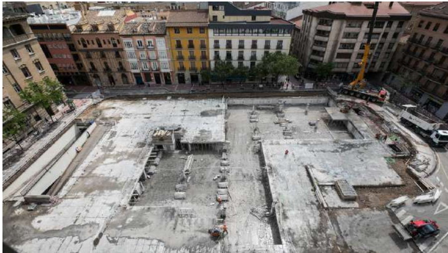
Fig. 9.1 Obras en la Plaza. Fuente: Heraldo de Aragón.
