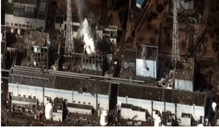
Figura 21. Imagen de Satélite el 16 de marzo de 2011, 5 días después del terremoto, de los cuatro edificios del reactor dañado. Reproducido de: http://es.wikipedia.org/wiki/Accidente_nuclear_de_Fukushima_I . Creative Commons CC BY-SA 3.0
