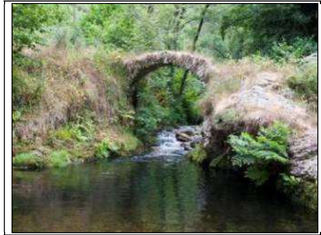
Puente de Vallina (Nueva de Llanes). Foto: J. Velasco
