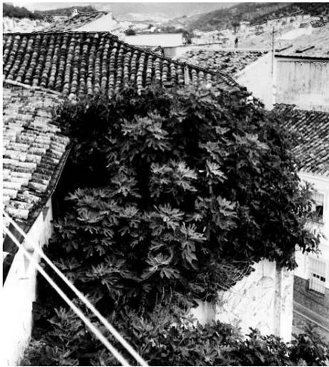
Fig. 9. Cubiertas y patio de la calle San Francisco (patio Oeste). Las plantas que habían crecido libremente debido al abandono del edificio alcanzaron porte arbóreo en el caso de las higueras, siendo un factor de deterioro de primer orden. Fotos de 2002.
