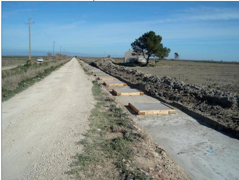
Foto 4: Zapatas de cimentación terminadas.
