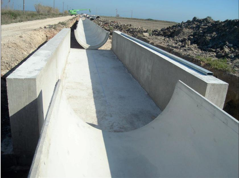
Foto 8: Detalle de la alineación de la canaleta prefabricada de hormigón armado.
