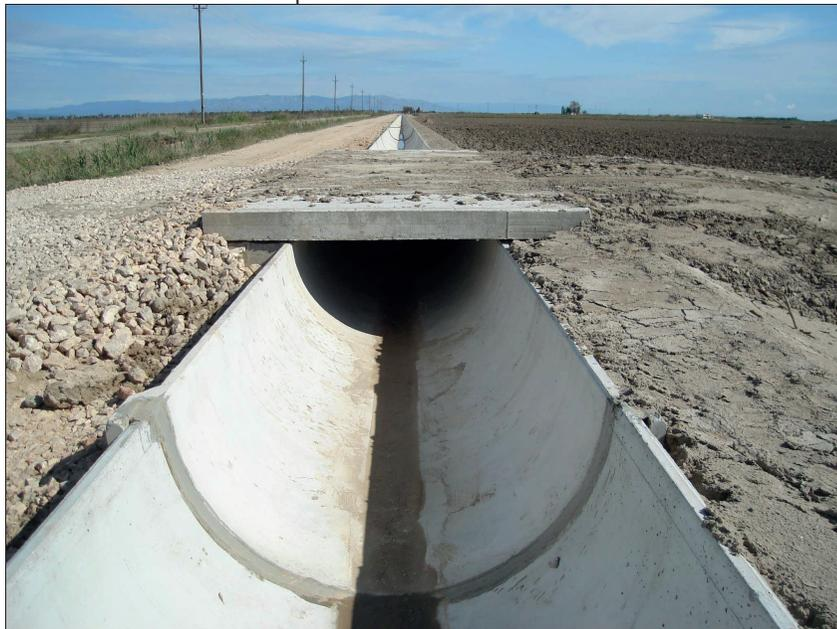
Foto 12: Detalle apoyo canaleta de sección parabólica en zapata.
