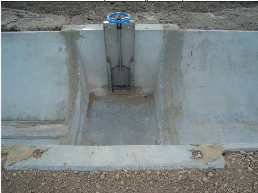
Foto 15: Detalle de arqueta simple de hormigón armado con salida de tubo a finca.
