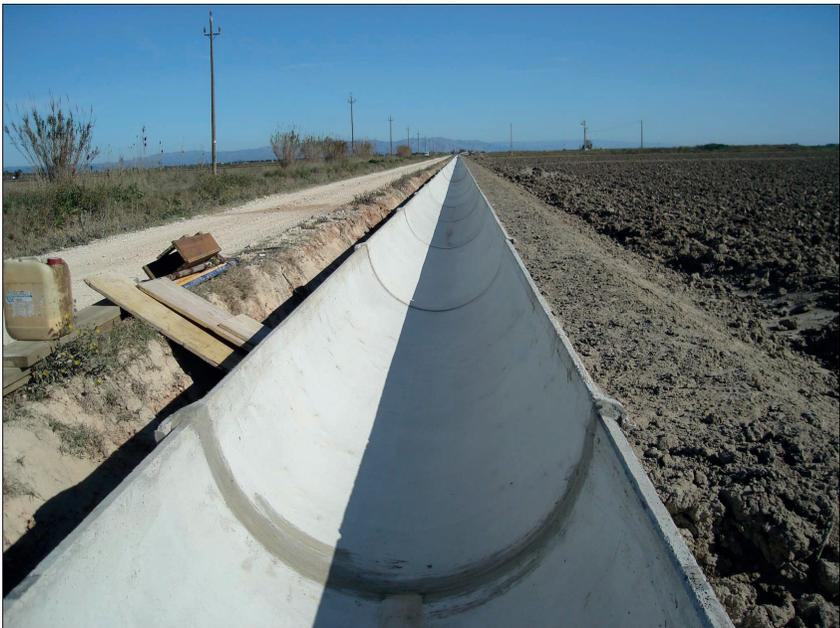
Foto 9: Unión de canaleta con un puente. Se ve que se ha marcado el nivel para rellenar de hormigón el fondo del puente para que esté al mismo nivel que el interior de las canaletas.
