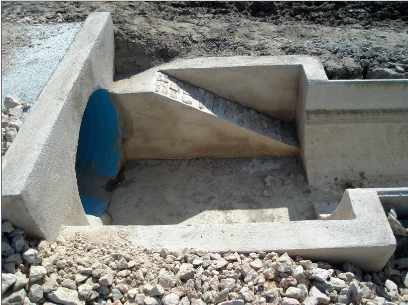
Foto 11: Puente-losa de hormigón armado de 9 m. de longitud sobre la acequia de sección semicircular para acceso a finca desde el camino de servicio.
