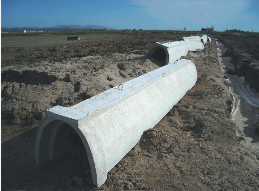
Foto 2: Preparación para asiento de la acequia prefabricada.
