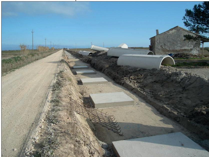
Foto 5: Nivelando las gravas existentes entre las zapatas de hormigón armado.
