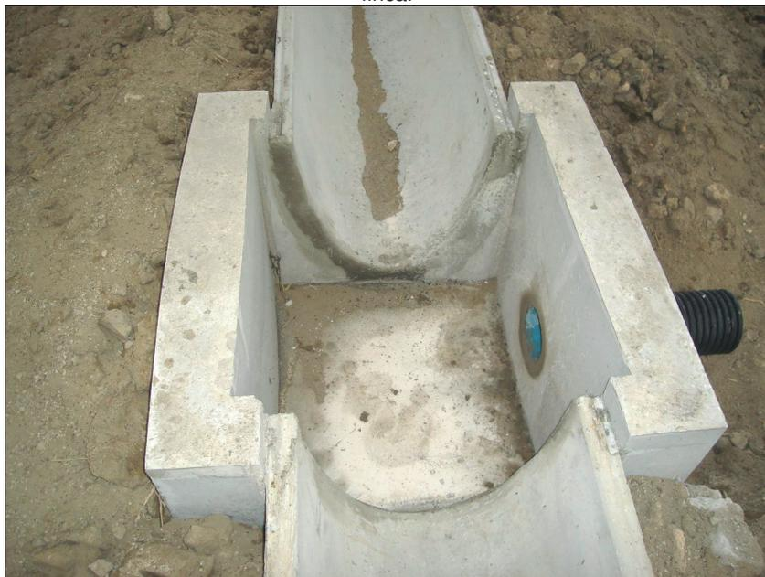
Foto 16: Detalle de arqueta de unión de dos tramos a 90°.
