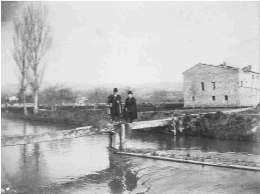
Principio del S. XX. Posiblemente, estudio del canal de riego, anterior a 1910 (EMP).
