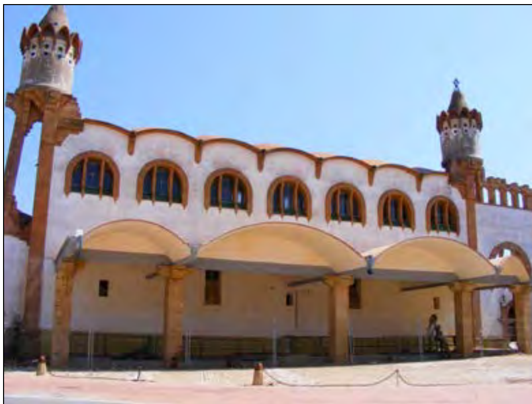
FIG. 10.9. El celler cooperatiu de Gandesa (Terra Alta). Cortesia de hilberg.
