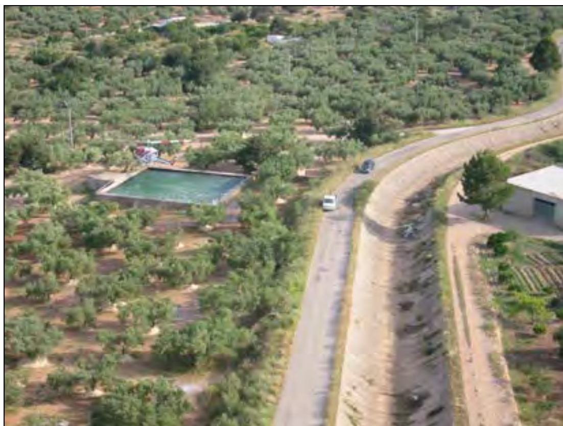
FIG. 12.1. Canal Xerta-Sénia a l'altura del municipi de Tortosa, camí de servei i una bassa utilitzada com a punt de captació d'aigua.
