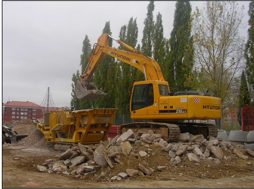
Fig. 12. Retro-excavadora de cadenas.
