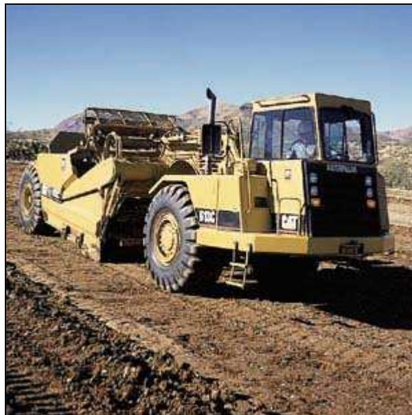
Fig. 3. Relleno efectuado con moto-traílla.
