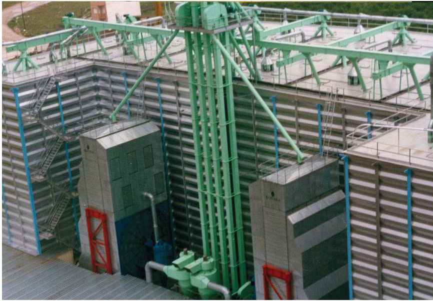
8. Dos unidades secadoras adosadas a los silos cuadrangulares en la Cámara Arrocerca de Amposta (Tarragona)
