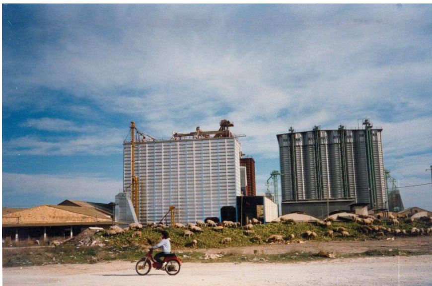
9. Dos silos de plancha metálica de plegado trapecial con celdas cuadradas (izquierda) y octogonales (derecha)
