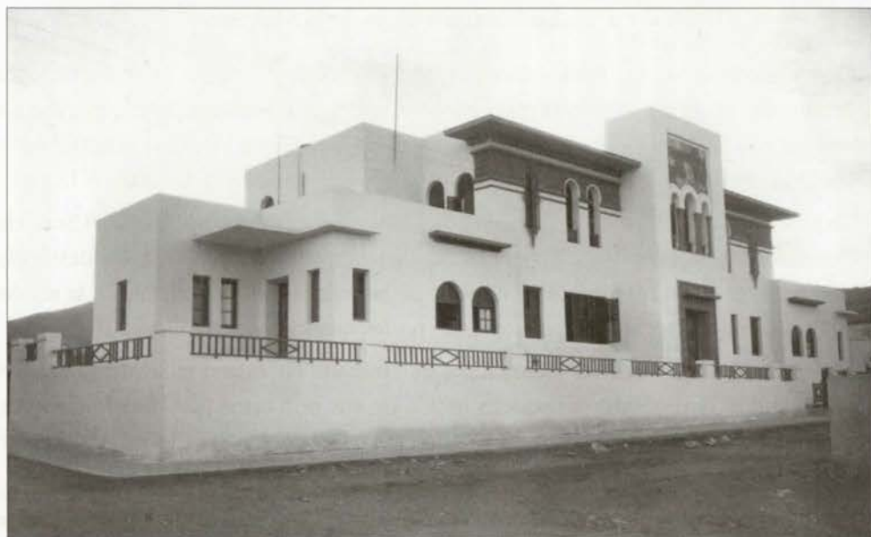
Figura nº28: Edificio de Correos, Villa Alhucemas
