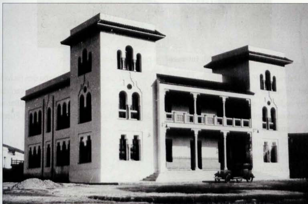
Figura nº19: Intervención regional, finales años veinte, Villa Alhucemas
