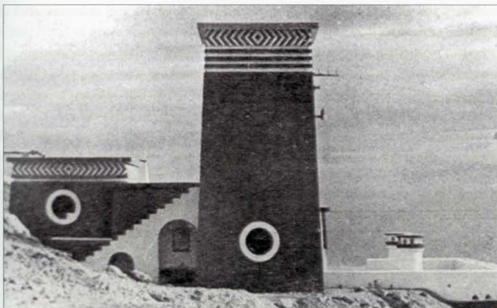
Figura n°32: Estación elevadora, Villa Alhucemas
