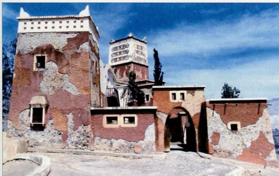
Figura nº5: Intervención del Arba de Taurirt.
