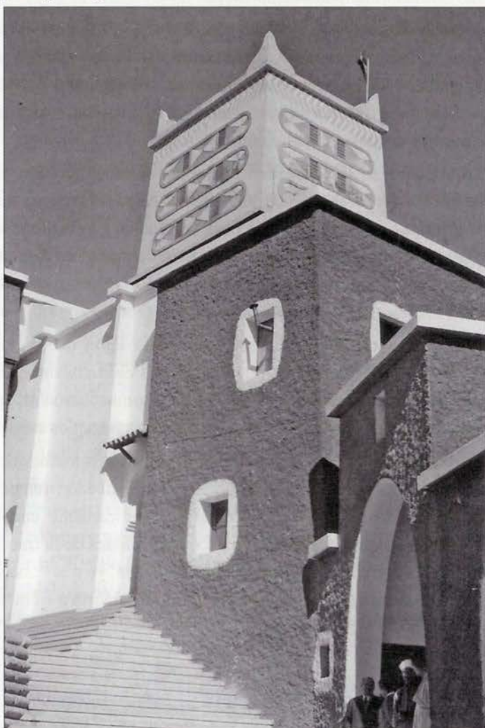
Figura nº31: Intervención del Arba de Taurirt
