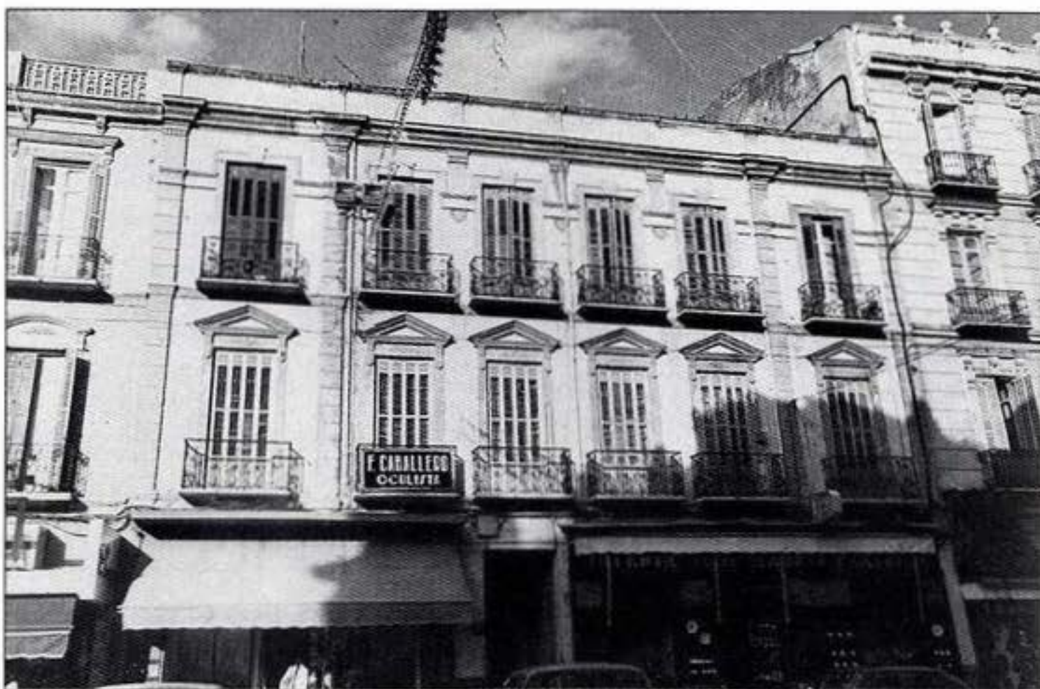
Fig. 7. Eusebio Redondo, fachada de un edificio en la Avenida 4. Estado en 1980 del edificio. APFC.
