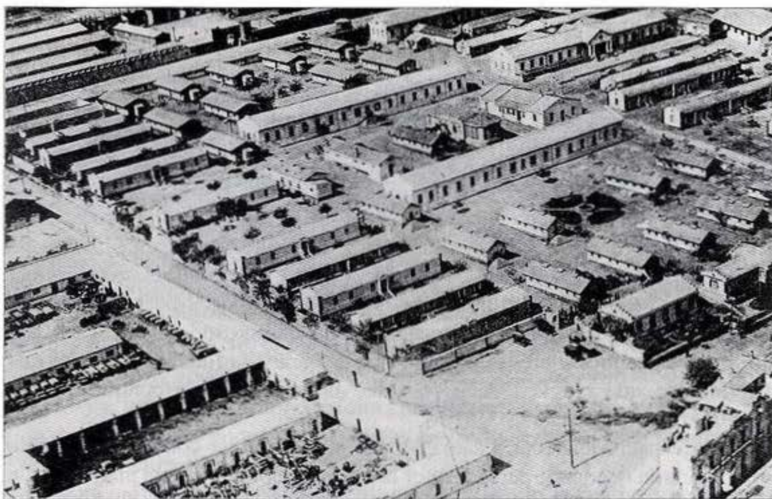
Fig. 24. Vista aérea del hospital Docker, años veinte. APAB.
