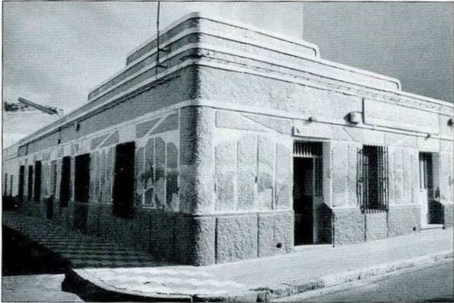
Fig. 219. Casa en la calle Orense nº 20-22. 1988. APAB.
