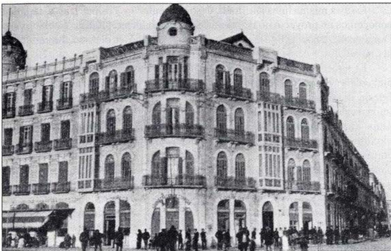
Fig. 103. Edificio en la plaza de España, antiguo de Correos, 1916. APAB.
