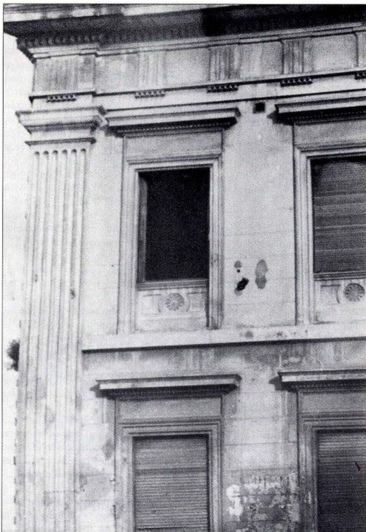
Fig. 140. Jorge Palanca. Instituto General Técnico, detalle de fachada, 1960. APAB.
