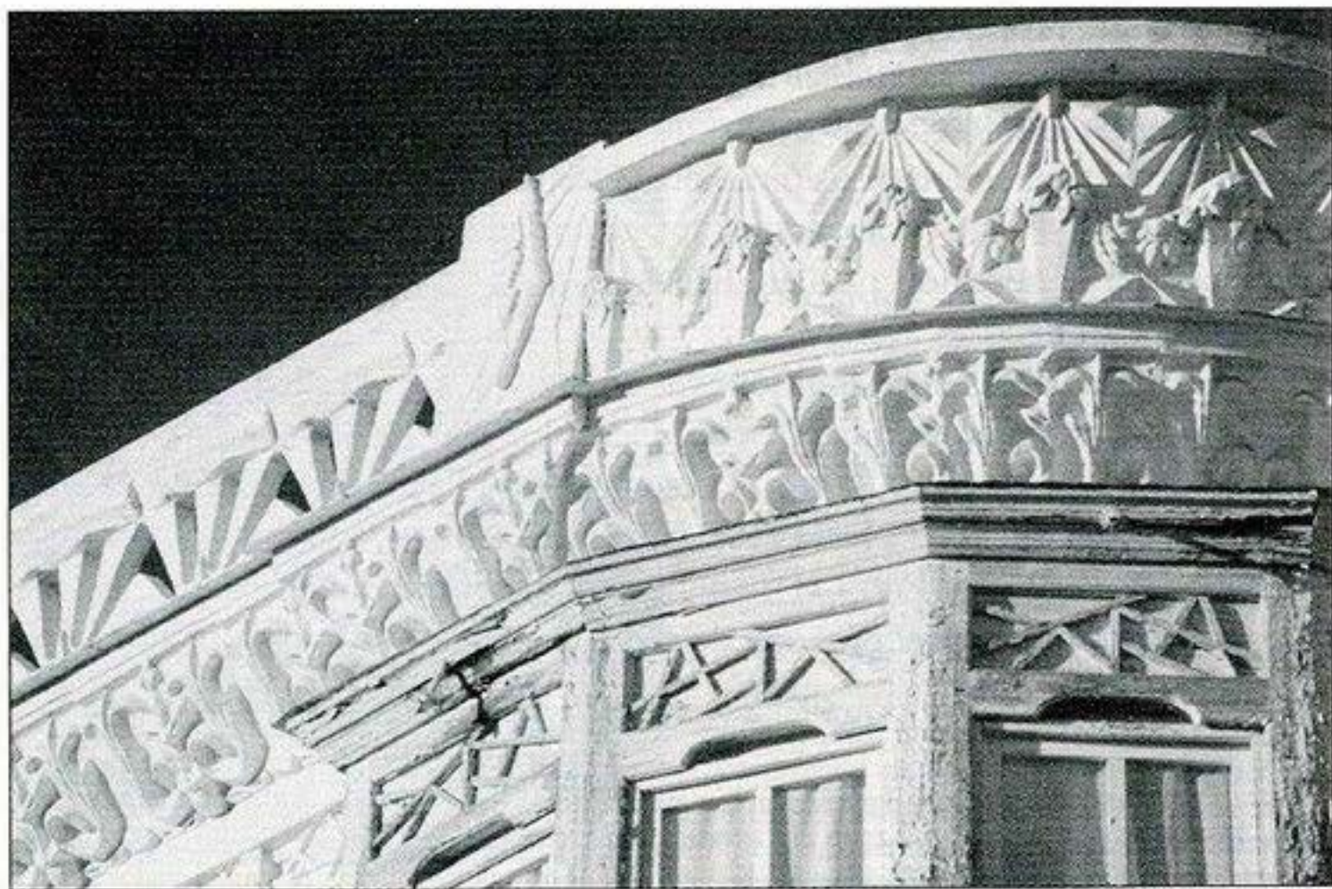
Fig. 170. Detalle de la cornisa. APAB.
