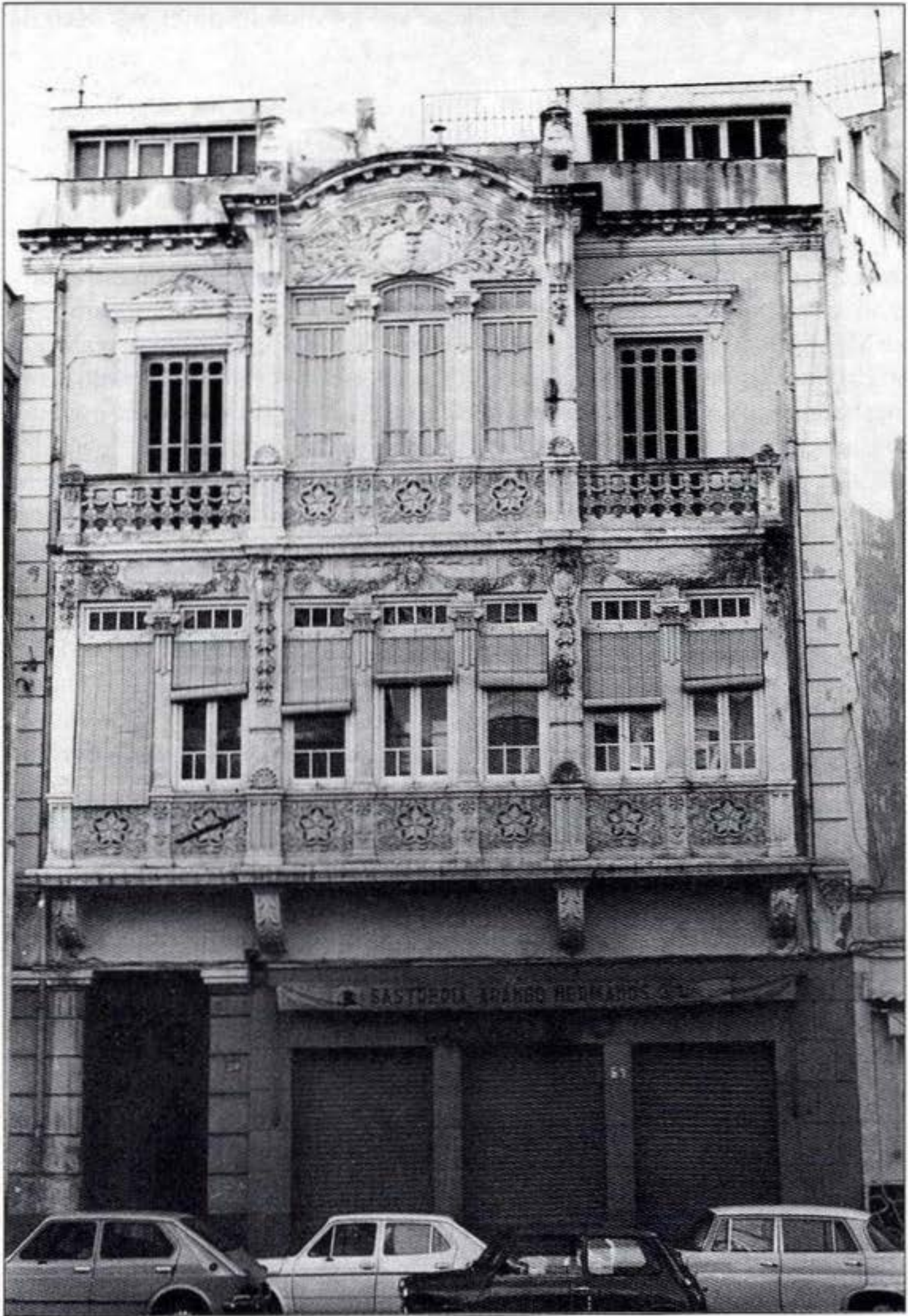
Fig. 114. Edificio en la calle López Moreno nº 20. 1985. APFC.
