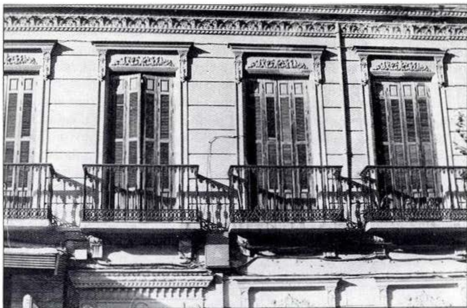
Fig. 6. Rodríguez Borlado, detalle de fachada de un edificio para Isaac Benarroch, 1907. APAB.
