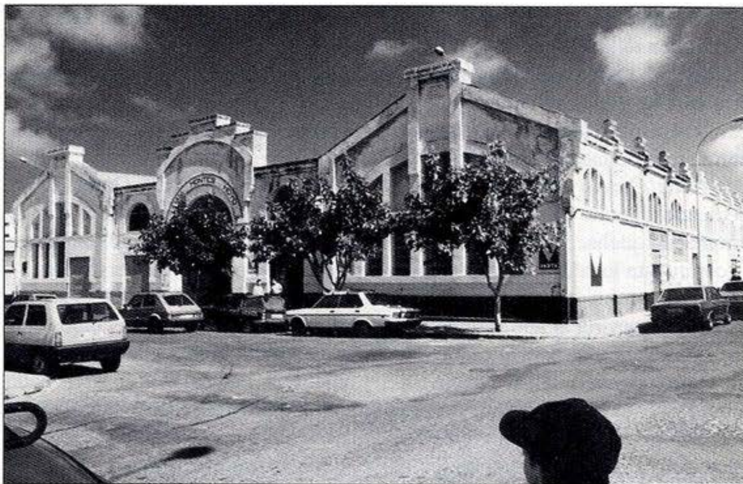
Fig. 125. Enrique Nieto. Almacenes Montes. 1991.APSG.
