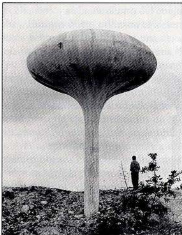
Fig. 15. Julio de Castro Núñez, depósito de agua de la Granja, 1995. APAB.
