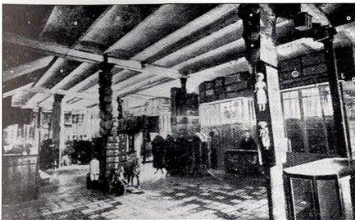
Fig. 7. Techo de bovedillas tabicadas, 1916. Calle Plaza Menéndez y Pelayo, edificio «La Reconquista». APAB.
