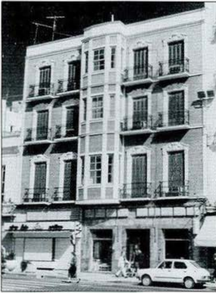
Fig. 233. Enrique Nieto. Edificio en la Avenida nº 26. 1988. APAB.
