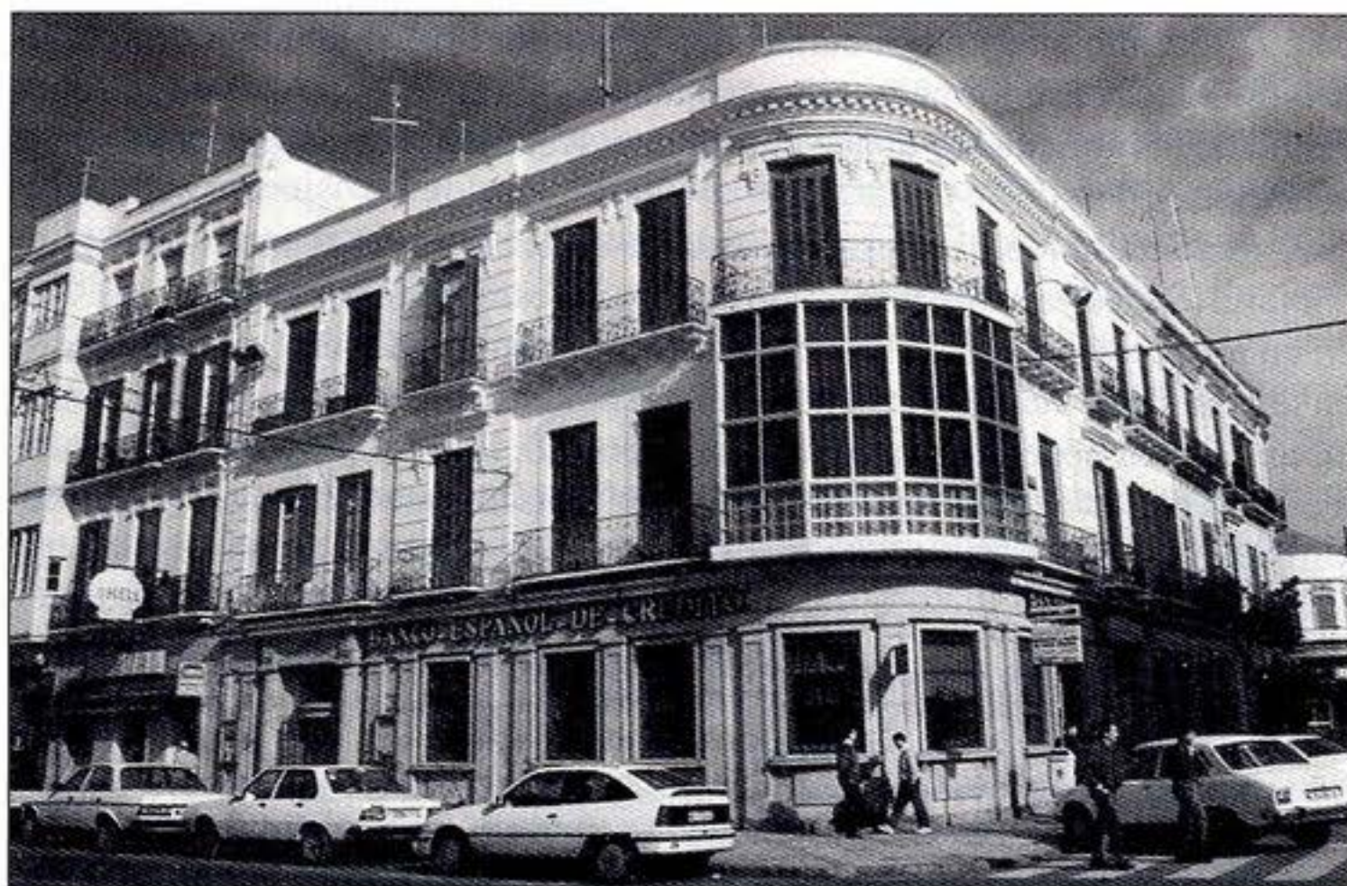
Fig. 16. Vista de 1990 del edificio. APAB.
