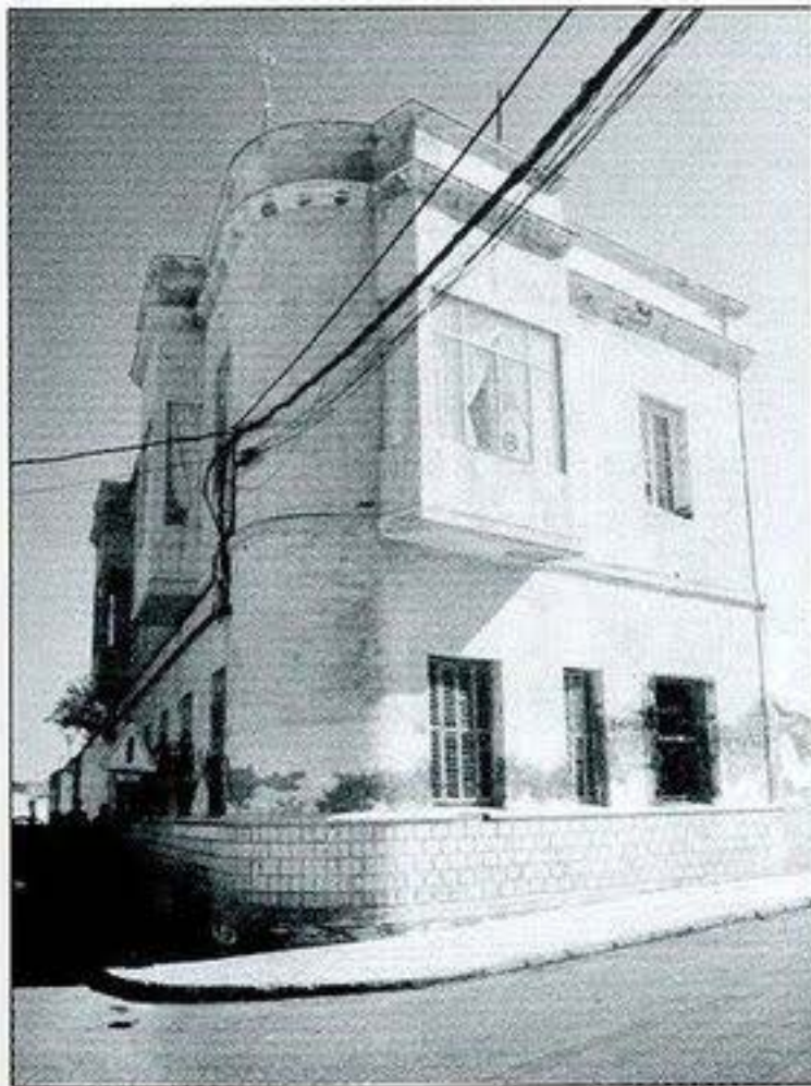
Fig. 206. Edificio en la ampliación de Huerta Cabo s.n. 1990. APAB.
