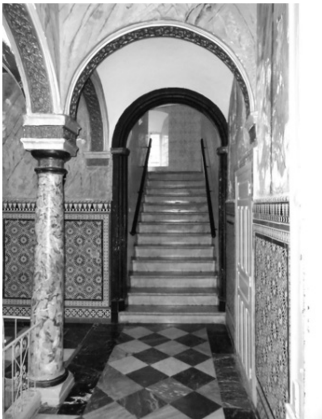
10. Columna y escalera, estado actual
