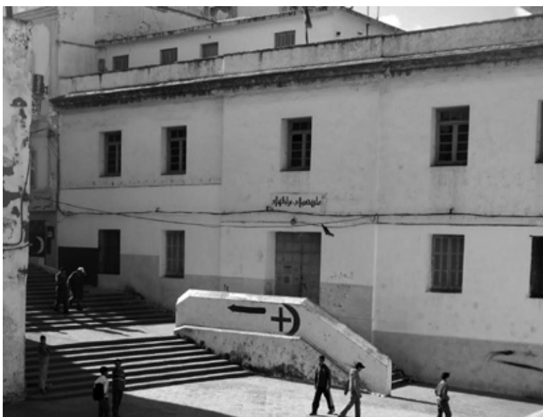
3. Estado actual del edificio. Grupo escolar Muley Abdeslam Mechich
