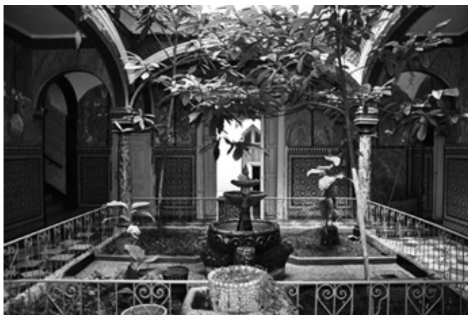
9. Patio interior de columnas, estado actual
