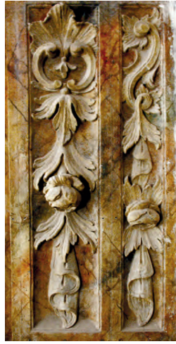
Cajeado lateral. Fotografía ABN.
